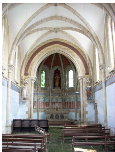
Pont-l'Abbé, chapelle du Sacré-Coeur : vue axiale est Phot. Gwénaél Fauchille IVR53_20082905896NUCA
