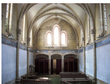
Pont-l'Abbé, chapelle du Sacré-Coeur : vue axiale ouest Phot. Gwénaél Fauchille IVR53_20082905897NUCA
