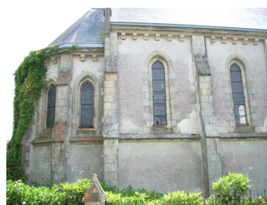
Pont-l'Abbé, chapelle du Sacré-Coeur : chevet vu du sud Phot. Gwénaél Fauchille IVR53_20082905895NUCA
