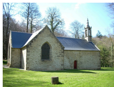
Vue générale nord-est, état en 2008. Phot. Gwénaél Fauchille IVR53_20082905612NUCA
