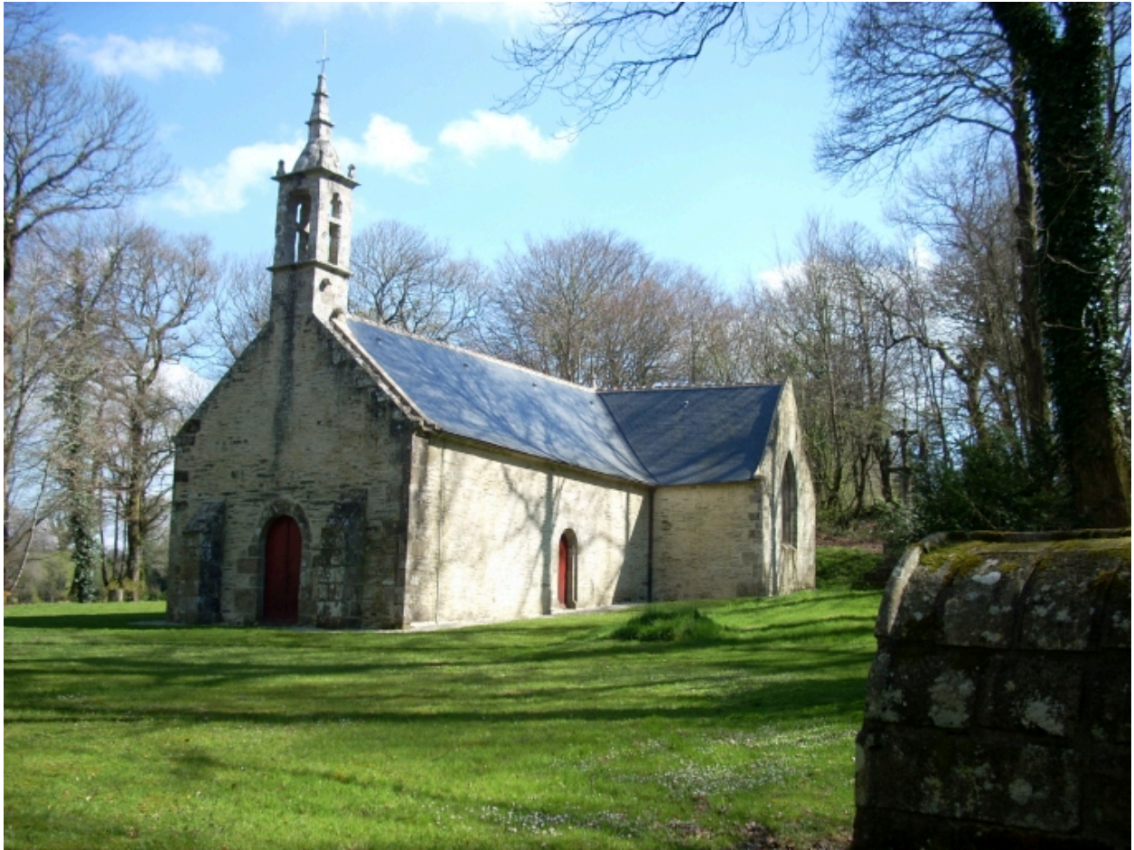
Vue générale sud-ouest, état en 2008.
