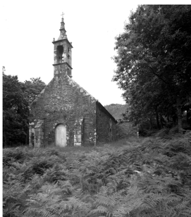
Vue générale sud-ouest en 1966. Phot. François Dagorn IVR53_19662900142V
