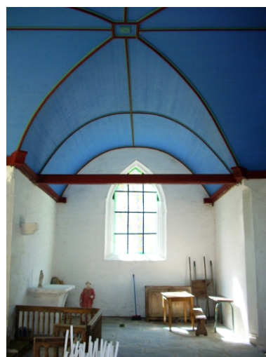
Bras sud du transept, état en 2008. Phot. Gwénaél Fauchille IVR53_20082905617NUCA
