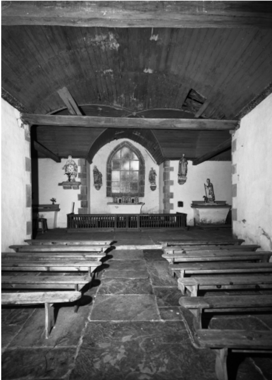
Vue générale intérieure vers l'est en 1966.
