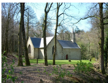
Vue générale nord-est état en 2008. Phot. Gwénaél Fauchille IVR53_20082905611NUCA
