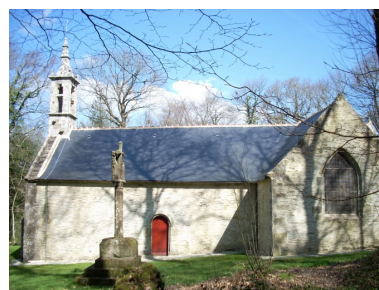
Elévation sud, état en 2008. Phot. Gwénaél Fauchille IVR53_20082905615NUCA
