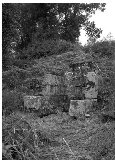
Vue générale, état en 1966. Phot. François Dagorn IVR53_19662900144V
