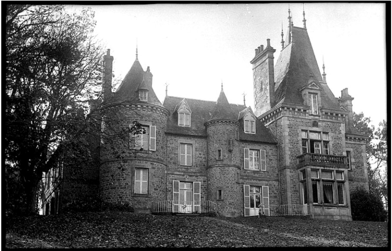
Vue générale du château, photographie noir et blanc, par Lacombe, 1ère moitié du 20ème siècle (AD 22)
