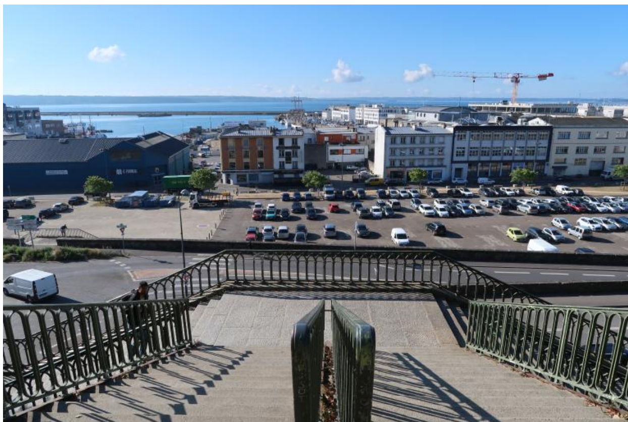
Vue du port depuis l'escalier de 1867 : garde-corps de l'escalier
