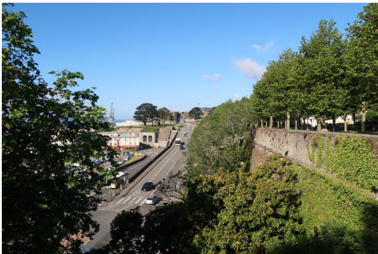
Rampe Ouest, avenue F. Roosevelt depuis le cours Dajot
