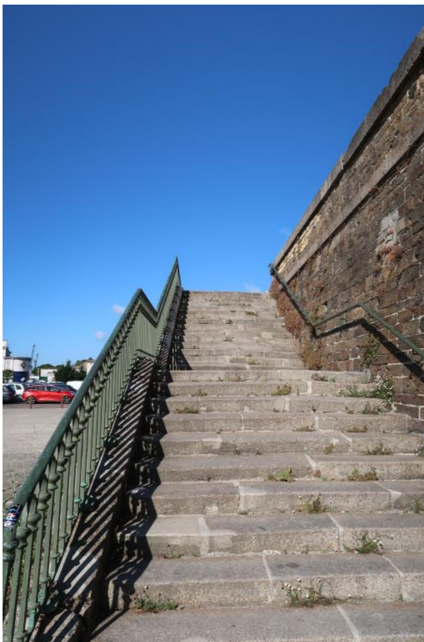
Escalier depuis le parc à chaînes vers l'avenue Franklin Roosevelt
