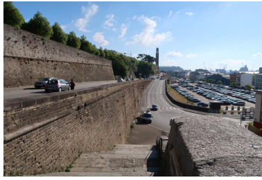
Escalier depuis l'avenue F. Roosevelt vers le parc à chaînes (côté ouest) Phot. Erwana L'Haridon IVR53_20212905934NUCA
