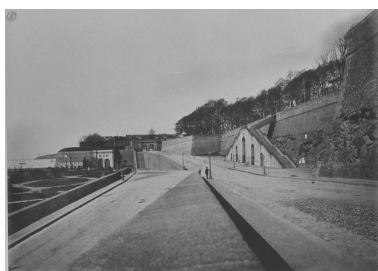
Les rampes et l'escalier de 1867 en 1873 (Jules Duclos) Autr. Jules Duclos IVR53_20202905277NUCB
