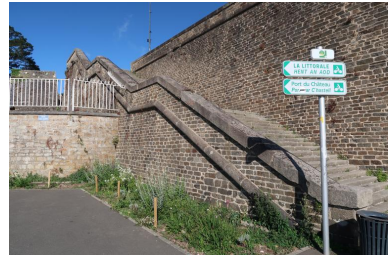
Escalier depuis l'avenue F. Roosevelt vers le parc à chaînes (côté ouest) Phot. Erwana L'Haridon IVR53_20212905935NUCA
