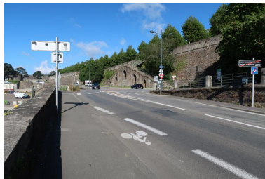
Escaliers de 1867 depuis l'avenue Salaün Penquer Phot. Erwana L'Haridon IVR53_20212905939NUCA
