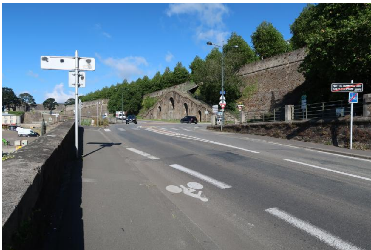
Escaliers de 1867 depuis l'avenue Salaün Penquer
