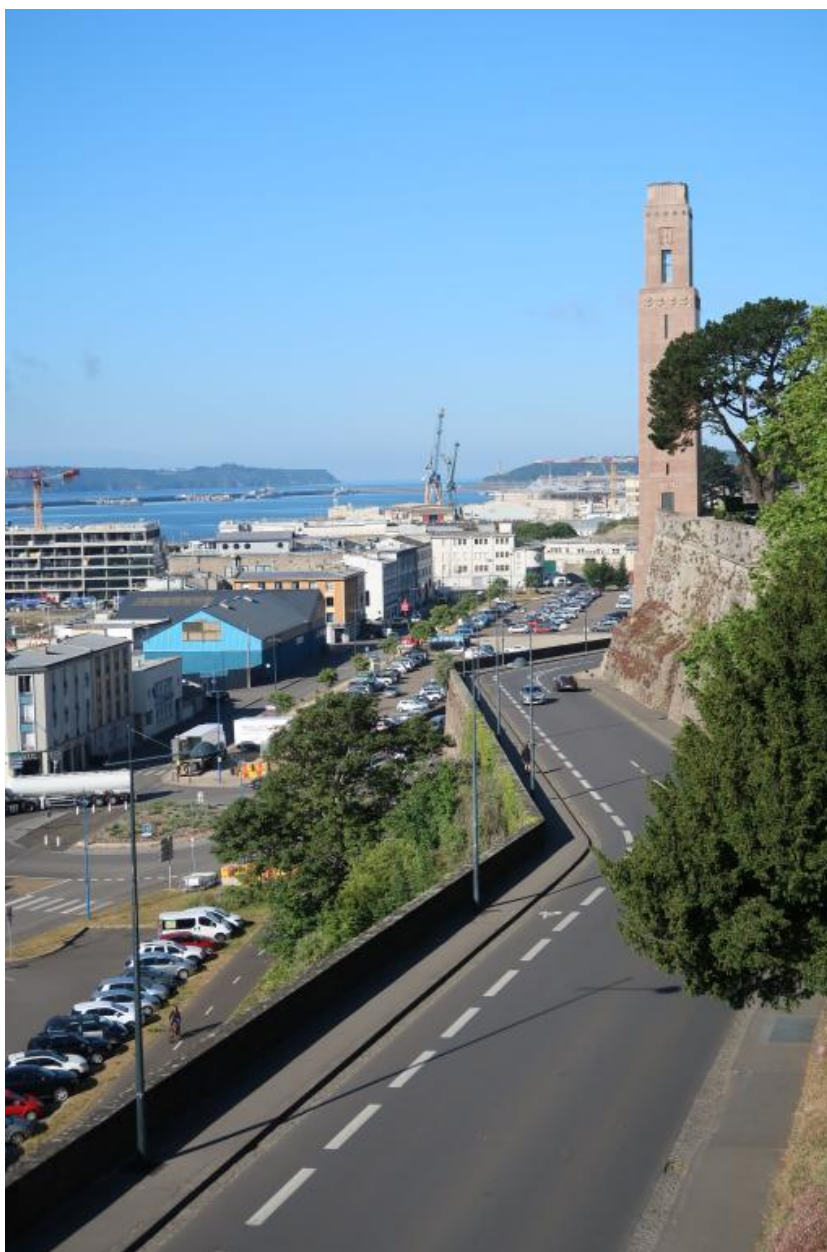
Rampe Est, avenue Salaün Penquer depuis le cours Dajot
