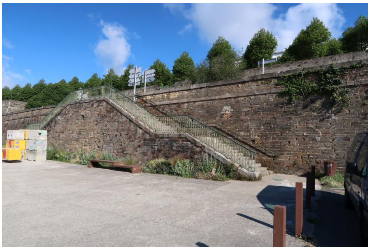
Escalier depuis le parc à chaînes vers l'avenue Franklin Roosevelt
