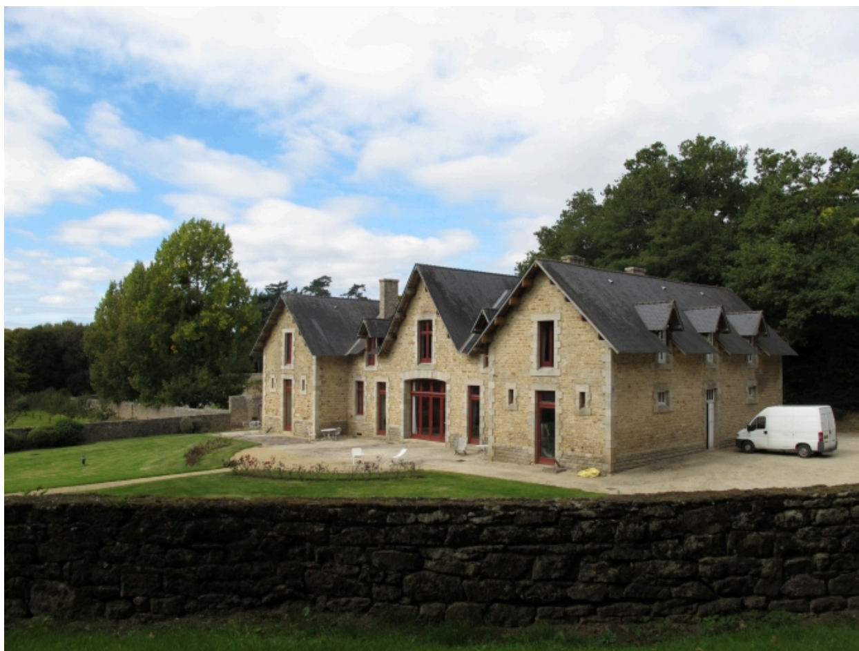
Ecuries et remise, à l'entrée du parc
