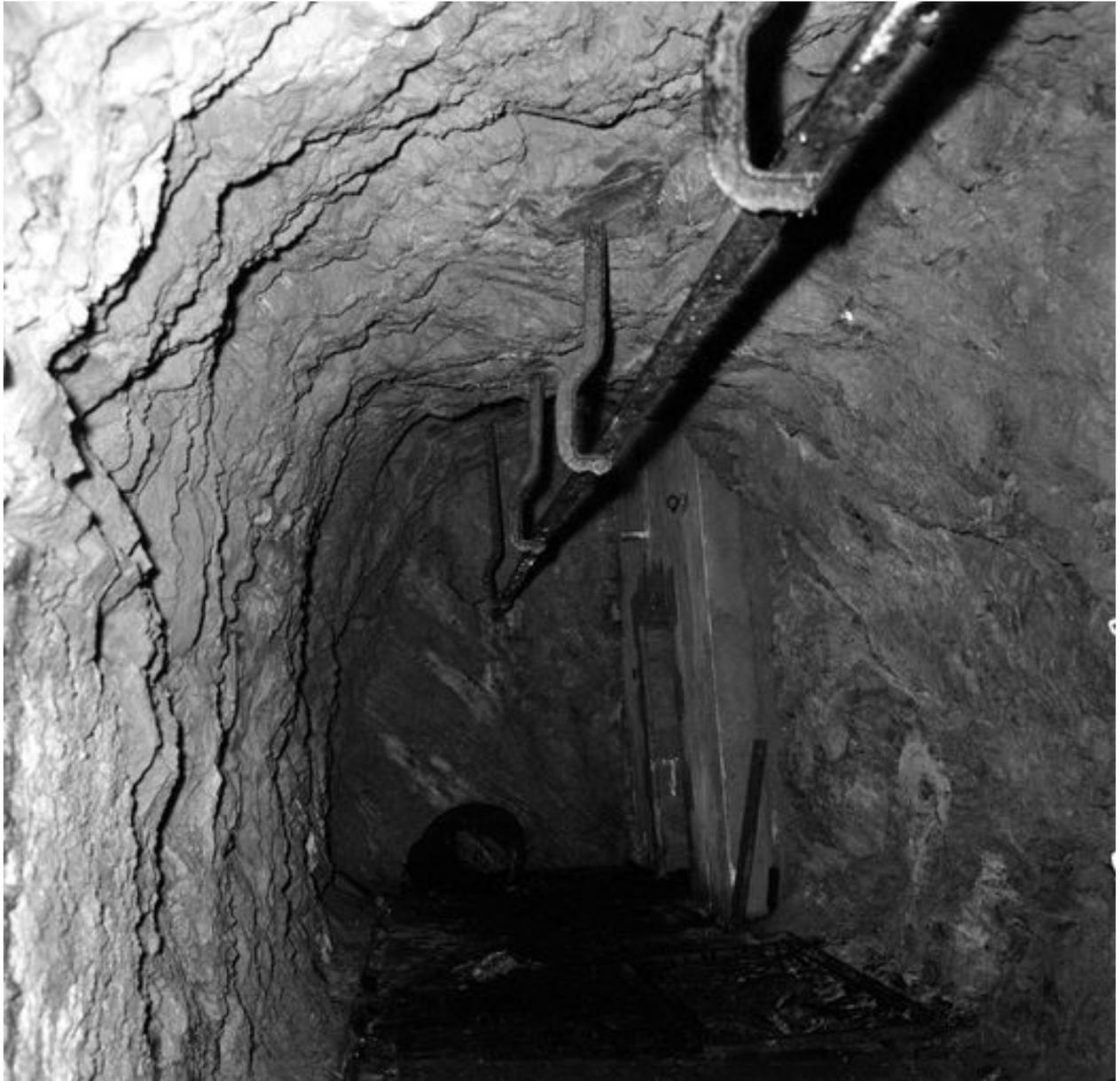
Vue de la batterie du Toulinguet en 1969 : escalier d'accès du magasin à poudre sous roc. A signaler : monorail pour le transport de munitions
