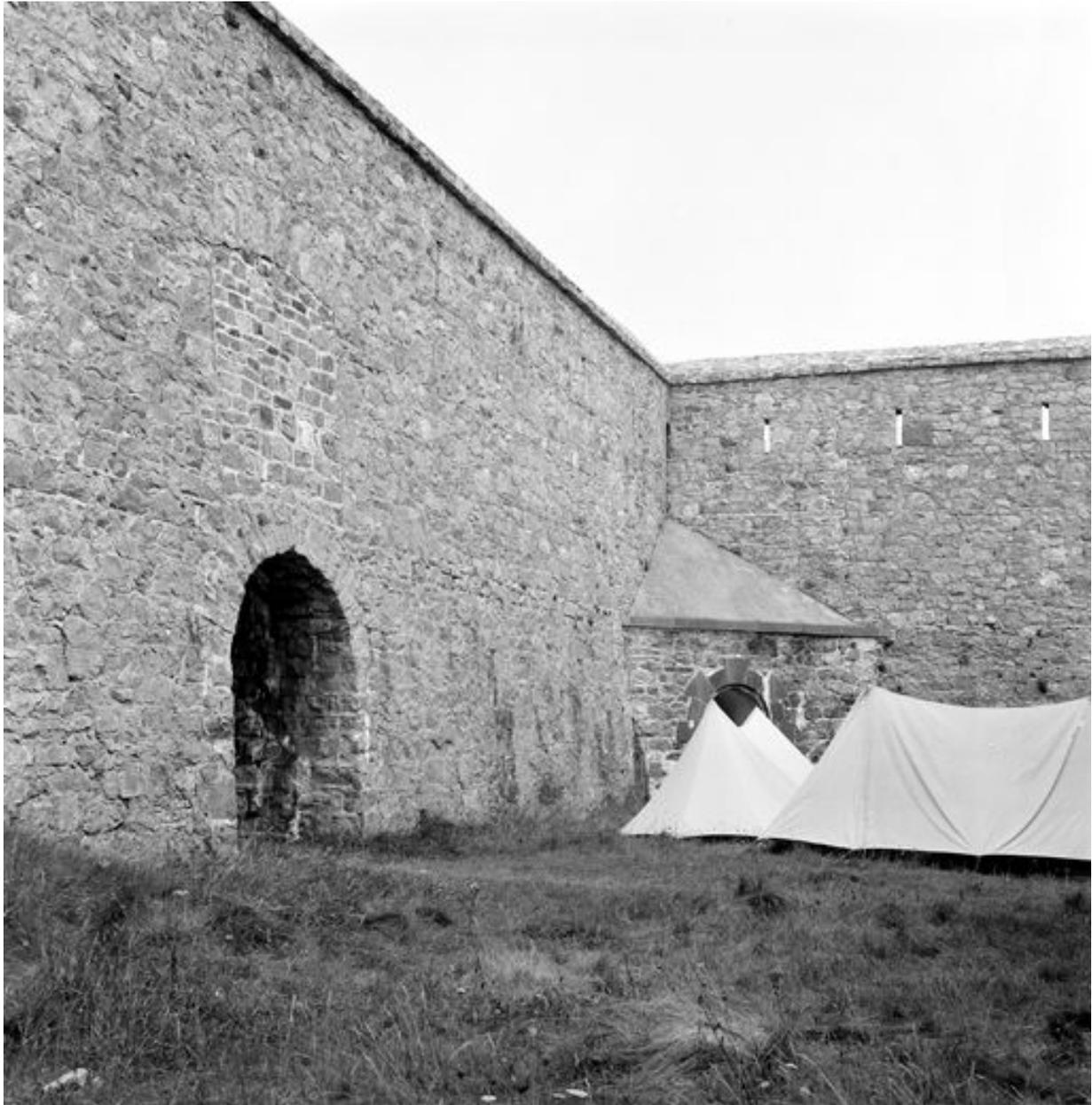
Vue de la batterie du Toulinguet en 1969 : front de gorge, poterne d'accès et débouché du monte-charge du magasin à poudre sous roc dans l'angle rentrant
