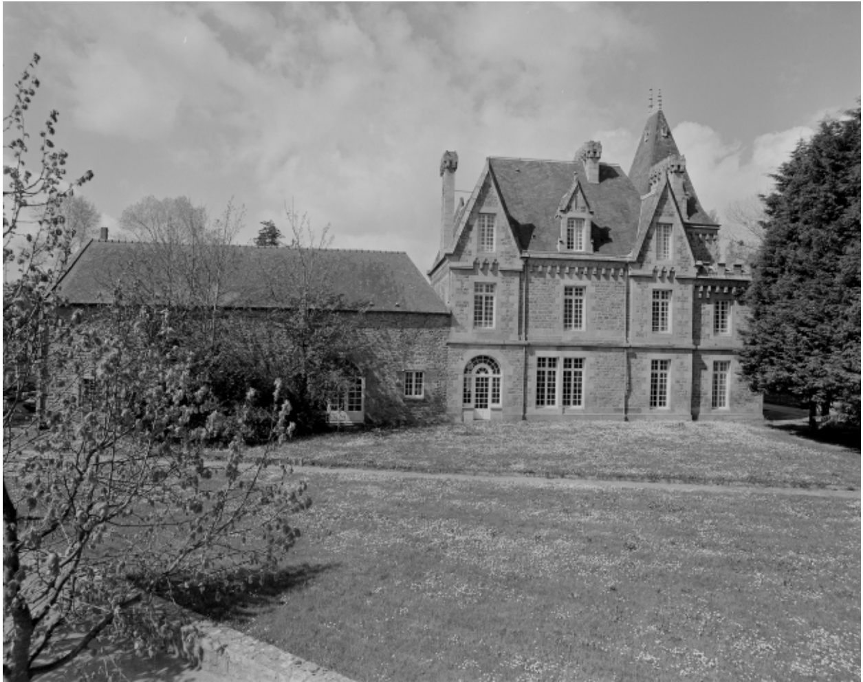
Vue d'ensemble de la façade latérale droite du logis.
