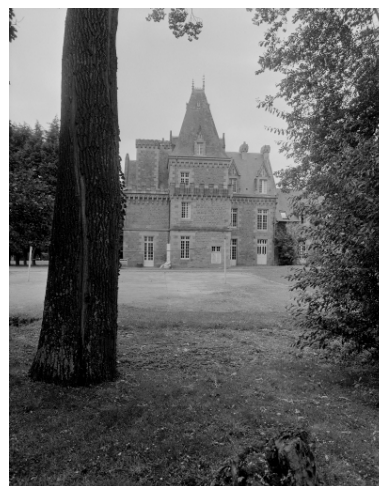
Vue d'ensemble des façades postérieures (logis - communs). Phot. Guy Artur, Phot. Norbert Lambert IVR53_19963501117X
