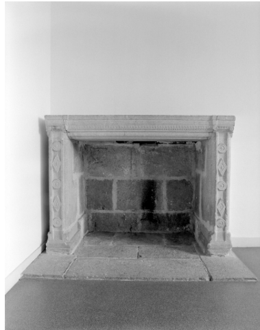
Vue générale de la cheminée, salle n°5 au 1er étage. Phot. Guy Artur, Phot. Norbert Lambart IVR53_19963501116X
