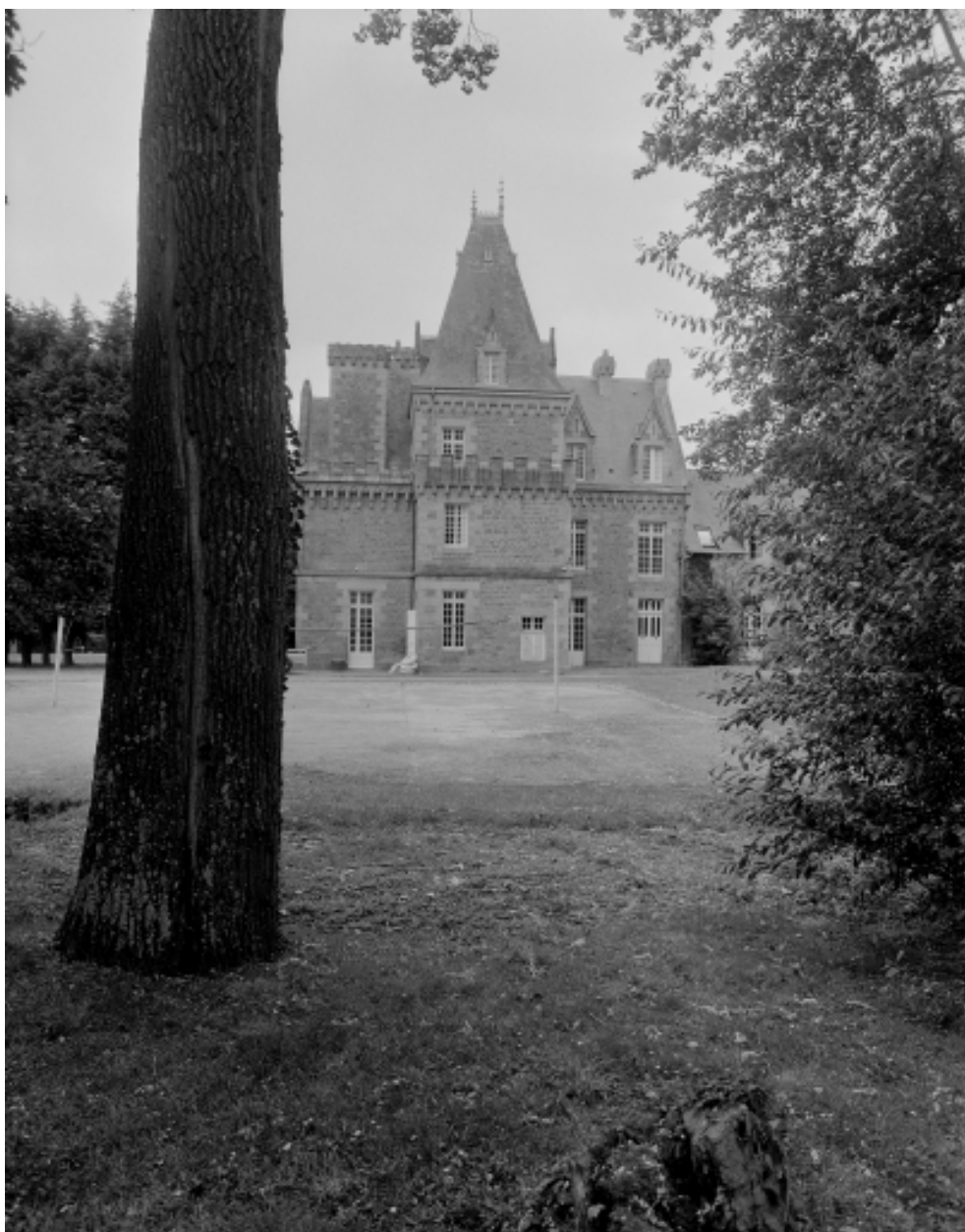
Vue d'ensemble des façades postérieures (logis - communs).
