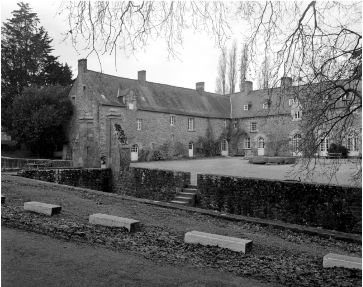
Vue générale de l'aile Ouest.
