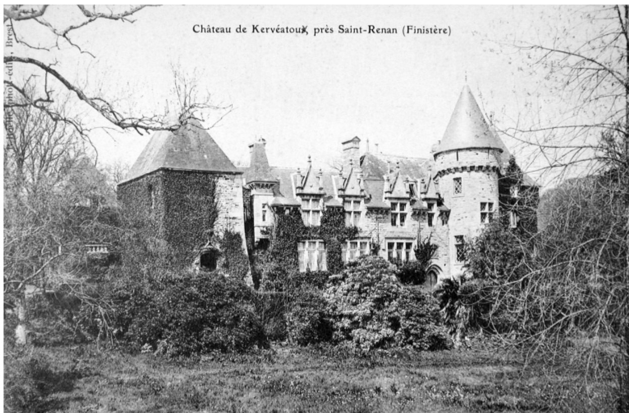
Vue sur la façade latérale est
