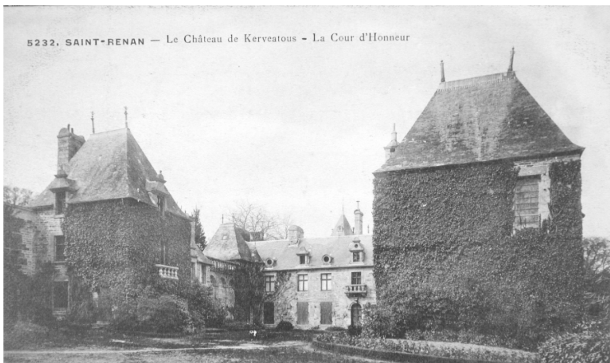
Vue sur la cour d'honneur (façade sud)
