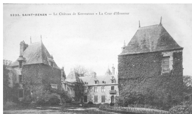
Vue sur la cour d'honneur (façade sud) Phot. Elise Lauranceau IVR53_20042905617NUCB
