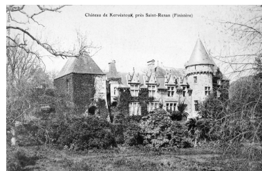
Vue sur la façade latérale est Phot. Elise Lauranceau IVR53_20042905604NUCB
