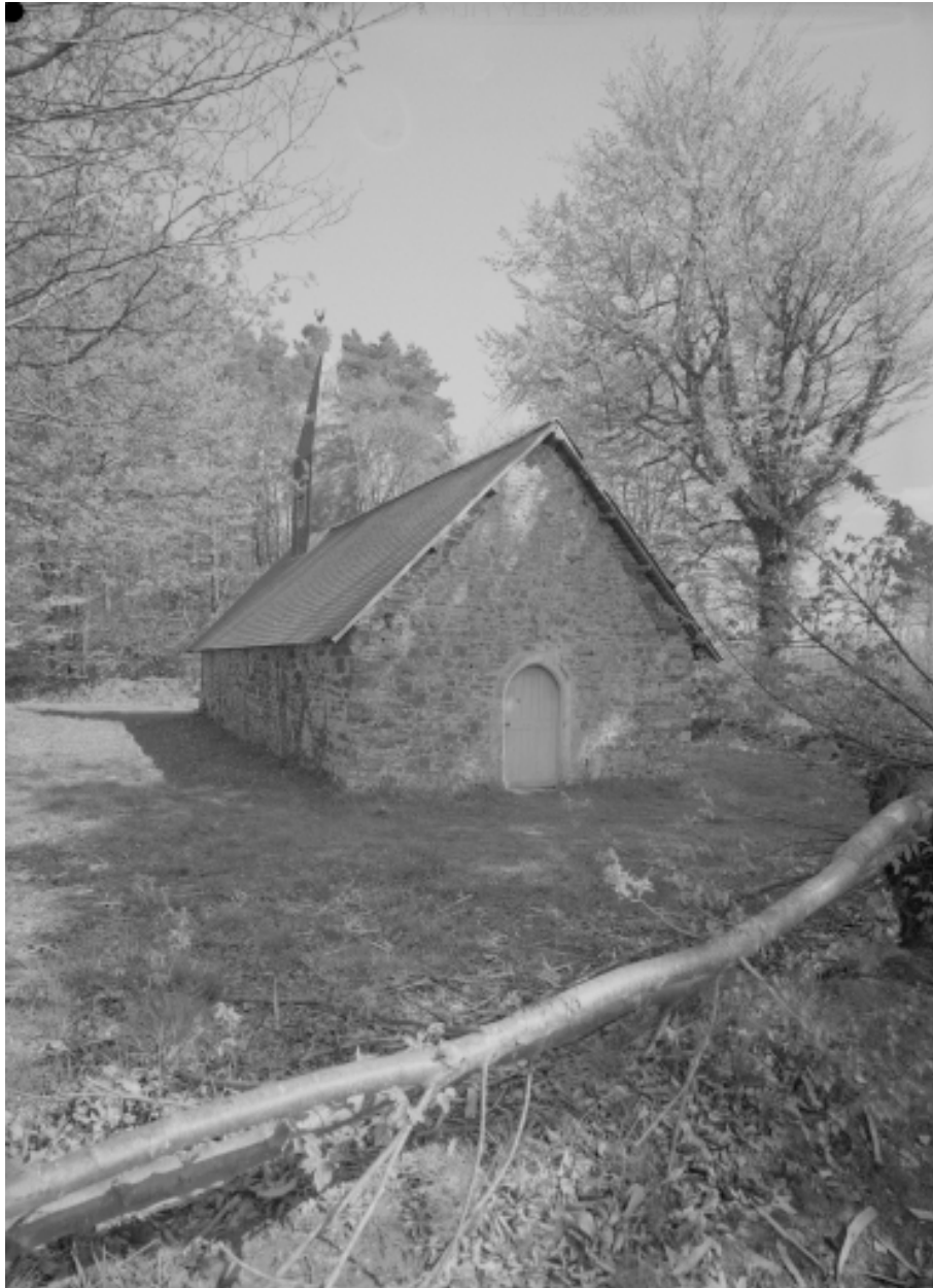
Elévation nord-ouest : vue générale
