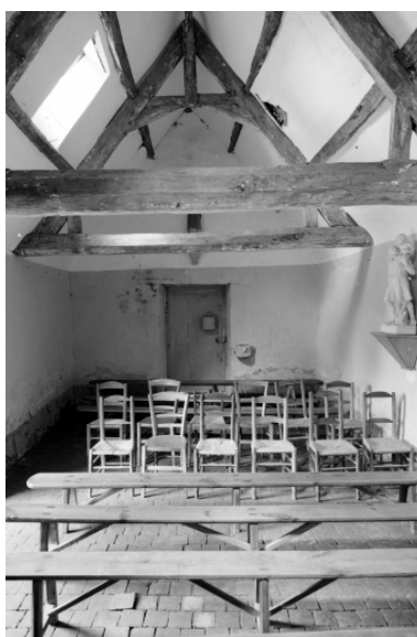
Intérieur, nef : vue générale. Phot. François Dagorn IVR53_19683500359V
