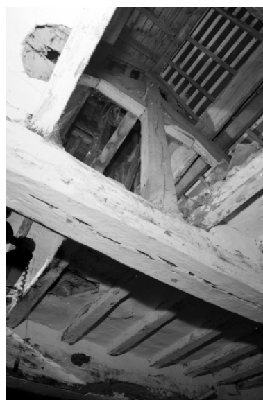
Intérieur : détail de la charpente. Phot. François Dagorn IVR53_19683500360V
