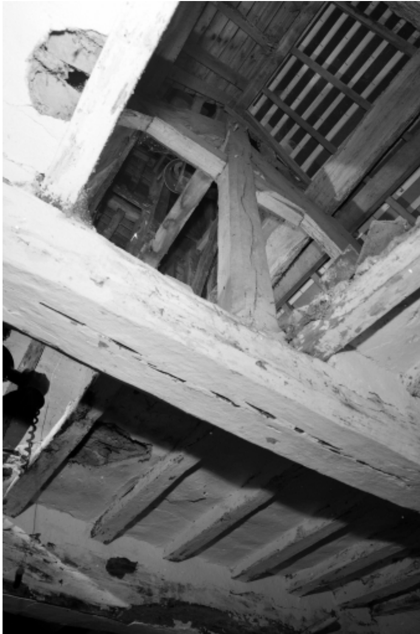
Intérieur : détail de la charpente.
