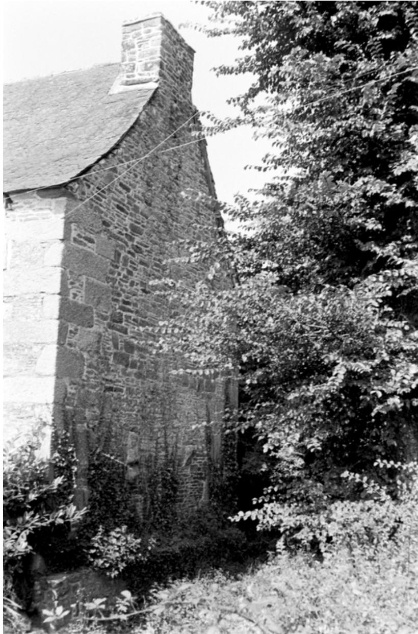
Angle sud est : détail du chaînage d'angle
