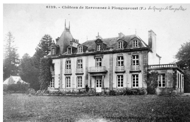
Vue générale Phot. Elise Lauranceau IVR53_20042905544NUCB
