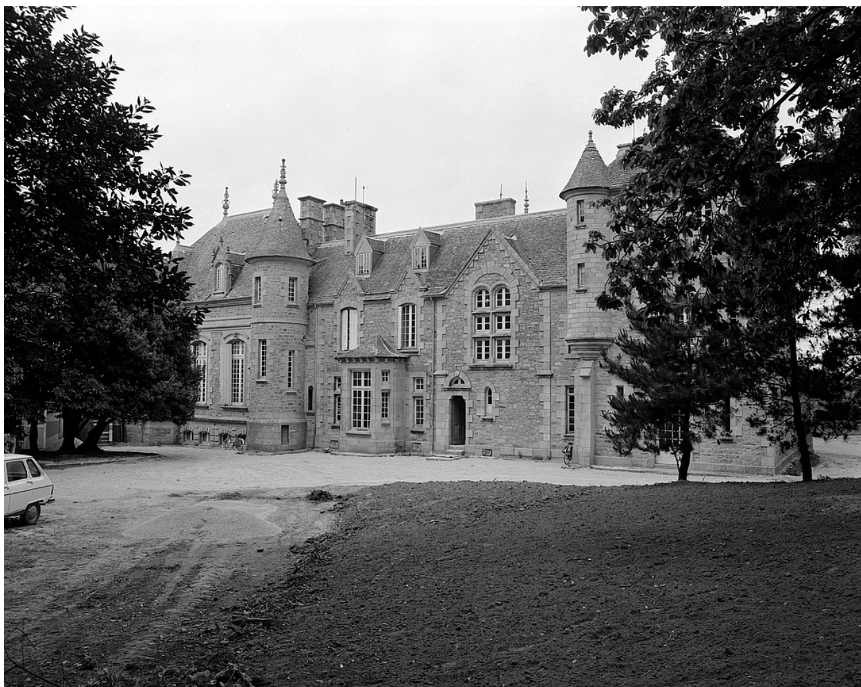
Vue générale sud
