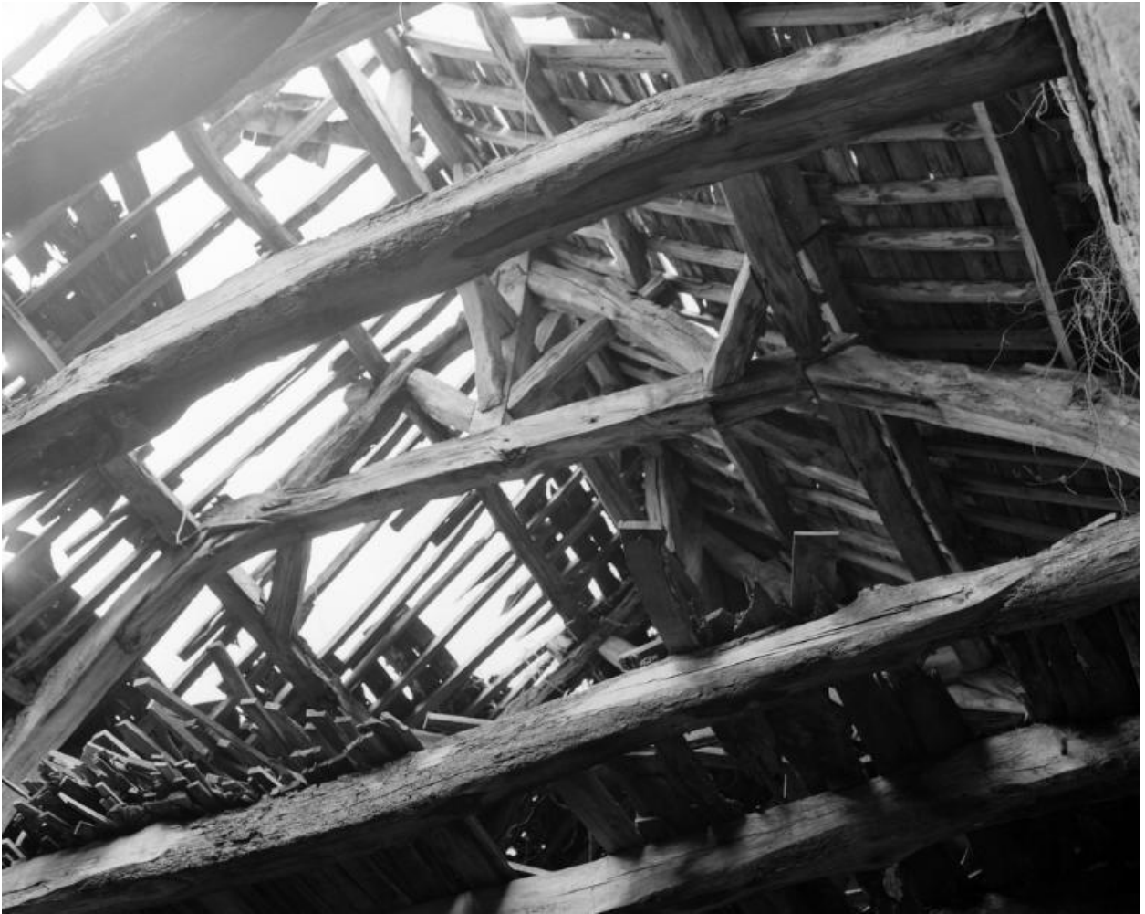
Communs, détail de la charpente.
