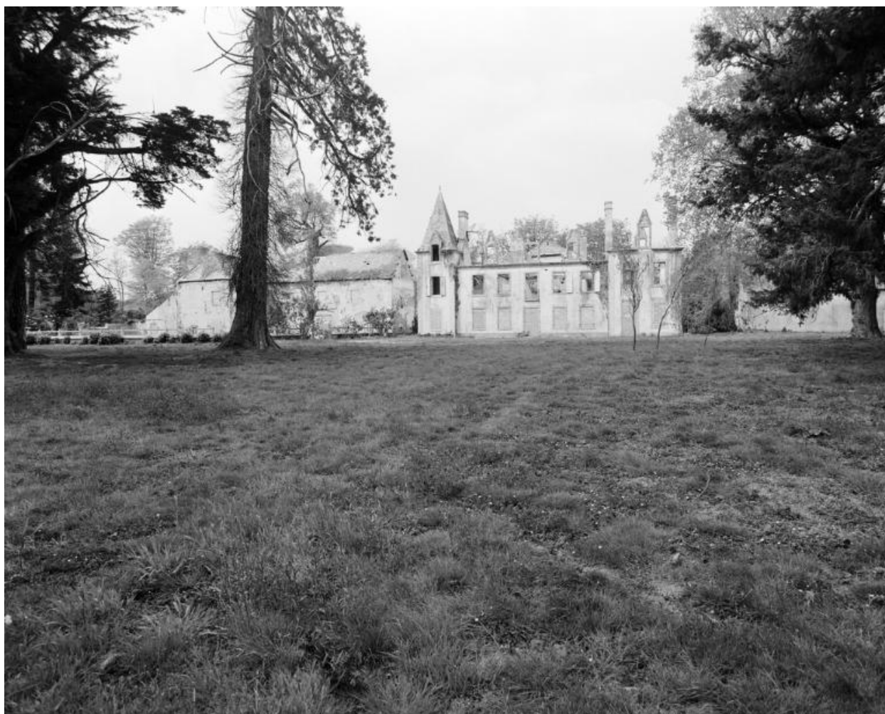
Vue de situation prise du sud.
