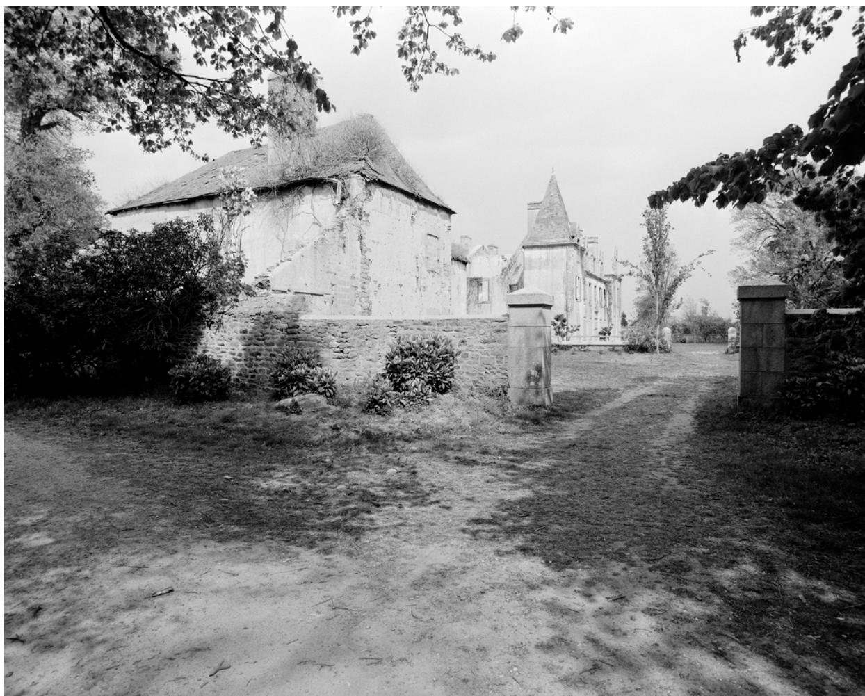
Vue de situation prise de l'ouest.
