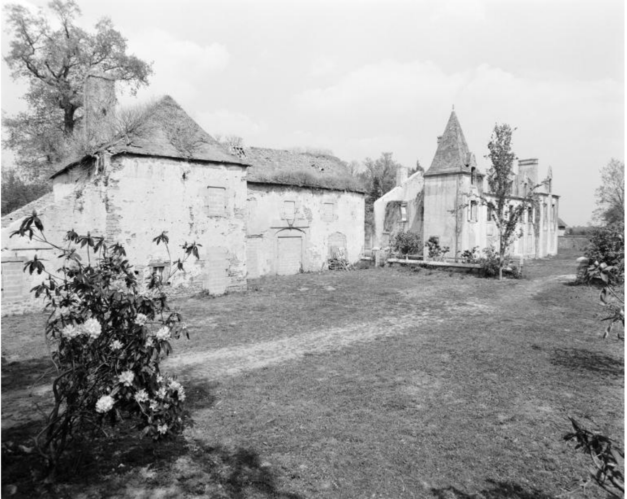
Communs, vue générale sud-ouest.
