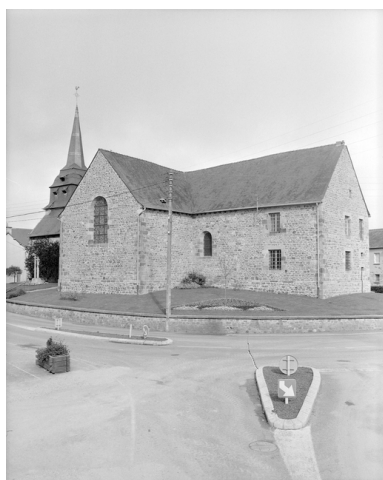
Elévation Nord-Ouest : vue générale Phot. Guy Artur, Phot. Norbert Lambart IVR53_19943500710X
