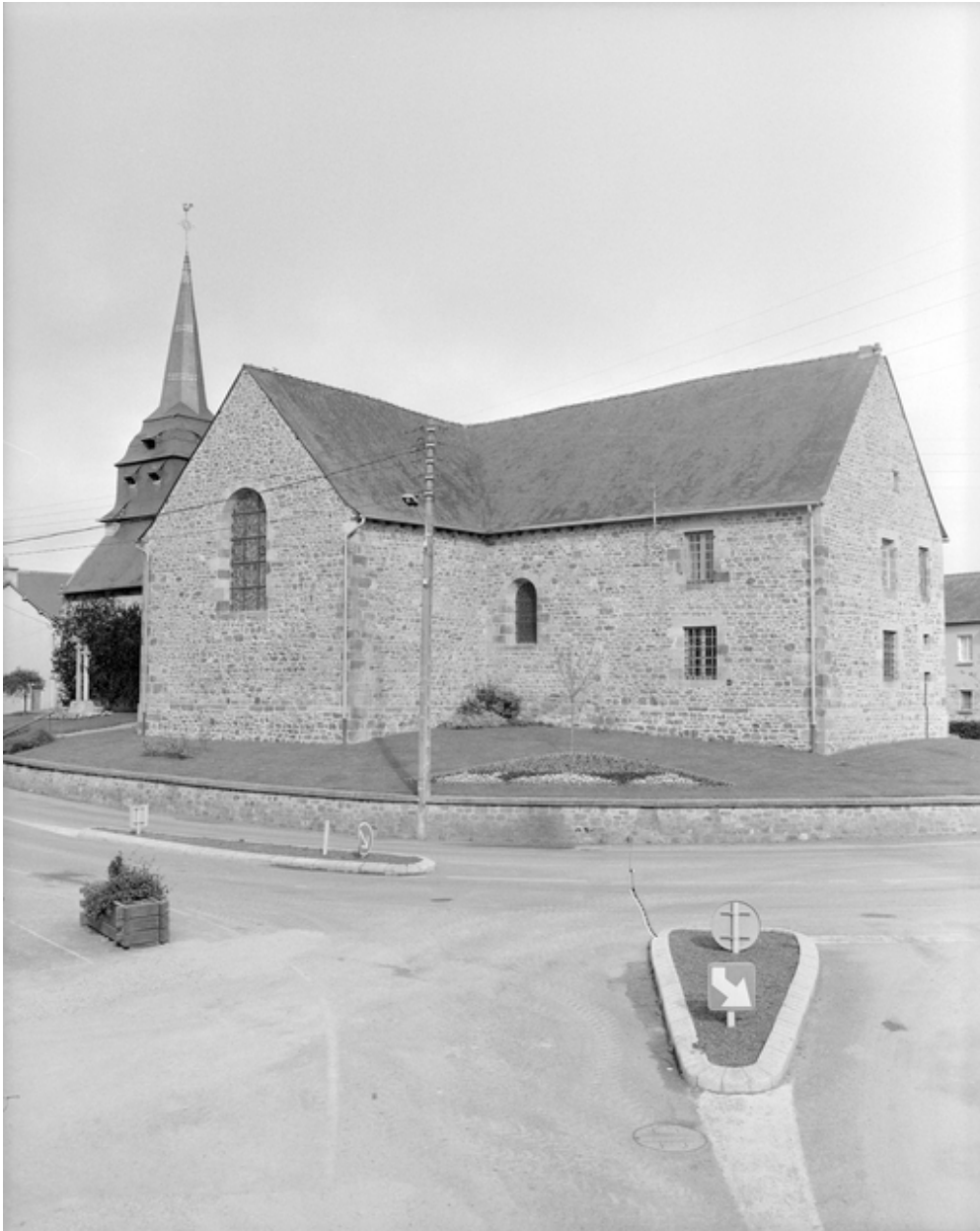
Elévation Nord-Ouest : vue générale
