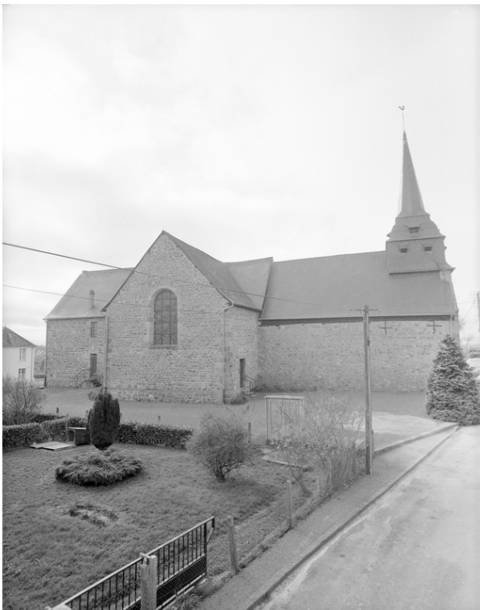
Elévation Sud : vue générale
