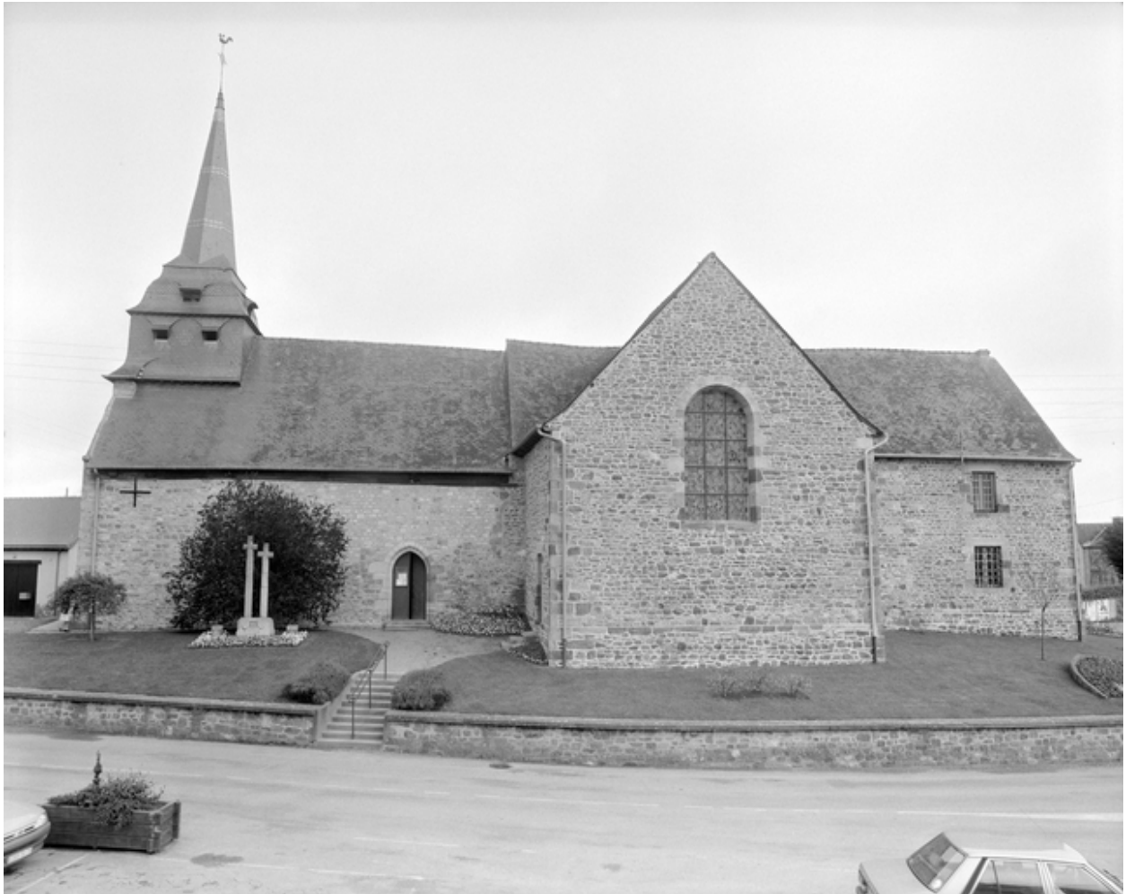
Elévation Nord : vue générale
