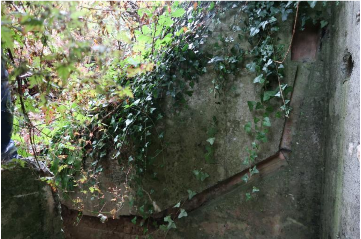
Vue de l'arrière de la casemate : réservation pour le passage d'un câble téléphonique ? (état en 2021)
