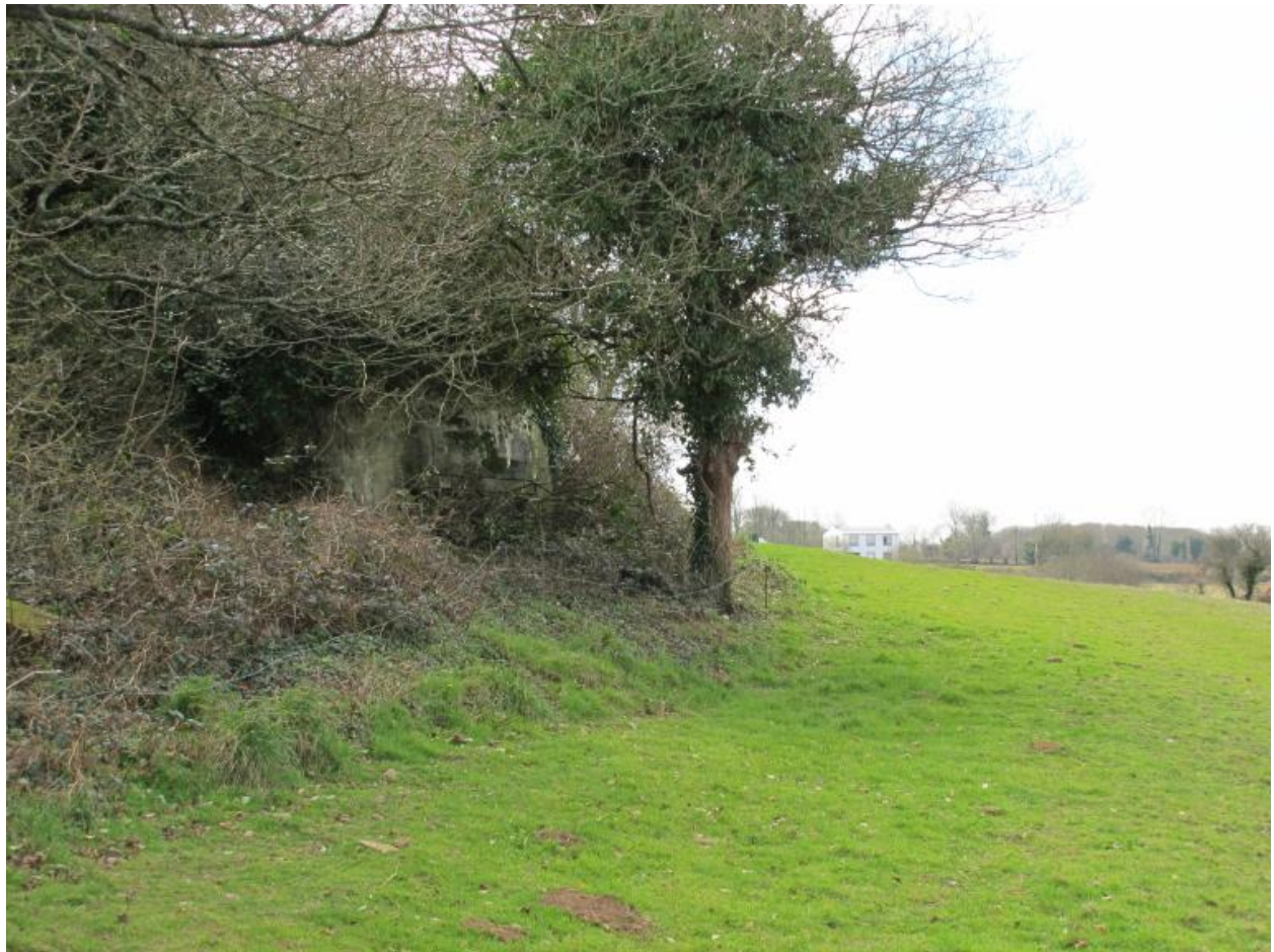
Vue de situation depuis l'est (état en 2013). La casemate en béton armé est envahie par la végétation
