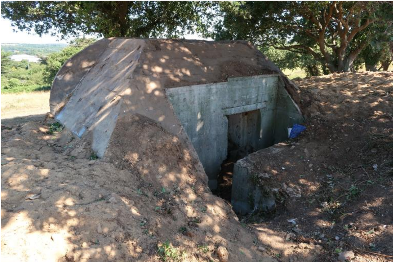
Vue générale de l'arrière (état en août 2022)
