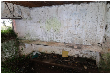
Vue de la chambre de tir : mur ouest (état en 2021). Au ras du sol, longue niche murale pour le stockage des munitions Phot. Guillaume Lécueillier IVR53_20222905337NUCA
