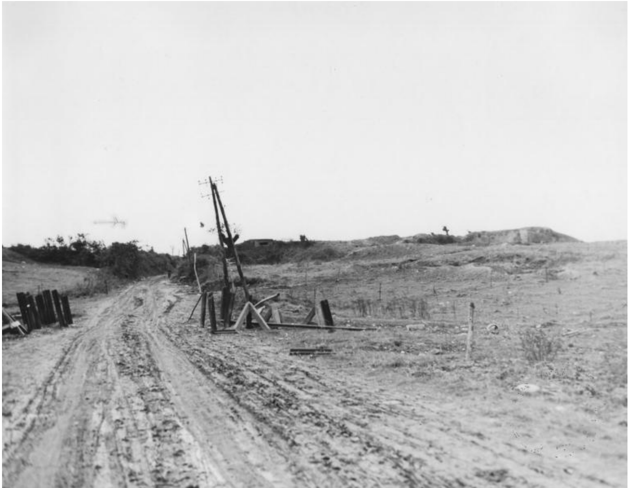
Vue générale des bunkers situés à l'Ouest de la route (United States Army Signal Corps, septembre 1944)
