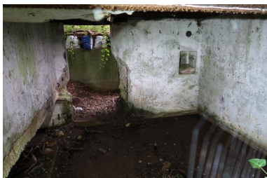
Vue de la chambre de tir depuis l'embrasure (état en 2021) Phot. Guillaume Lécueillier IVR53_20222905325NUCA
