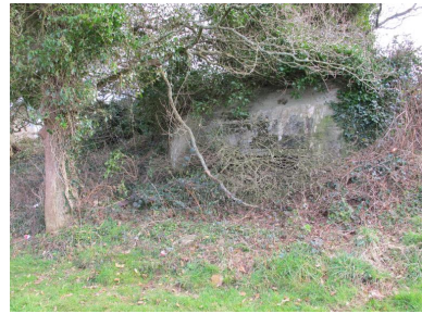
Vue générale (état en 2013). La casemate en béton armé est envahie par la végétation Phot. Guillaume Lécueillier IVR53_20222905321NUCA
