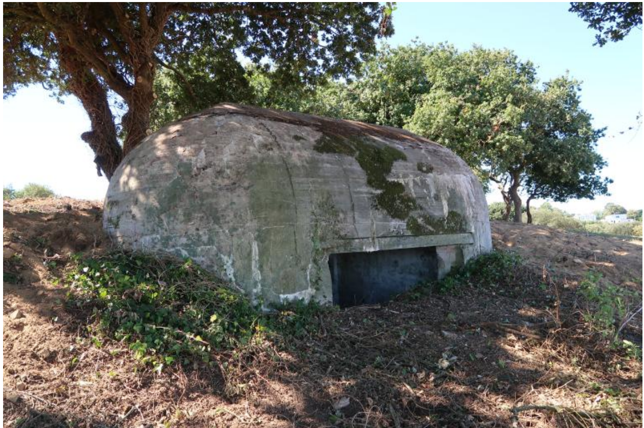
Vue générale (état en août 2022)
