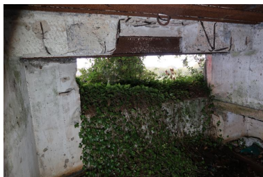
Vue de l'embrasure depuis l'intérieur de la chambre de tir (état en 2021)
