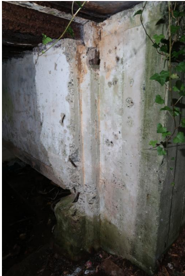
Vue de l'embrasure de la porte de la chambre de tir (état en 2021). On observe des impacts dans le béton...
