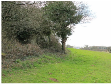
Vue de situation depuis l'est (état en 2013). La casemate en béton armé est envahie par la végétation Phot. Guillaume Lécueillier IVR53_20222905320NUCA
