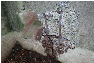
Vue de l'arrière de la casemate : passage depuis la chambre de tir pour l'éjection des douilles ? (état en 2021)
