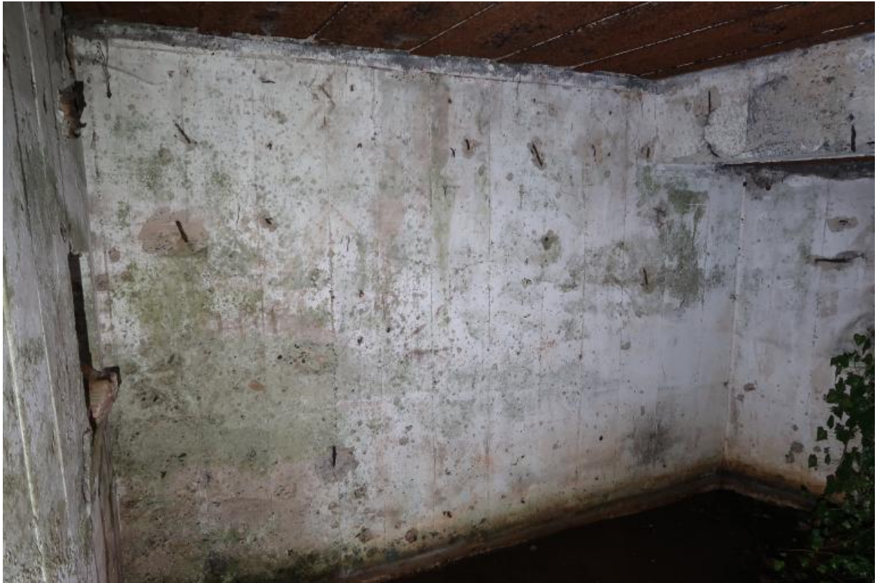
Vue de la chambre de tir : mur ouest (état en 2021)
