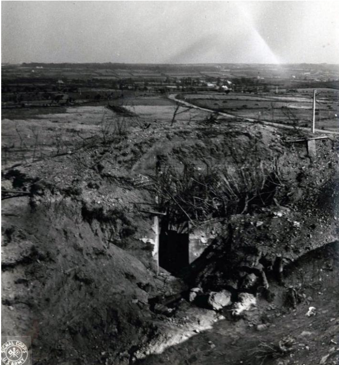
Vue arrière du bunker - casemate, variante du type 667 (United States Army Signal Corps, septembre 1944). Cette photographie a été identifiée en 2022 par Ludovic Le Braz et Simon Roudot
