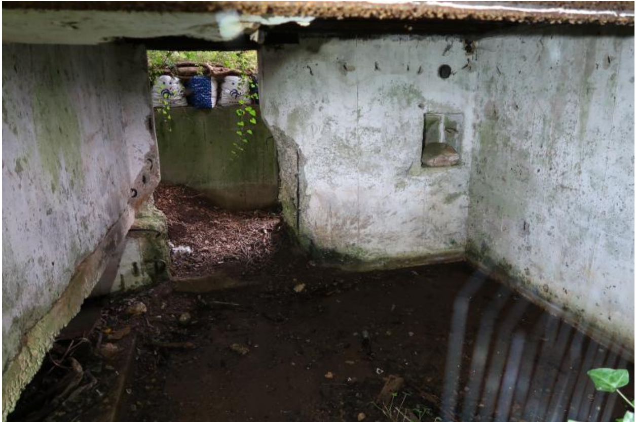
Vue de la chambre de tir depuis l'embrasure (état en 2021)
