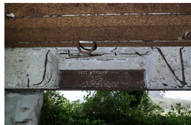
Vue de l'embrasure depuis l'intérieur de la chambre de tir : détail de la fixation du canon (état en 2021)
