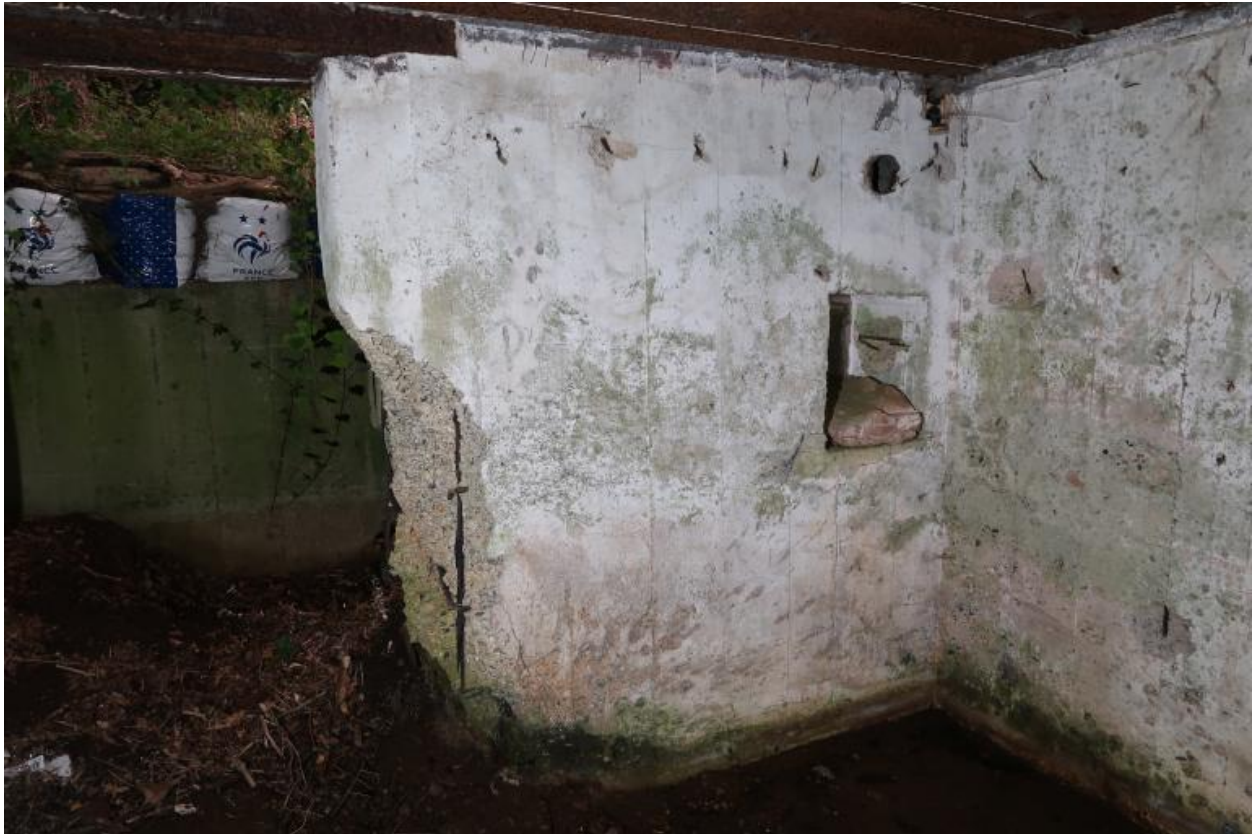
Vue de la chambre de tir : passage pour l'éjection des douilles ? (état en 2021)
