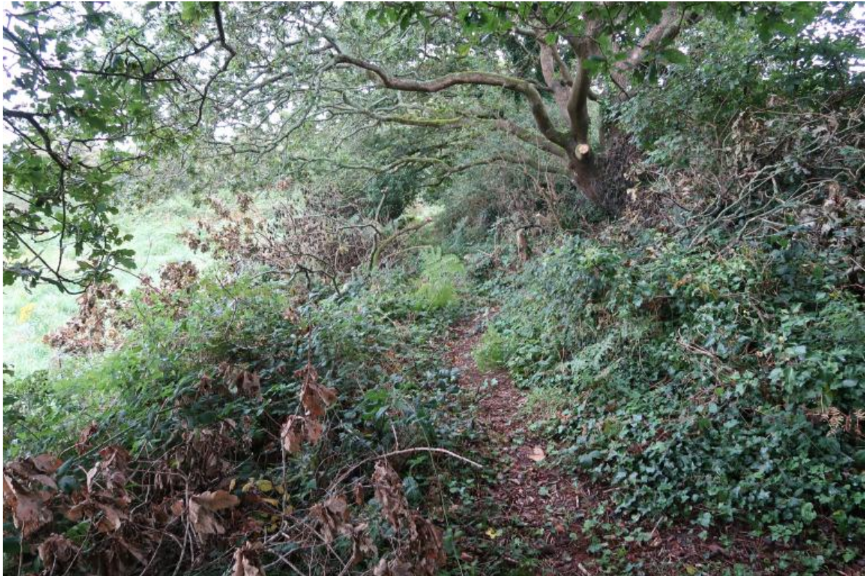
Vue du sentier située à l'est de la casemate (état en 2021)
