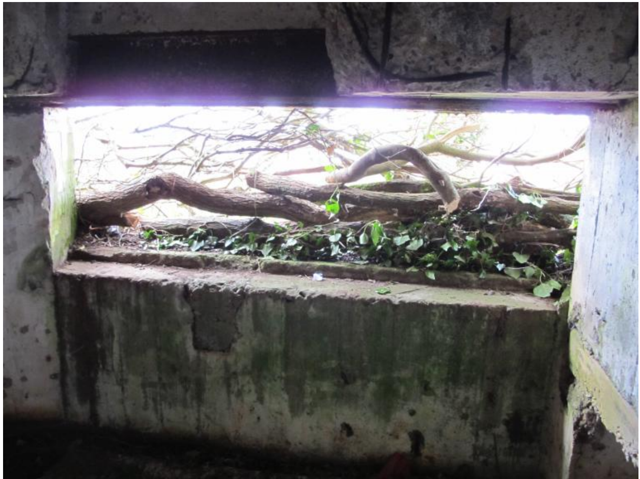
Vue de l'embrasure depuis l'intérieur (état en 2013)
