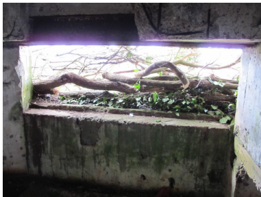
Vue de l'embrasure depuis l'intérieur (état en 2013) Phot. Guillaume Lécueillier IVR53_20222905322NUCA
