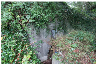
Vue de l'accès par l'arrière de la casemate (état en 2021) Phot. Guillaume Lécueillier IVR53_20222905326NUCA
