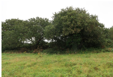
Vue de situation : la casemate est invisible du fait de la végétation (état en 2021) Phot. Guillaume Lécueillier IVR53_20222905338NUCA
