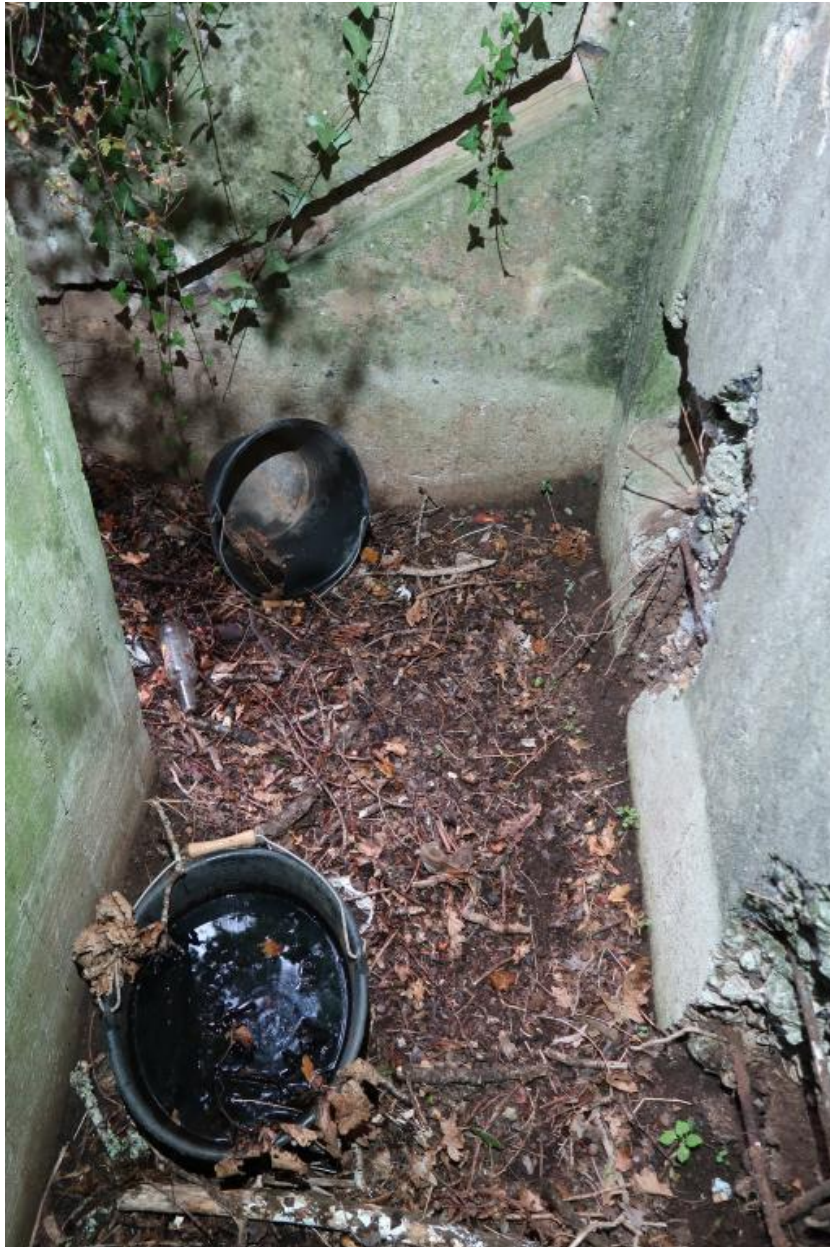
Vue de l'arrière de la casemate : passage depuis la chambre de tir pour l'éjection des douilles ? (état en 2021)
