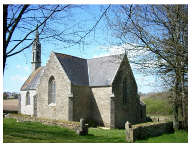
Riec-sur-Belon, chapelle Saint-Gilles : vue générale sud-est Phot. Gwénaél Fauchille IVR53_20082905711NUCA
