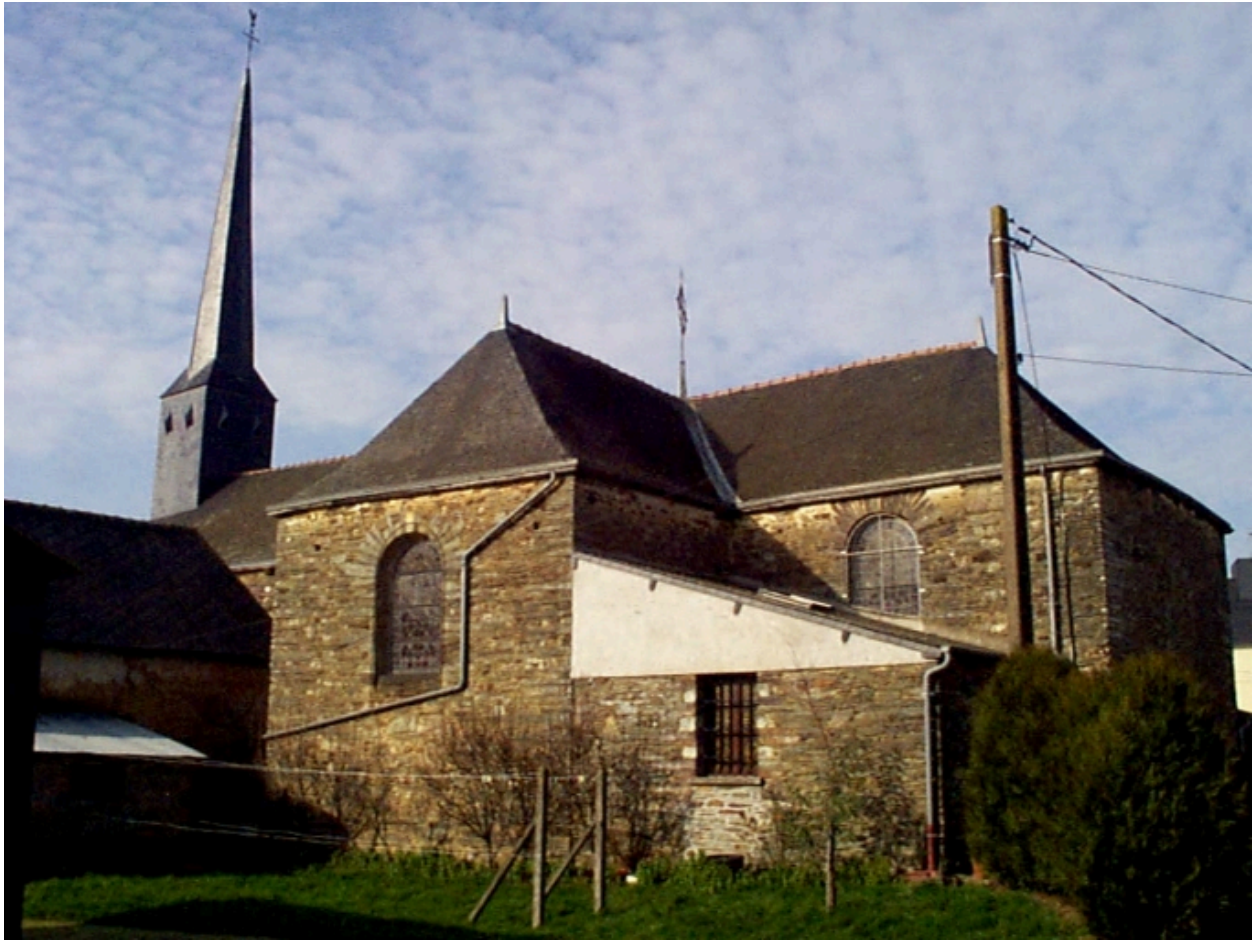
Vue générale sud-est
