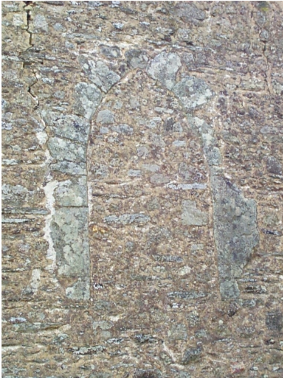
Ancienne baie du chevet bouchée : vue générale est
