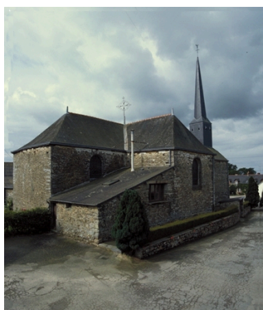
Vue générale nord-est Phot. Guy Artur, Phot. Norbert Lambart IVR53_19993501173XA
