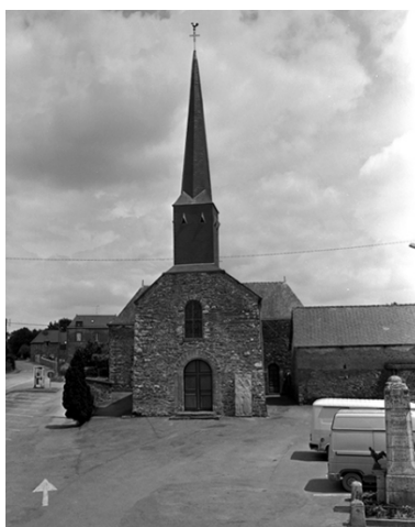
Le Clocher en façade ouest : vue générale Phot. Guy Artur, Phot. Norbert Lambart IVR53_19993509571X
