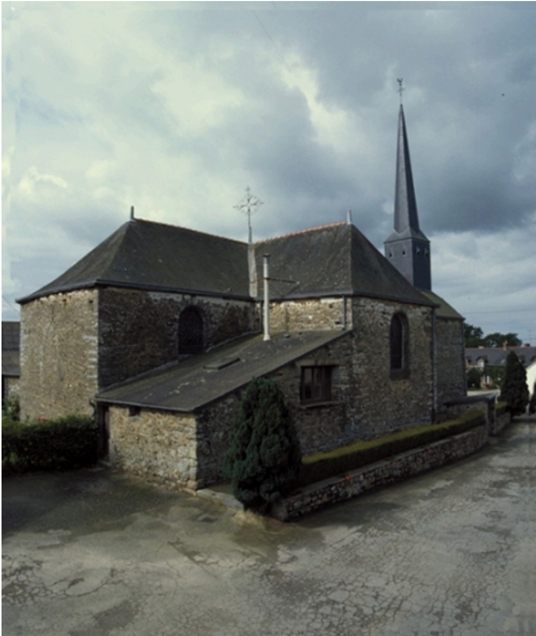
Vue générale nord-est
