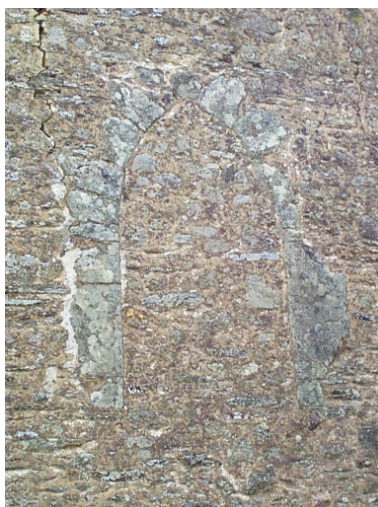
Ancienne baie du chevet bouchée : vue générale est Repro. Xavier Gilbert
