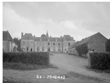
Vue générale prise du sud-ouest Phot. François Dagorn IVR53_19642900442V
