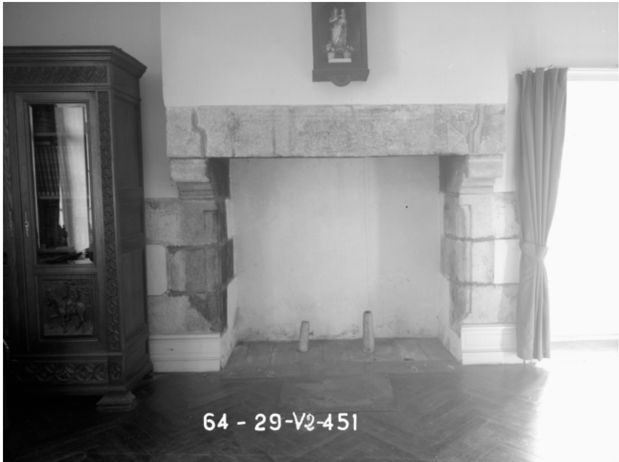
Rez-de-chaussée, cheminée ouest du pavillon ouest
