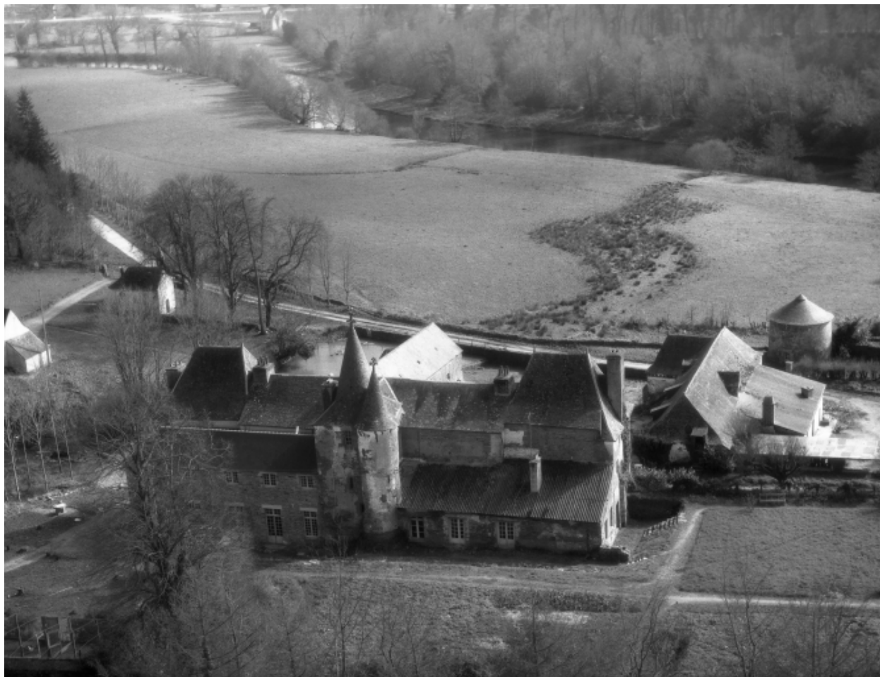
Vue aérienne : vue générale nord
