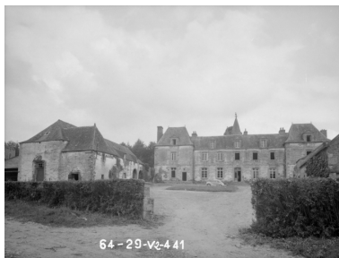
Vue générale prise du sud-est Phot. François Dagorn IVR53_19642900441V
