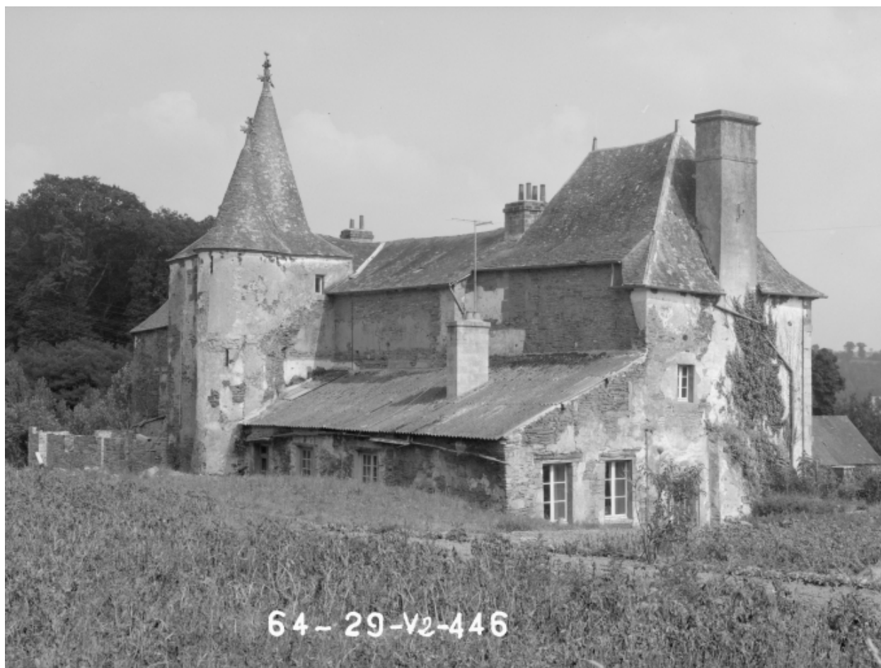
Façade postérieure prise du nord-ouest
