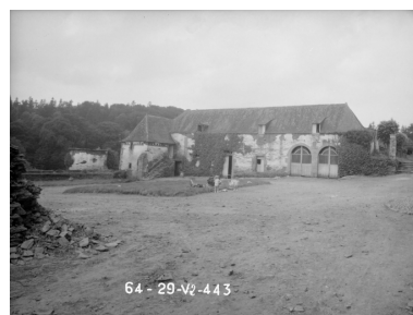
Communs, côté ouest, vue générale Phot. François Dagorn IVR53_19642900443V
