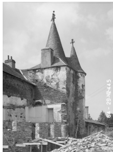
Pavillon d'escalier, vue générale Phot. François Dagorn IVR53_19642900445V
