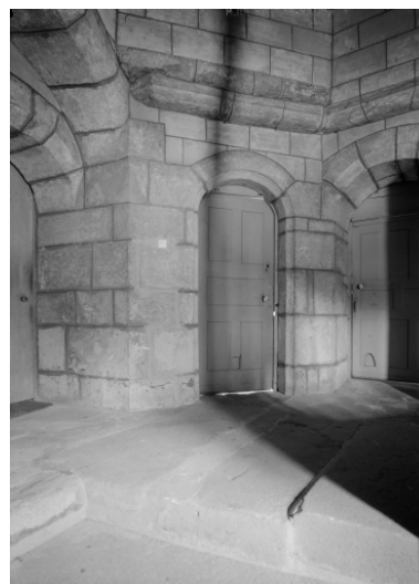
1er palier : portes Phot. Auteur inconnu IVR53_19652900416V
