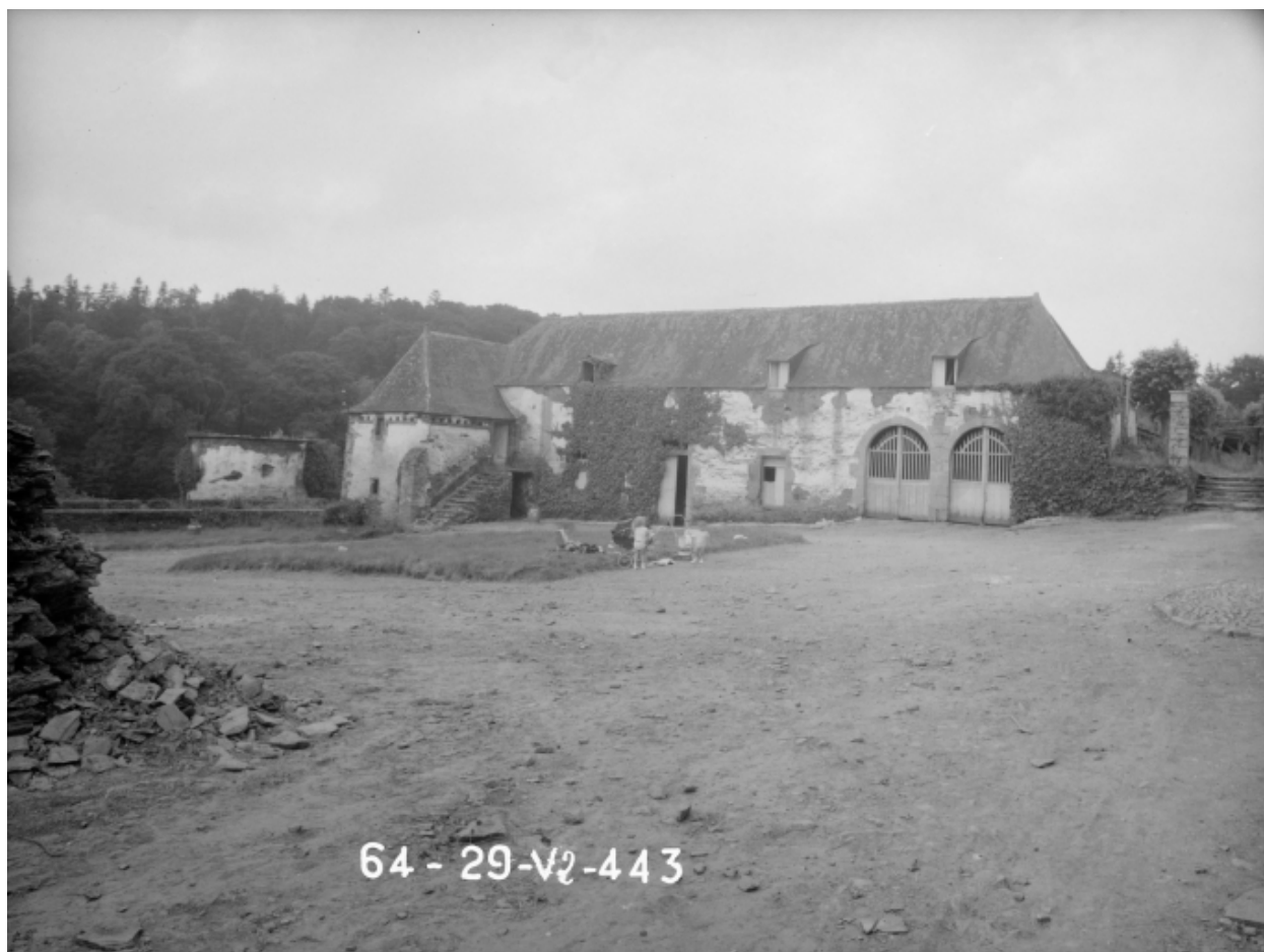
Communs, côté ouest, vue générale
