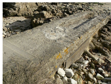
Rampe du fort de Locqueltas Phot. Julien Amghar IVR53_20085606026NUCA
