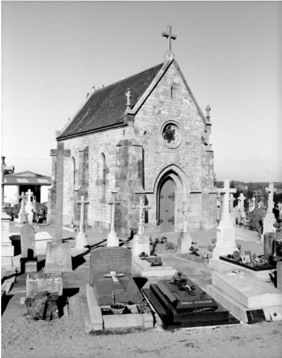
Elévation latérale : vue générale
