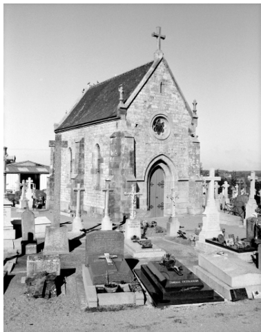
Elévation latérale : vue générale Phot. Guy Artur, Phot. Norbert Lambart IVR53_19953500528X
