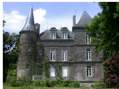
Château, vue générale sud Phot. Judith Tanguy-Schröer IVR53_20025603364NUCA
