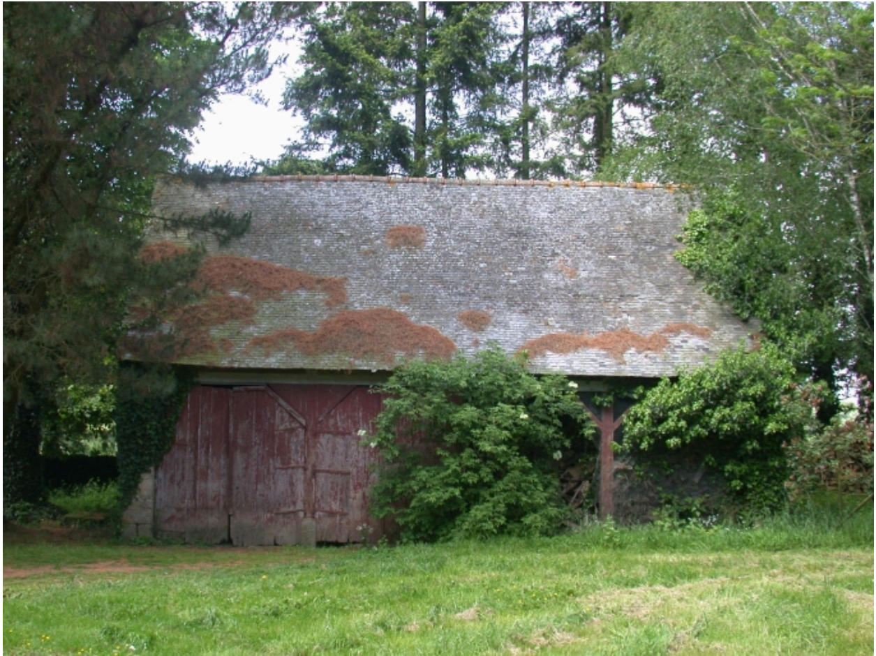
Remise, vue générale
