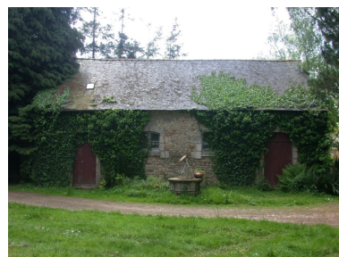
Dépendance, vue générale Phot. Judith Tanguy-Schröer IVR53_20025603367NUCA
