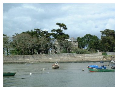
Vue de situation avec le plan d'eau Phot. Julien Amghar IVR53_20065606583NUCA
