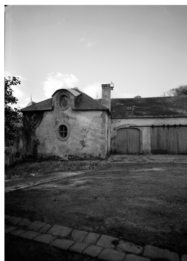
Communs : vue de la partie nord-ouest Phot. François Dagorn IVR53_19655600759V
