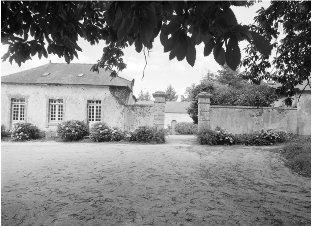
Communs, extérieur : vue prise du sud-ouest
