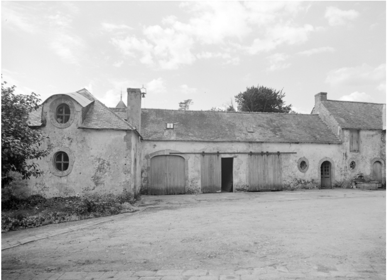
Communs, intérieur de la cour : vue générale prise du sud-est
