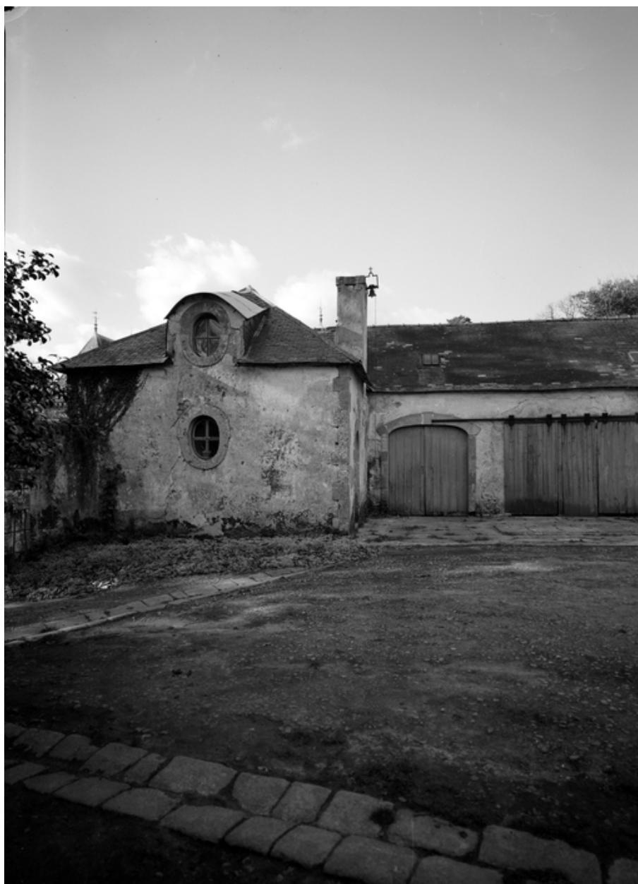
Communs : vue de la partie nord-ouest
