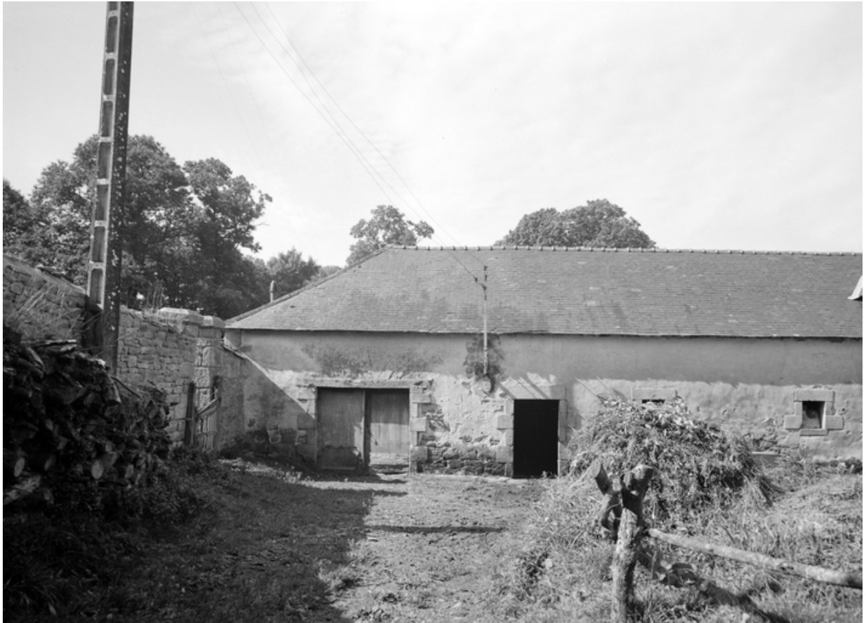
Communs, bâtiment central : face postérieure, partie gauche
