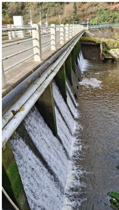
Ouverture des vannes pour la gestion du niveau du bassin à flot Phot. Erwana L'Haridon IVR53_20262210228NUCA
