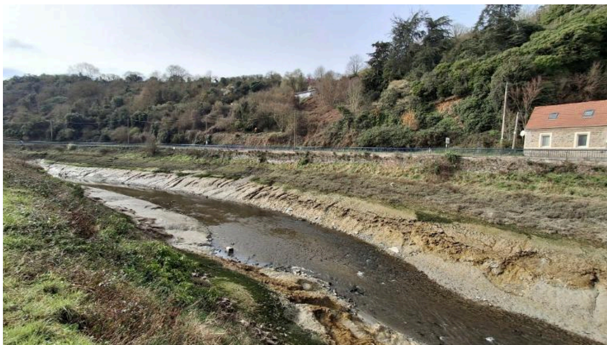
Vue du bras de mer depuis l'île sèche vers le pont déversoir
