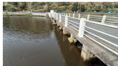
Vue de la jonction entre déversoir et tablier Phot. Erwana L'Haridon IVR53_20262210227NUCA
