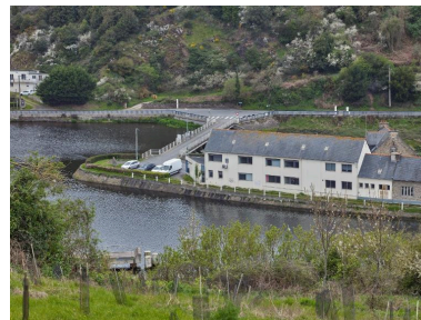
Vue de situation de l'accès à l'île sèche, à l'ancienne usine d'émulsion et à l'ancien centre départemental technique des Côtes-d'Armor par le pont-déversoir Phot. Bernard Bègne IVR53_20262200299NUCA
