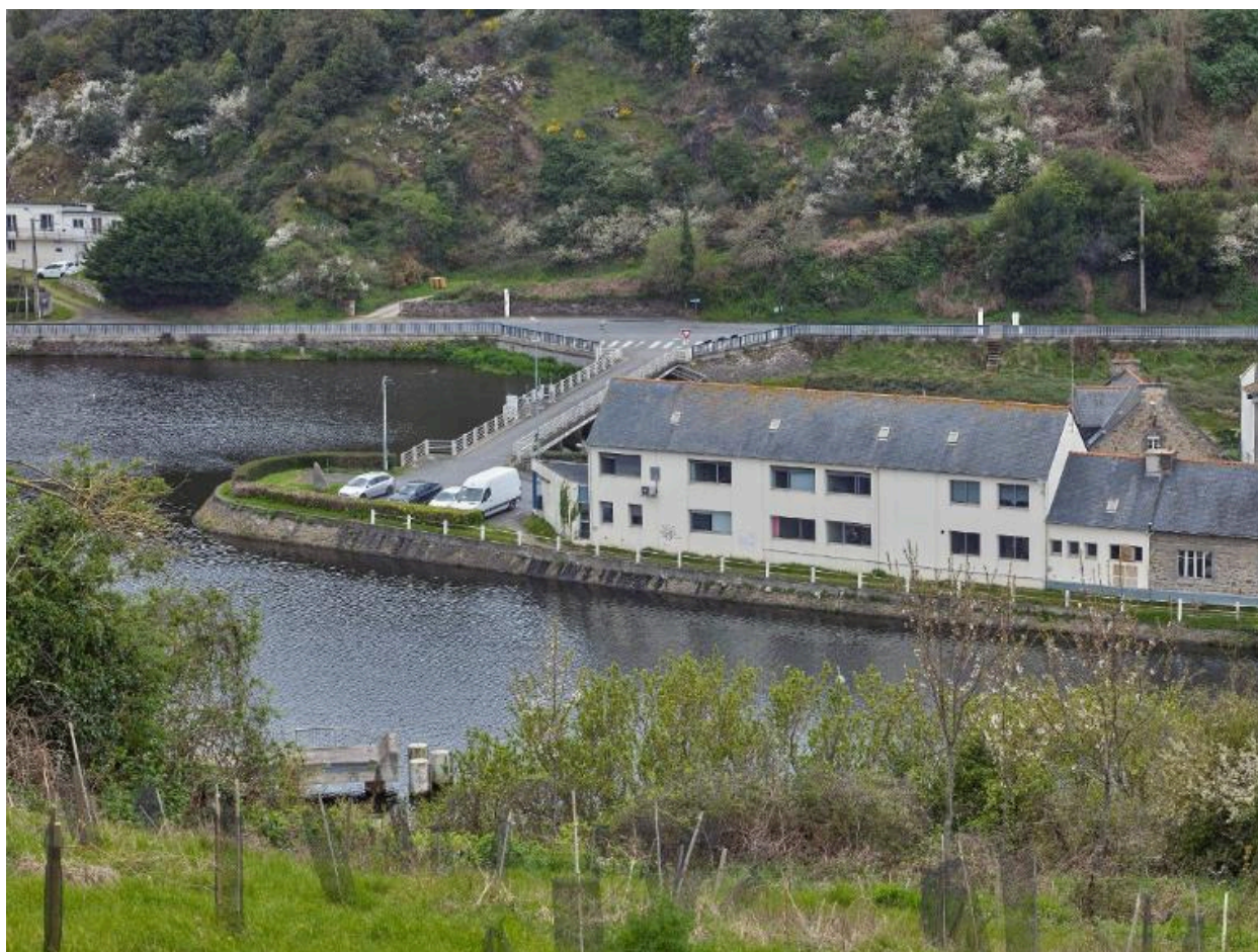
Vue de situation de l'accès à l'île sèche, à l'ancienne usine d'émulsion et à l'ancien centre départemental technique des Côtes-d'Armor par le pont-déversoir
