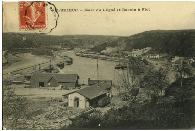
Vue du bassin à flot avant la construction du déversoir qui a permis l'agrandissement du port Autr. Emile Hamonic IVR53_20252210698NUCA
