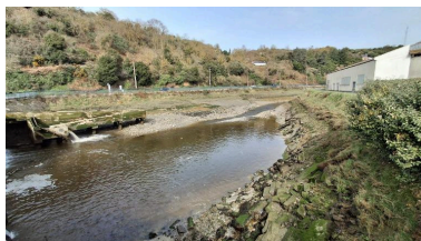
Vue du bras de mer depuis le pont Phot. Erwana L'Haridon IVR53_20262210229NUCA
