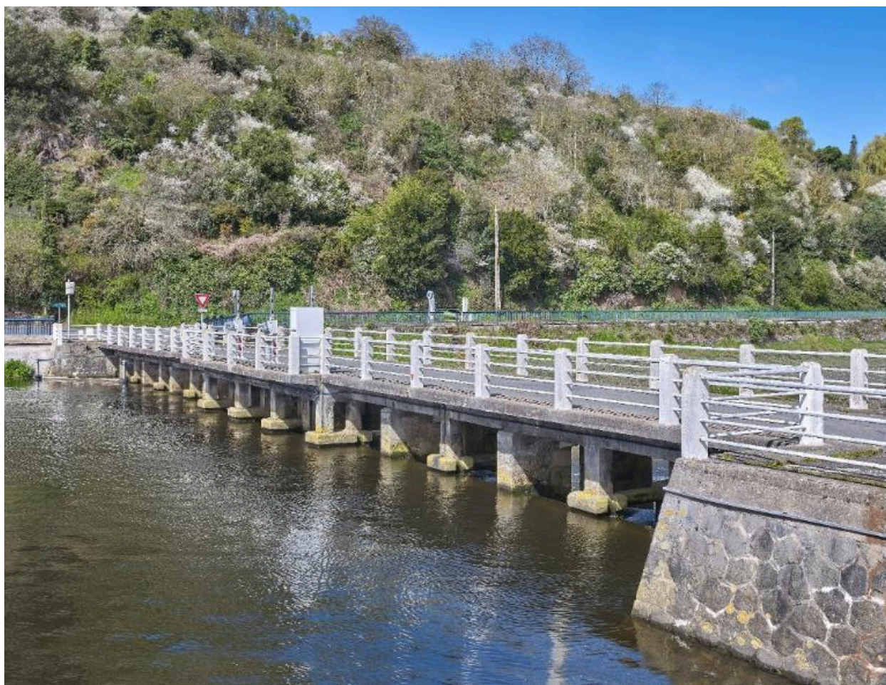
Pont-déversoir du bassin à flot
