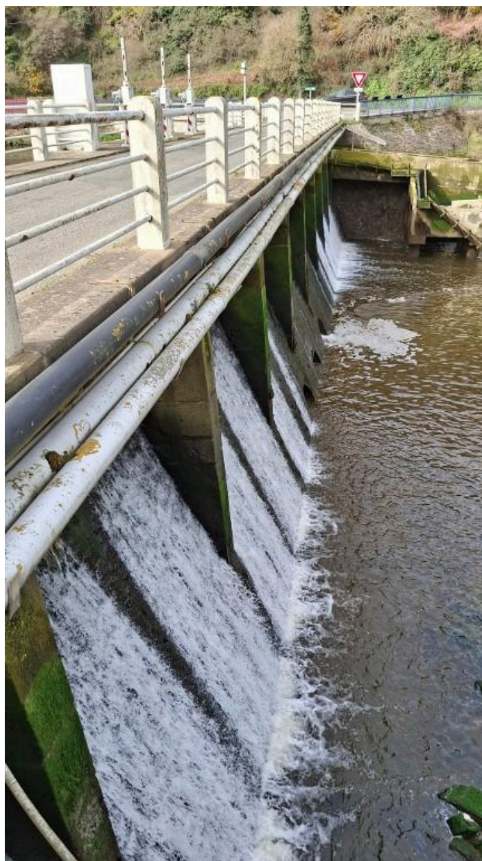
Ouverture des vannes pour la gestion du niveau du bassin à flot
