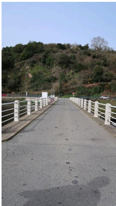
Tablier du pont Phot. Erwana L'Haridon IVR53_20262210235NUCA
