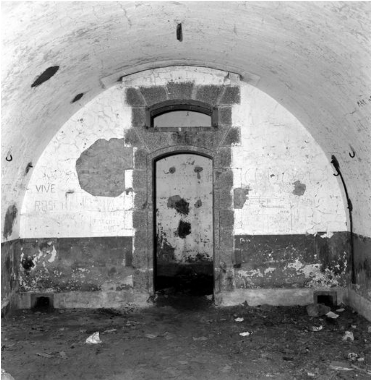
Vue de la batterie de la pointe des Espagnols en 1969 : intérieur d'un abri-traverse de la batterie haute
