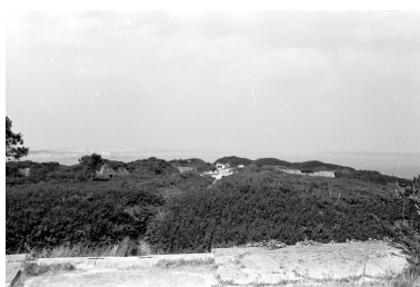
Vue générale des batteries hautes de la pointe des Espagnols en 1969 depuis la terrasse de la tour-modèle n° 1 Phot. Guy Artur IVR53_19692900365Z
