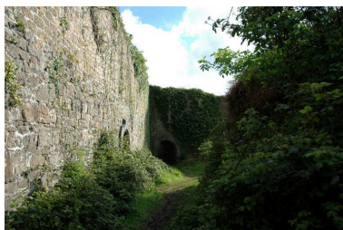
Vue de la pointe des Espagnols : partie sud de l'enceinte du fort (ouvrage à corne). Entrée du magasin à poudre sous roc Phot. Guillaume Lécueillier IVR53_20072906438NUCA
