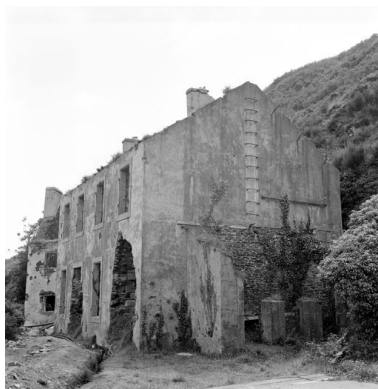
Vue de la batterie de la pointe des Espagnols en 1969 : bâtiment ruiné de la batterie basse Phot. Guy Artur IVR53_19692900220X
