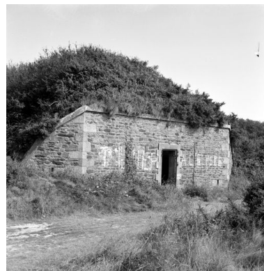
Vue de la batterie de la pointe des Espagnols en 1969 : abri-traverse de la batterie haute Phot. Guy Artur
