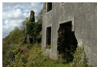
Vue de la pointe des Espagnols : la batterie basse et ses casernements ruinés (19e siècle) Phot. Guillaume Lécueillier IVR53_20072906445NUCA
