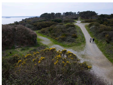
Roscanvel : vue de la pointe des Espagnols. Les batteries de bombardement du 19e siècle sont envahies par la végétation Phot. Bernard Bègne IVR53_20122900198NUCA
