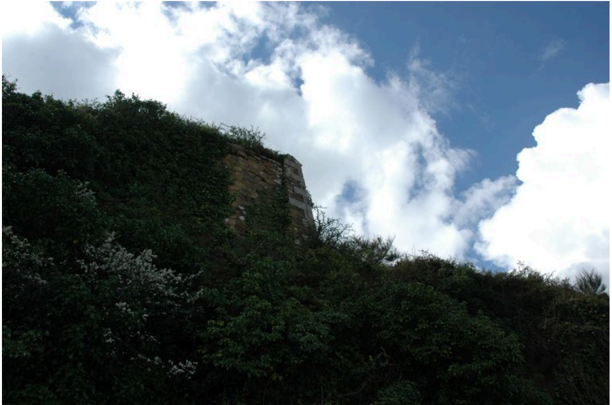
Vue de la pointe des Espagnols : enceinte du fort (milieu 18e siècle) envahie par la végétation (ouvrage à corne). Chaîne harpée en granite
