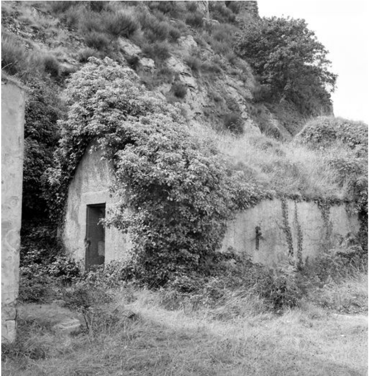
Vue de la batterie de la pointe des Espagnols en 1969 : bâtiment ruiné de la batterie basse à l'épreuve
