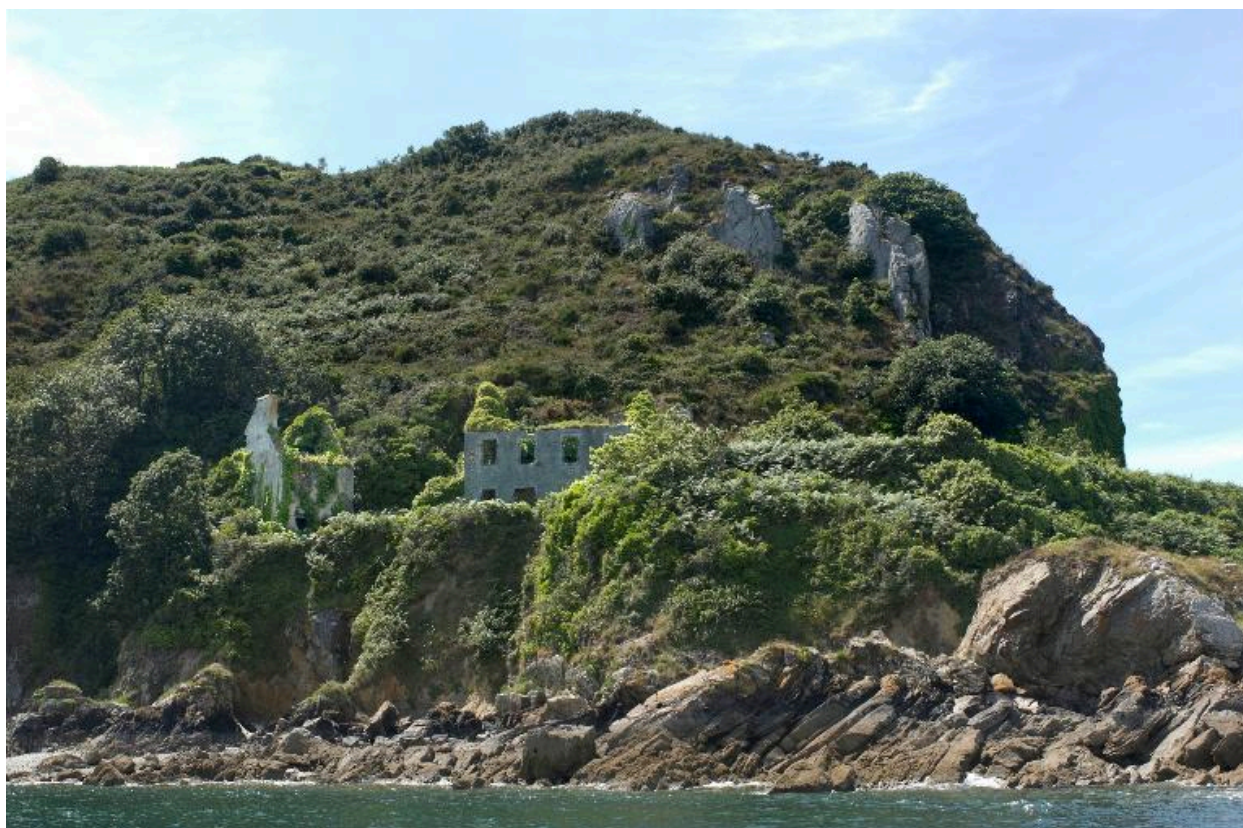
Roscanvel : vue de la pointe des Espagnols, batterie basse et casernements envahi par la végétation depuis la mer
