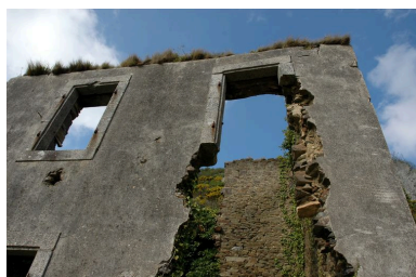
Vue de la pointe des Espagnols : la batterie basse et ses casernements ruinés (19e siècle) Phot. Guillaume Lécueillier IVR53_20072906446NUCA
