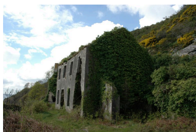
Vue de la pointe des Espagnols : la batterie basse et ses casernements ruinés (19e siècle) Phot. Guillaume Lécueillier IVR53_20072906443NUCA
