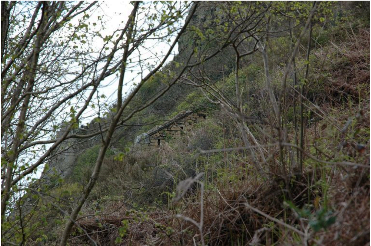
Vue de la pointe des Espagnols : enceinte du fort (milieu 18e siècle) envahie par la végétation (ouvrage à corne). Nombreux créneaux de fusillade
