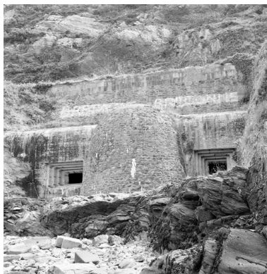
Vue générale de la batterie de rupture de la pointe des Espagnols en 1969 : embrasures Phot. Guy Artur
