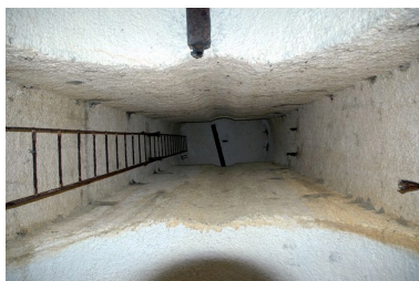
Vue de la pointe des Espagnols : puits du monte-charge du magasin à poudre sous roc Phot. Guillaume Lécueillier IVR53_20072906441NUCA
