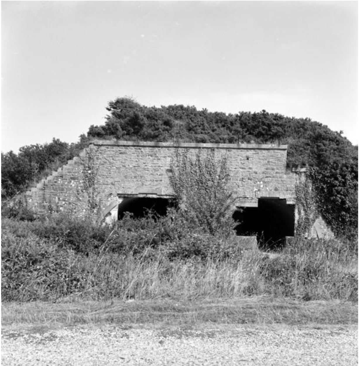
Vue de la batterie de la pointe des Espagnols en 1969 : abri-traverse double de la batterie haute
