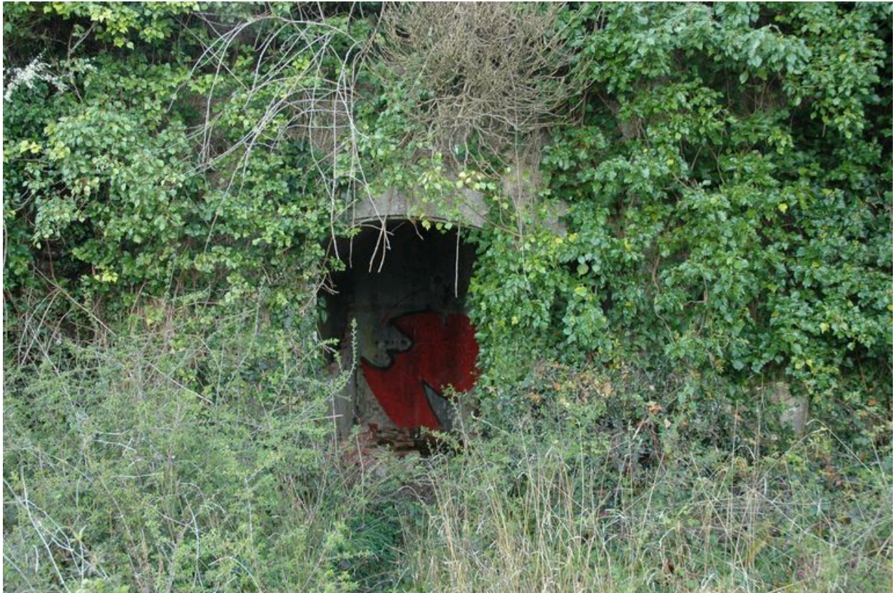
Vue de la pointe des Espagnols : soute à munitions creusée en abri-caverne dans le pied de la falaise
