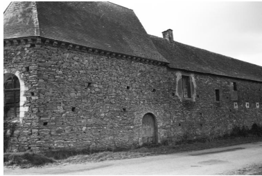
Ferme - Face ouest des bâtiments. Phot. Jean-Claude Groussard IVR53_19673500417Z
