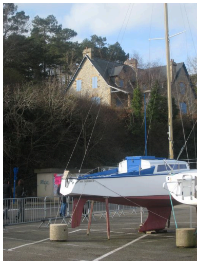
Quais et terre-plein à proximité du môle de Morgat Phot. Françoise Péron IVR53_20072908618NUCA
