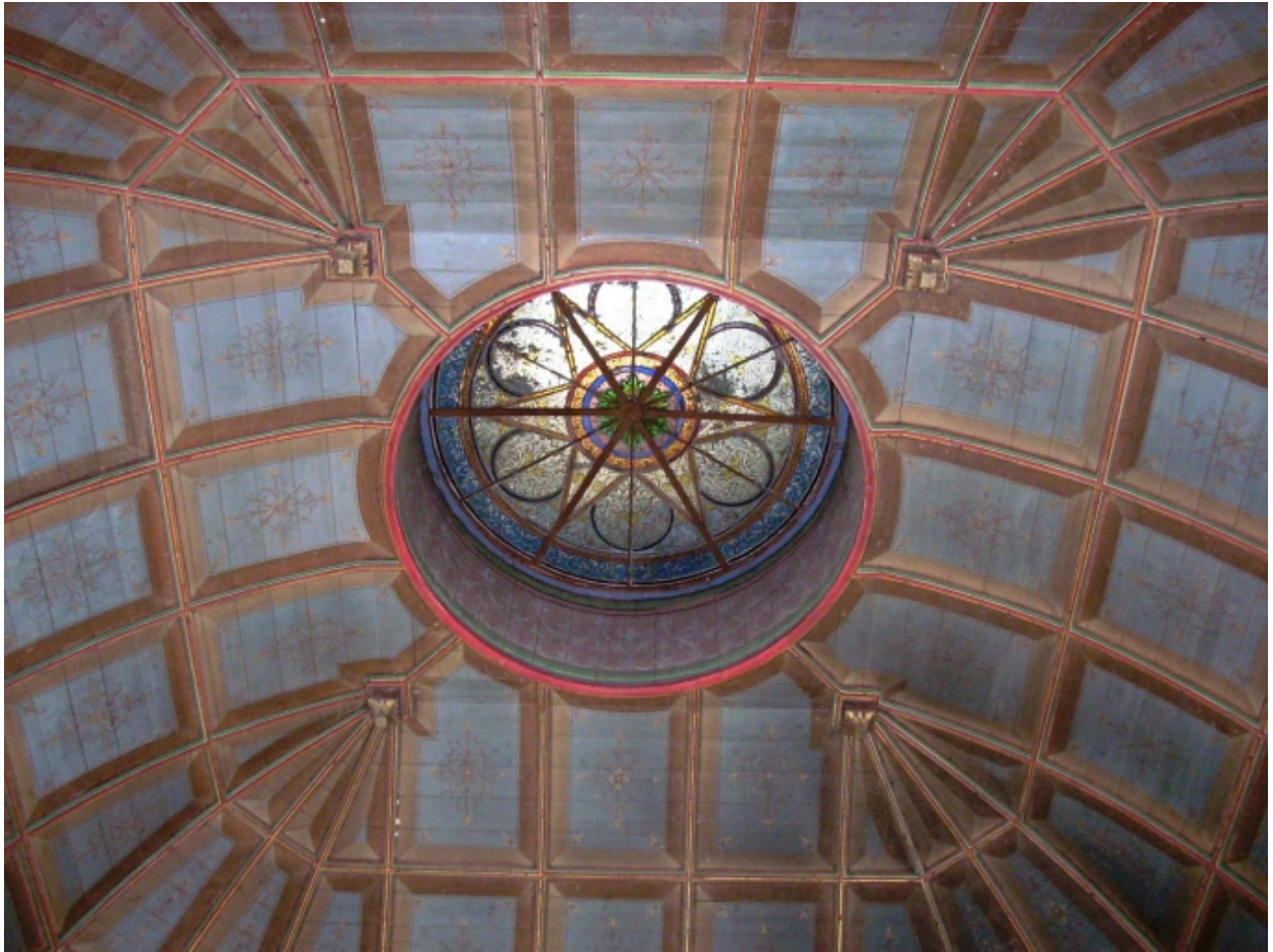
Plouguerneau, église paroissiale : détail lambris de couverture de la sacristie nord
