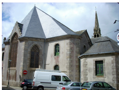
Plouguerneau, église paroissiale : vue générale est Phot. Gwénaél Fauchille IVR53_20082906100NUCA
