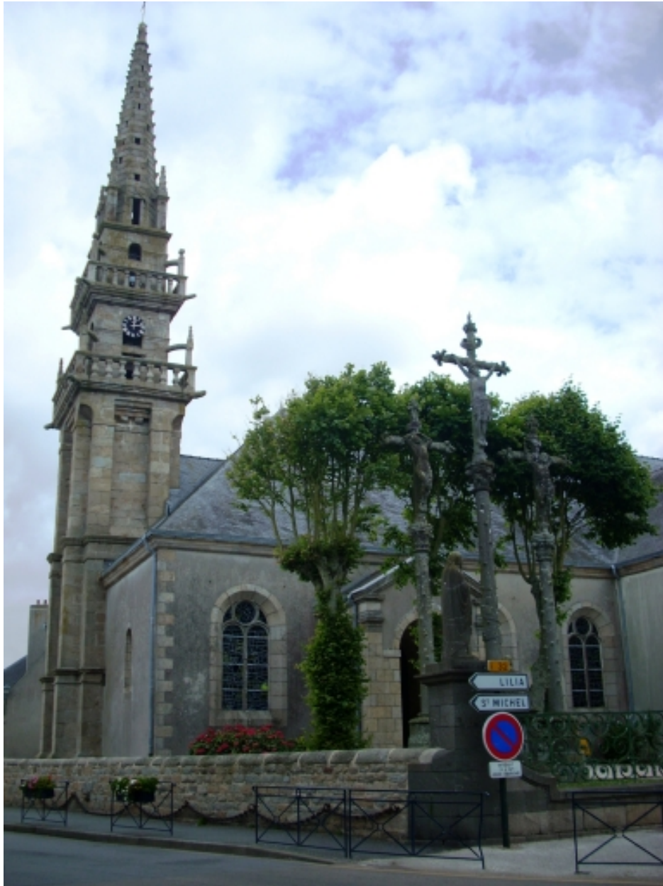
Plouguerneau, église paroissiale : vue générale sud-ouest
