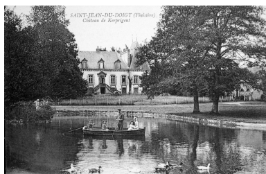
Vue générale Phot. Elise Lauranceau IVR53_20042905584NUCB
