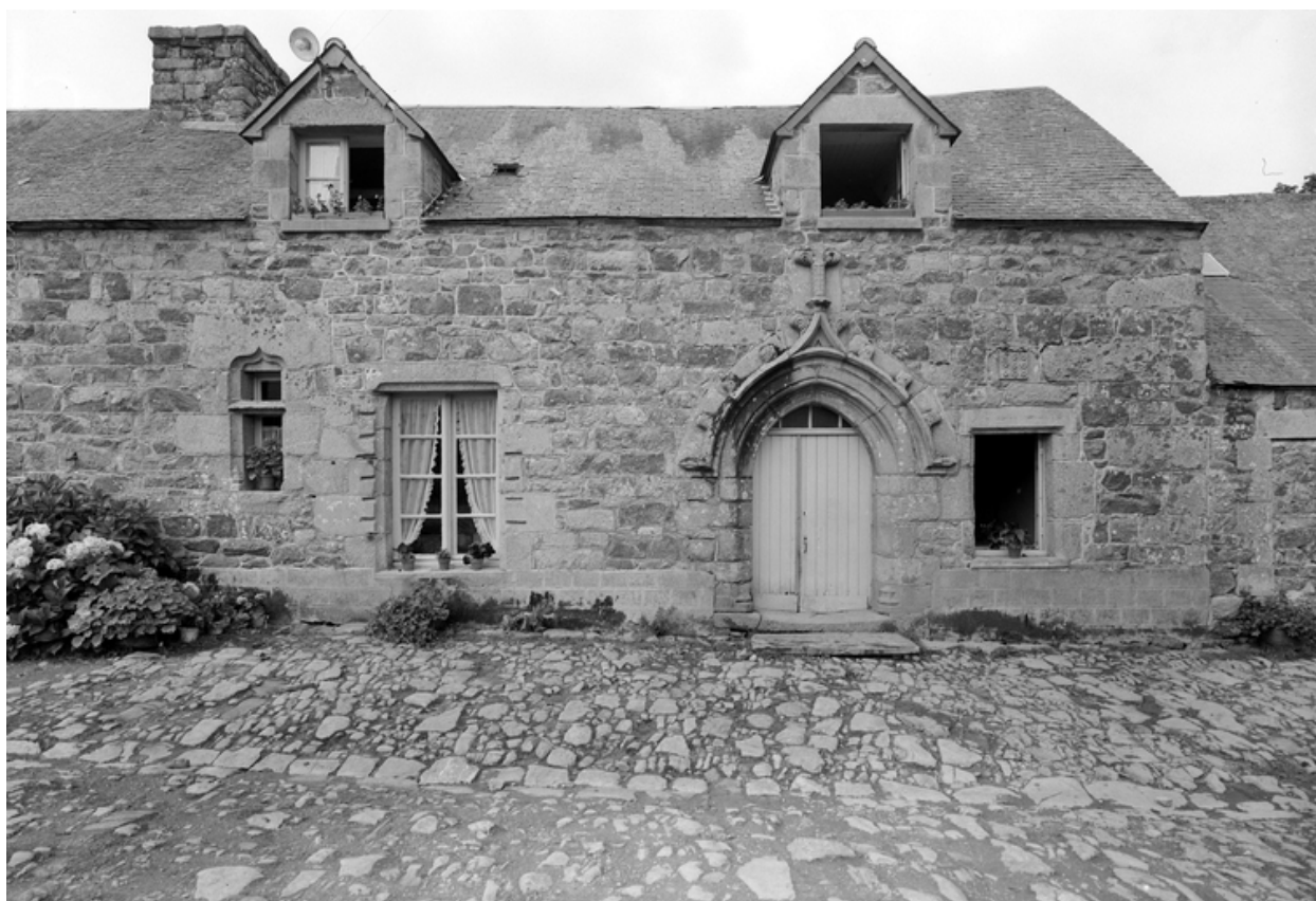
Vue de la face sud
