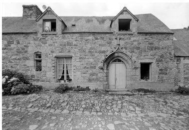
Vue de la face sud Phot. Guy Artur IVR53_19682201264V
