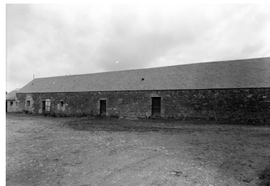
Vue de la face nord du commun sud Phot. Guy Artur IVR53_19682201265V
