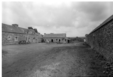
Vue générale Phot. Guy Artur IVR53_19682201263V
