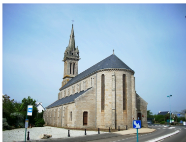
Tréffiagat, église paroissiale Saint-Riagat : vue générale sud-est Phot. Gwénaél Fauchille IVR53_20082905880NUCA
