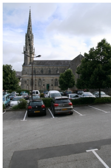
Châteaulin, église paroissiale Saint-Idunet : vue générale sud Phot. Gwénaél Fauchille IVR53_20082906702NUCA
