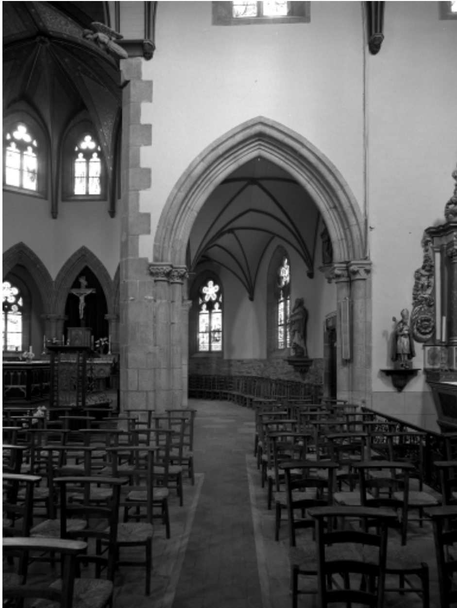
Châteaulin, église paroissiale Saint-Idunet : bras sud du transept, élévation de l'arcade est, état en 1972
