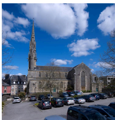
Eglise Saint-Idunet, côté sud Phot. Bernard Bègne IVR53_20142900283NUCA
