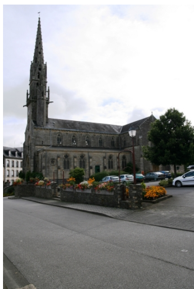
Châteaulin, église paroissiale Saint-Idunet : vue générale sud-ouest Phot. Gwénaél Fauchille IVR53_20082906700NUCA
