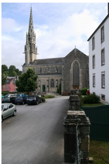
Châteaulin, église paroissiale Saint-Idunet : vue générale sud Phot. Gwénaél Fauchille IVR53_20082906701NUCA
