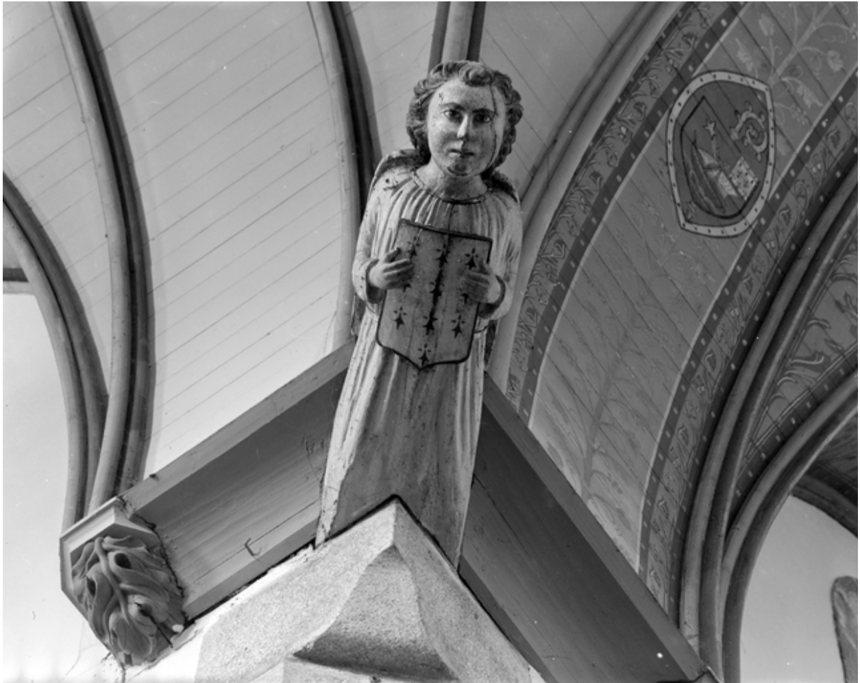
Châteaulin, église paroissiale Saint-Idunet : blochet, croisée, angle nord-est, état en 1972
