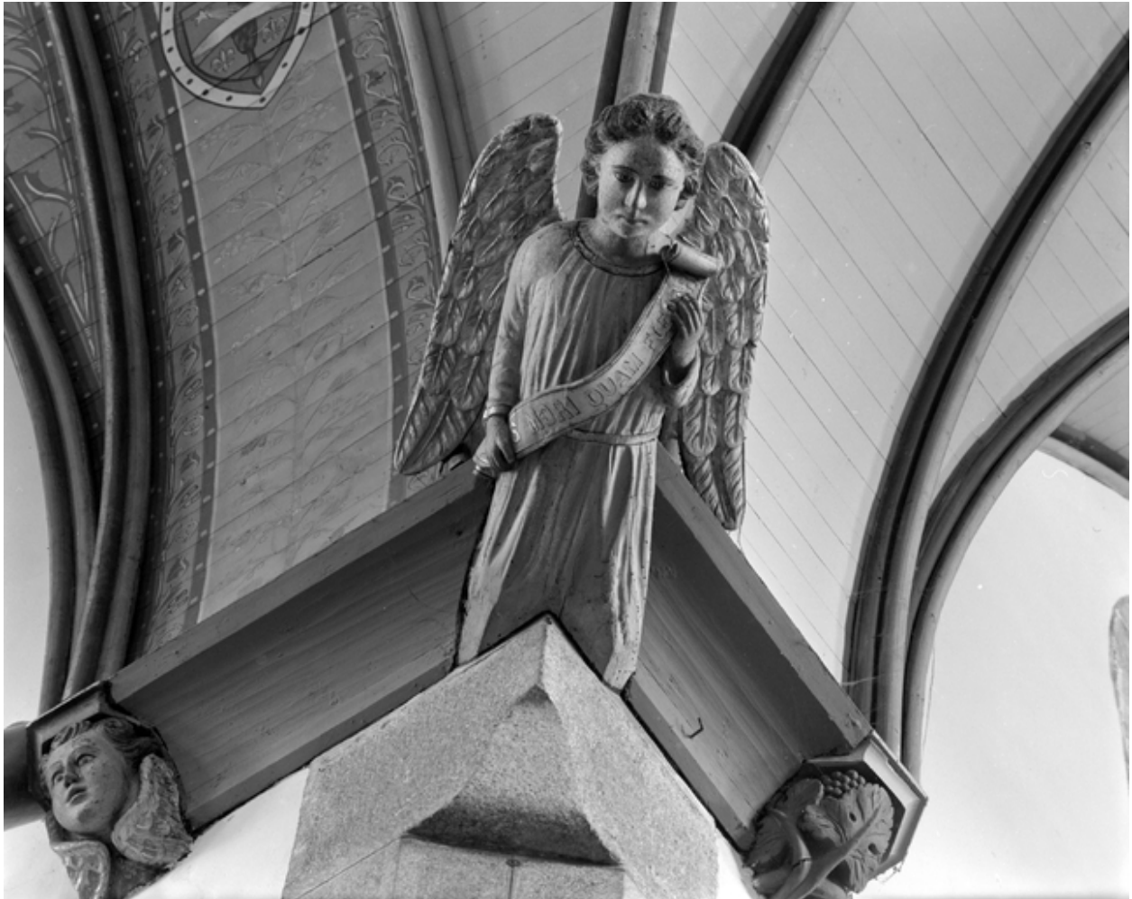
Châteaulin, église paroissiale Saint-Idunet : blochet, croisée, angle sud-est, état en 1972
