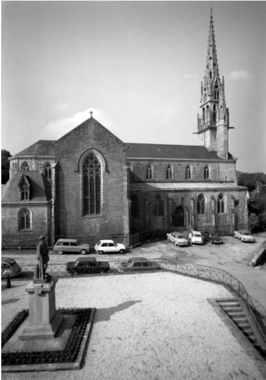
Châteaulin, église paroissiale Saint-Idunet : façade nord, vue d'ensemble, état en 1972
