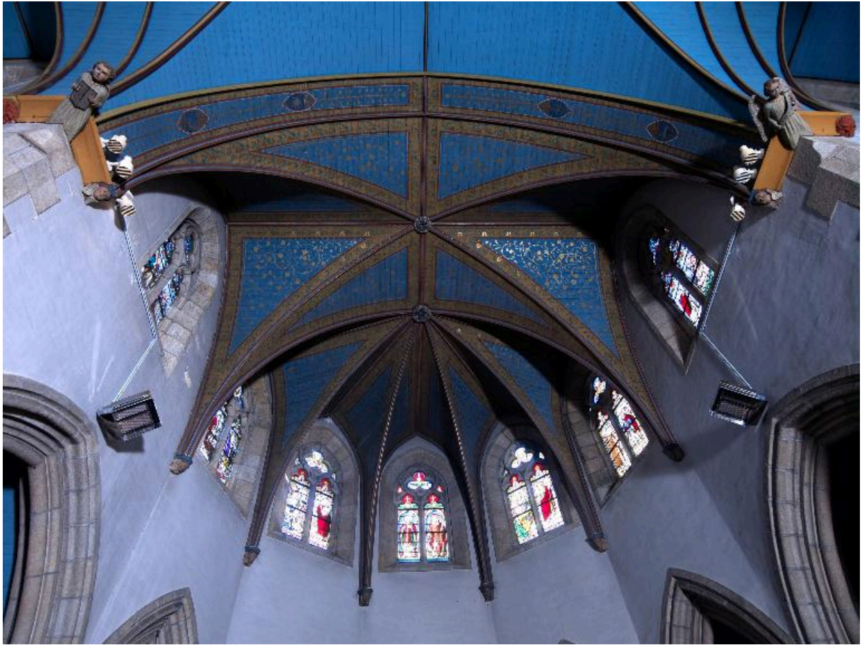
Eglise Saint-Idunet, vue de la voute du chevet (bois polychrome)
