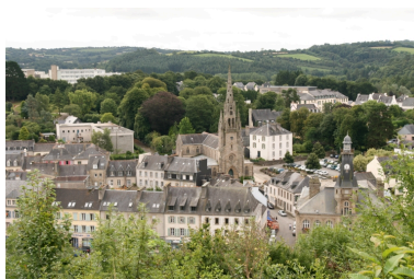
Châteaulin, église paroissiale Saint-Idunet : vue de situation depuis le nord-ouest Phot. Gwénaél Fauchille IVR53_20082906698NUCA
