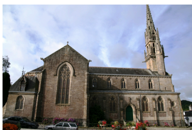
Châteaulin, église paroissiale Saint-Idunet : élévation nord Phot. Gwénaél Fauchille IVR53_20082906703NUCA
