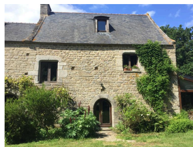
Manoir des Murs, partie est Phot. Fadila Hamelin IVR53_20212265751NUCA
