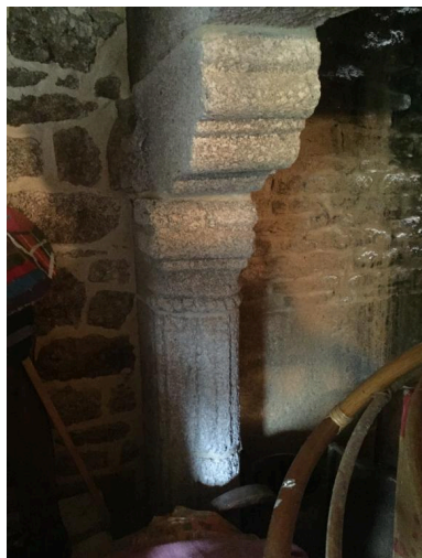
Détail d'une cheminée Phot. Fadila Hamelin IVR53_20212265758NUCA
