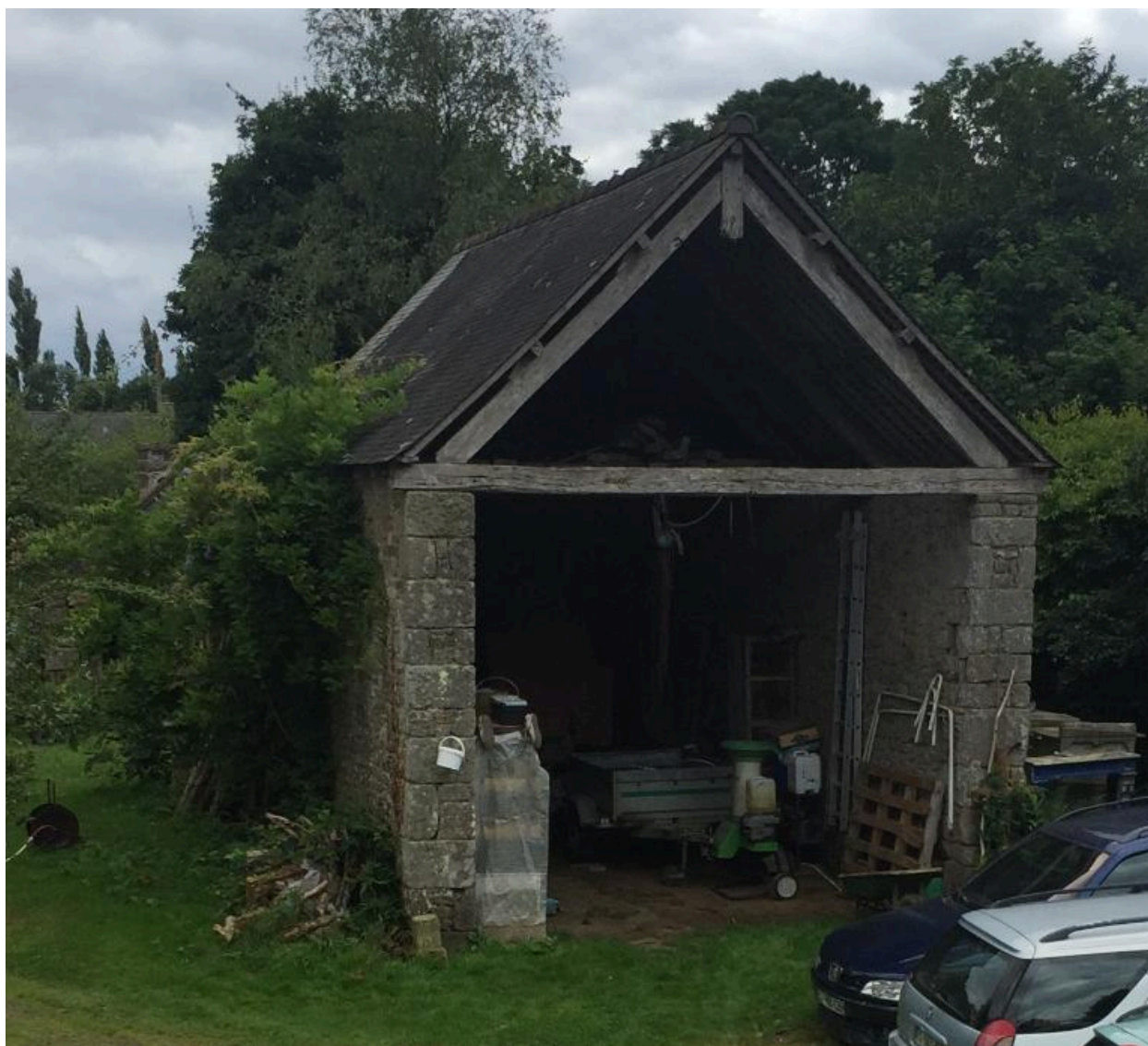
Remise, pignon nord
