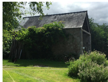
Remise du manoir des Murs Phot. Fadila Hamelin IVR53_20212265754NUCA
