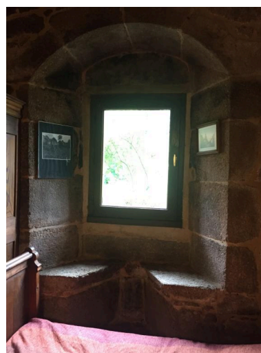
Fenêtre avec coussièges Phot. Fadila Hamelin IVR53_20212265757NUCA
