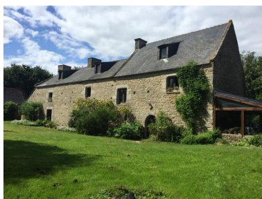
Manoir des Murs, façade sud Phot. Fadila Hamelin IVR53_20212265750NUCA
