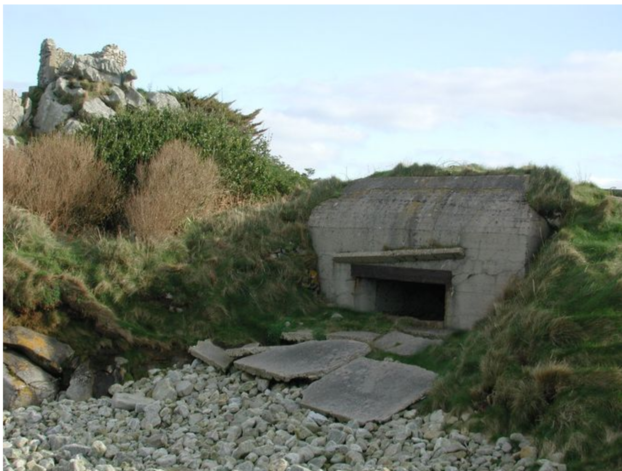
Vue générale de la casemate pour canon de 50 mm de la pointe de Perharidi
