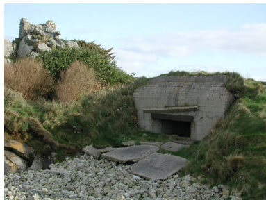
Vue générale de la casemate pour canon de 50 mm de la pointe de Perharidi Phot. Guillaume Lécueillier IVR53_20022901702NUCA
