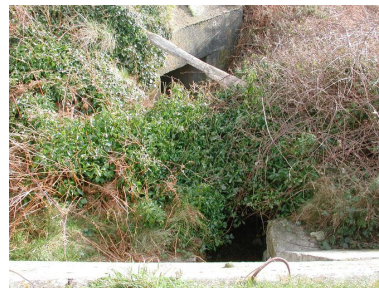
Vue générale du passage entre la casemate et l'abri type tôle métro de la pointe de Perharidi Phot. Guillaume Lécueillier IVR53_20022901710NUCA
