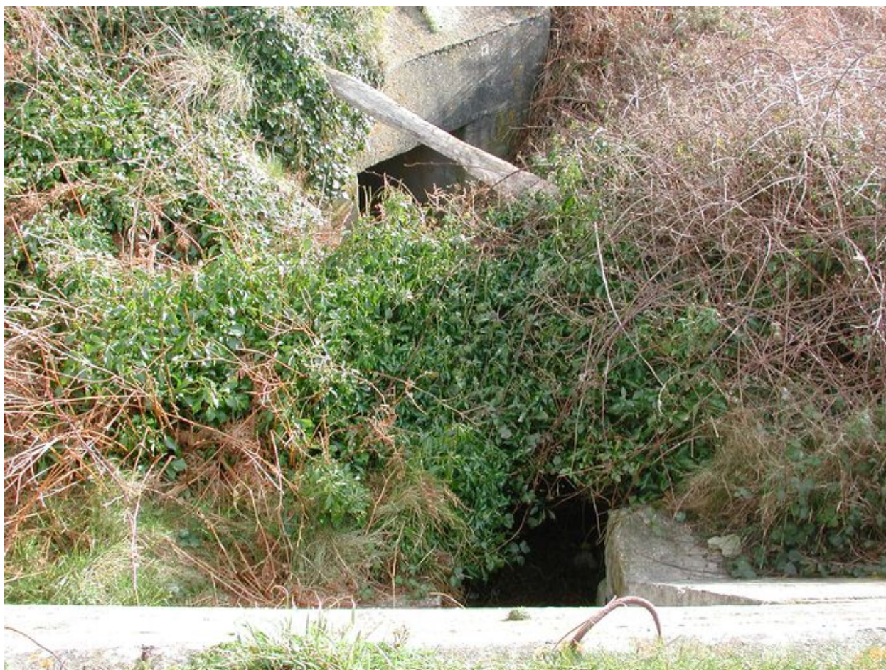
Vue générale du passage entre la casemate et l'abri type tôle métro de la pointe de Perharidi
