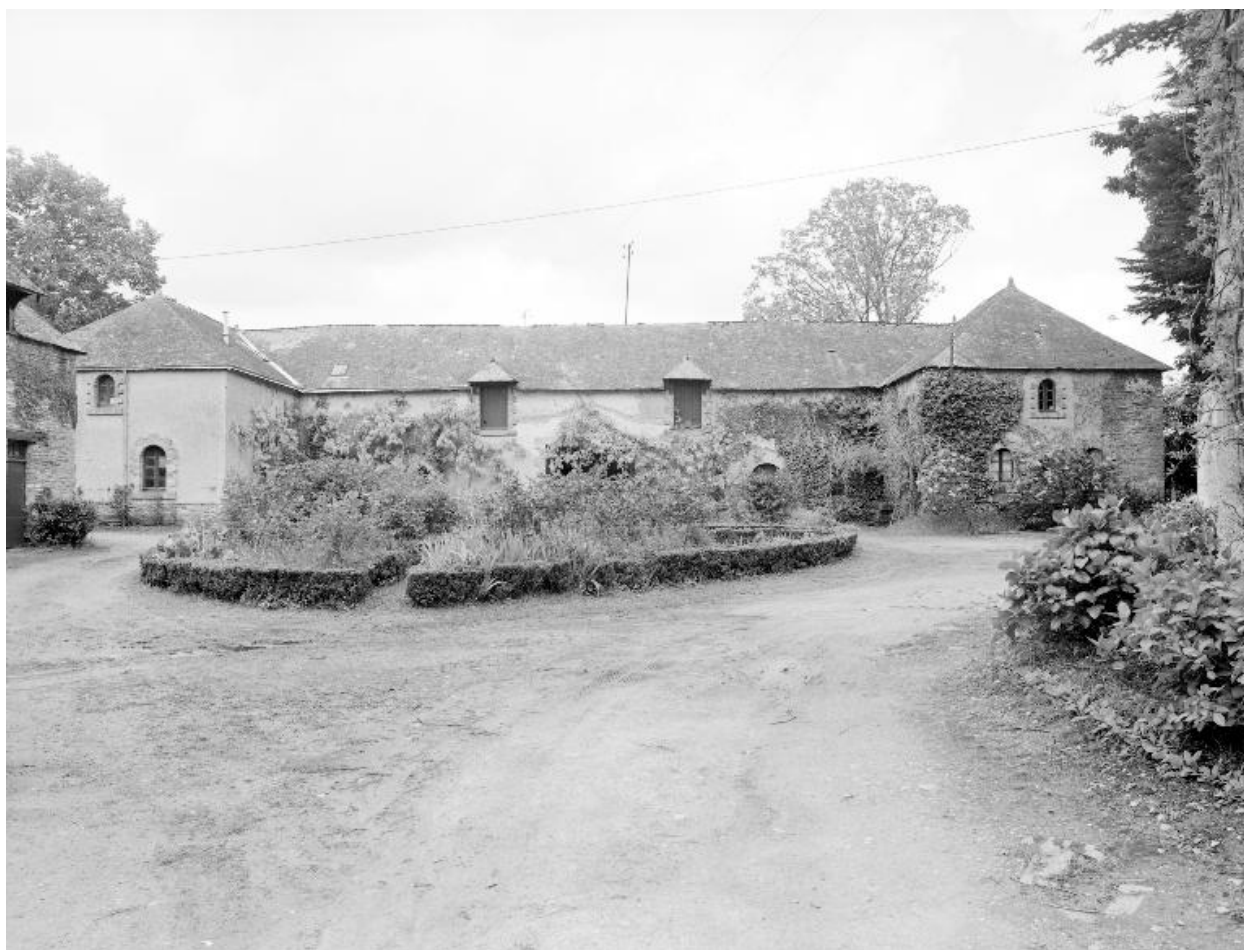
Château : les communs vus du sud (état en 1983)
