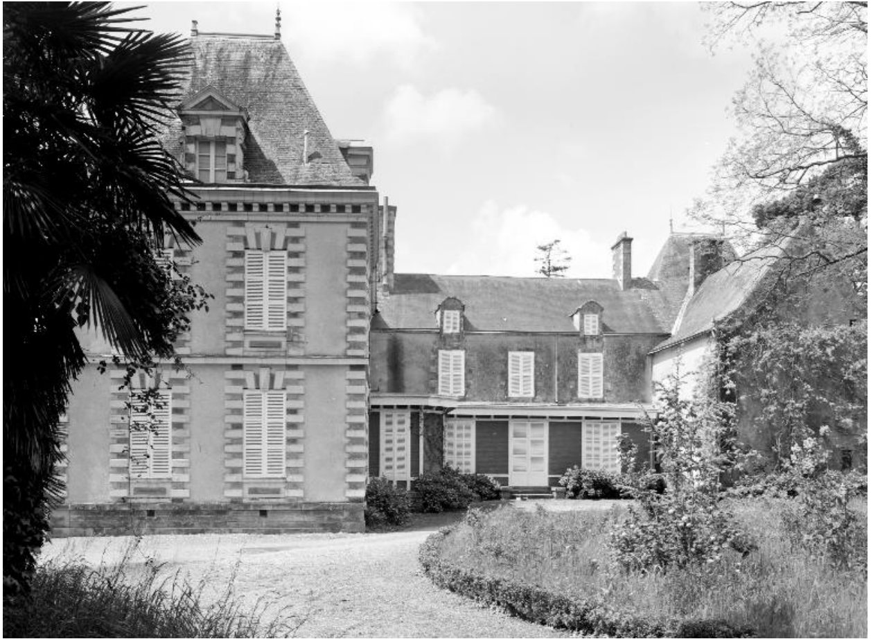
Château : vue générale prise de l'ouest (état en 1983)
