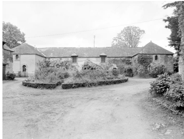
Château : les commons vus du sud (état en 1983) Phot. Norbert Lambart IVR53_19835600803X
