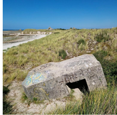
Vue générale depuis l'ouest. Envahi par le sable, le bunker subit le mouvement des dunes Phot. Guillaume Lécueillier IVR53_20252910489NUCA
