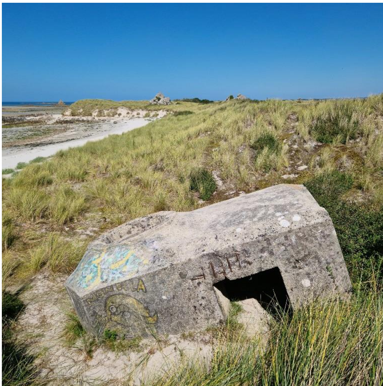
Vue générale depuis l'ouest. Envahi par le sable, le bunker subit le mouvement des dunes
