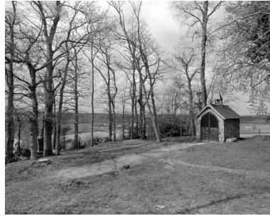
Elévation Ouest : vue de situation Phot. Bernard Bègne, Phot. M. Loyon IVR53_19933500366X
