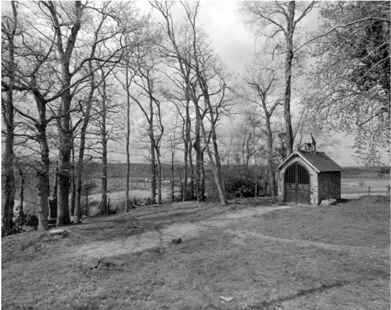
Elévation Ouest : vue de situation
