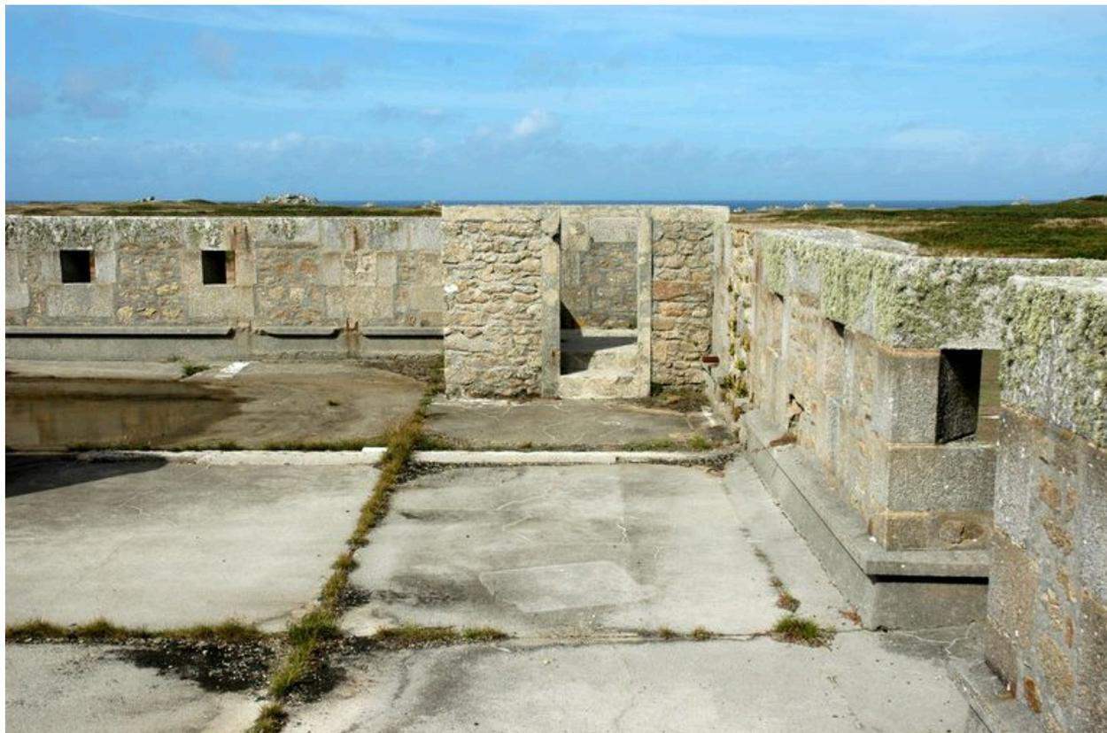
Vue du réduit de batterie de côte de Loqueltas. La terrasse est dotée de huit bretèches et créneaux de fusillade. Un poste d'observation et de mitrailleuse en maçonnerie a été construit par l'occupant
