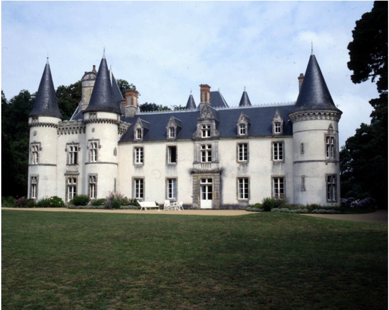
Château, élévation sud.
