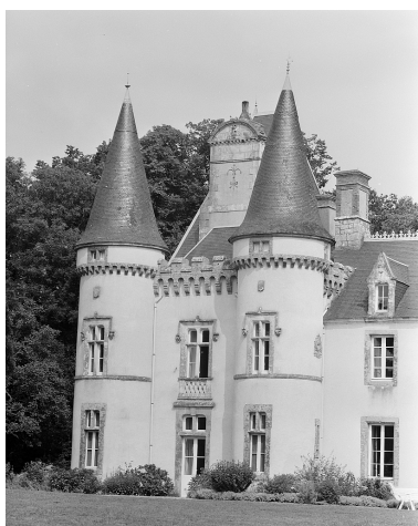
Elévation sud, partie ouest, vue sud-est. Phot. Guy Artur, Phot. Norbert Lambart IVR53_19935601801X
