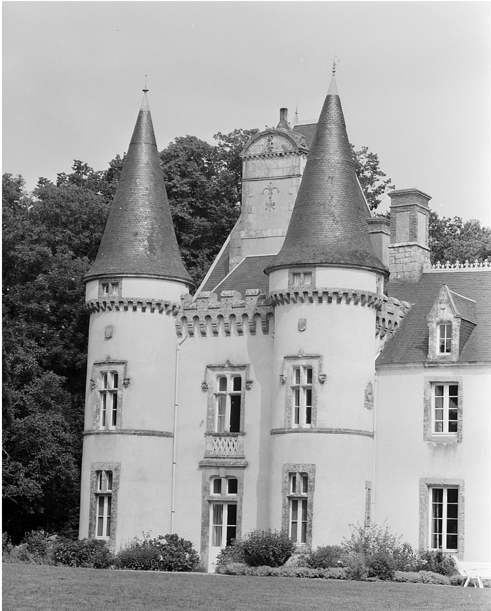
Elévation sud, partie ouest, vue sud-est.
