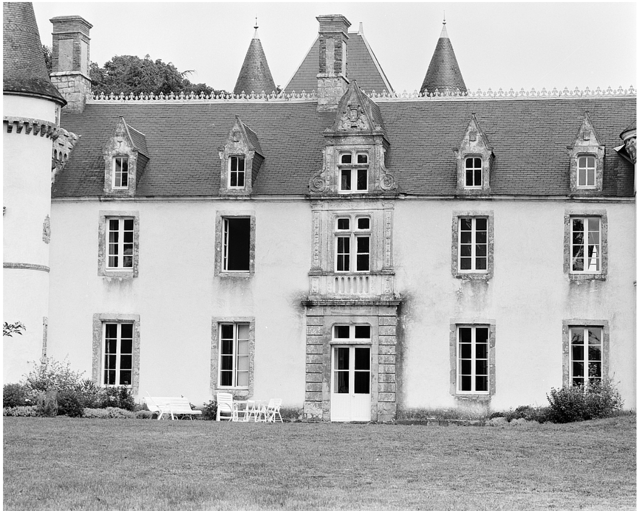
Elévation sud, partie partie centrale.
