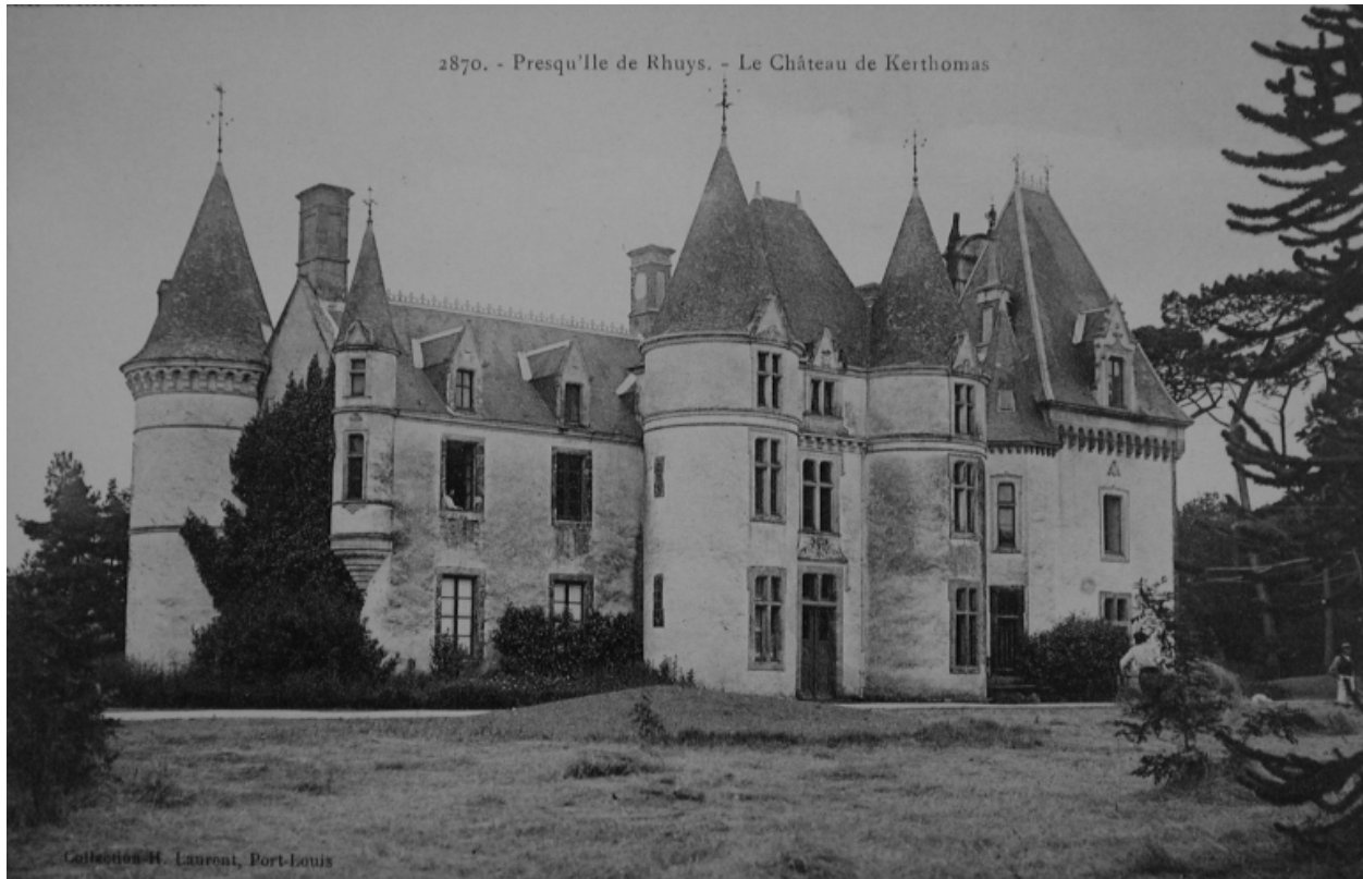
Vue de la façade antérieure
