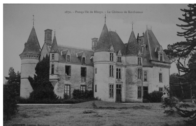
Vue de la façade antérieure Phot. Elise Lauranceau, Autr. Henri Laurent IVR53_20035604291NUCB
