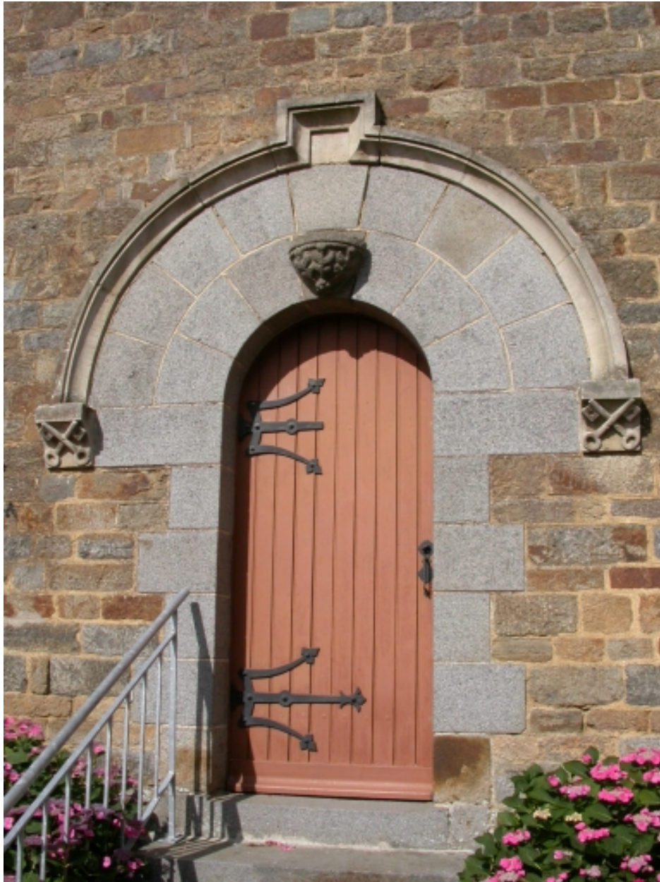
Elévation est : détail de la porte avec socle de statue en réemploi de l'ancienne église
