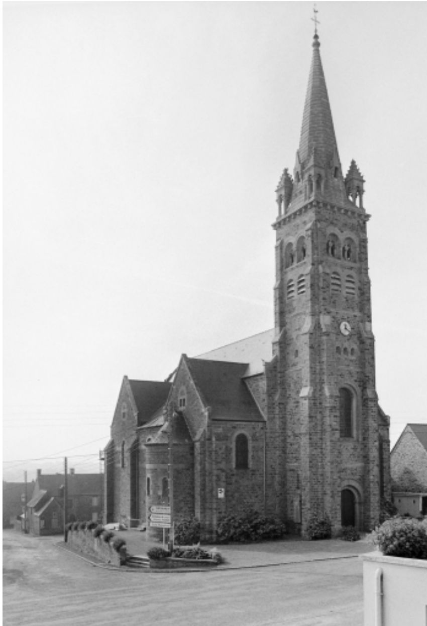
Elévation nord-est : vue générale
