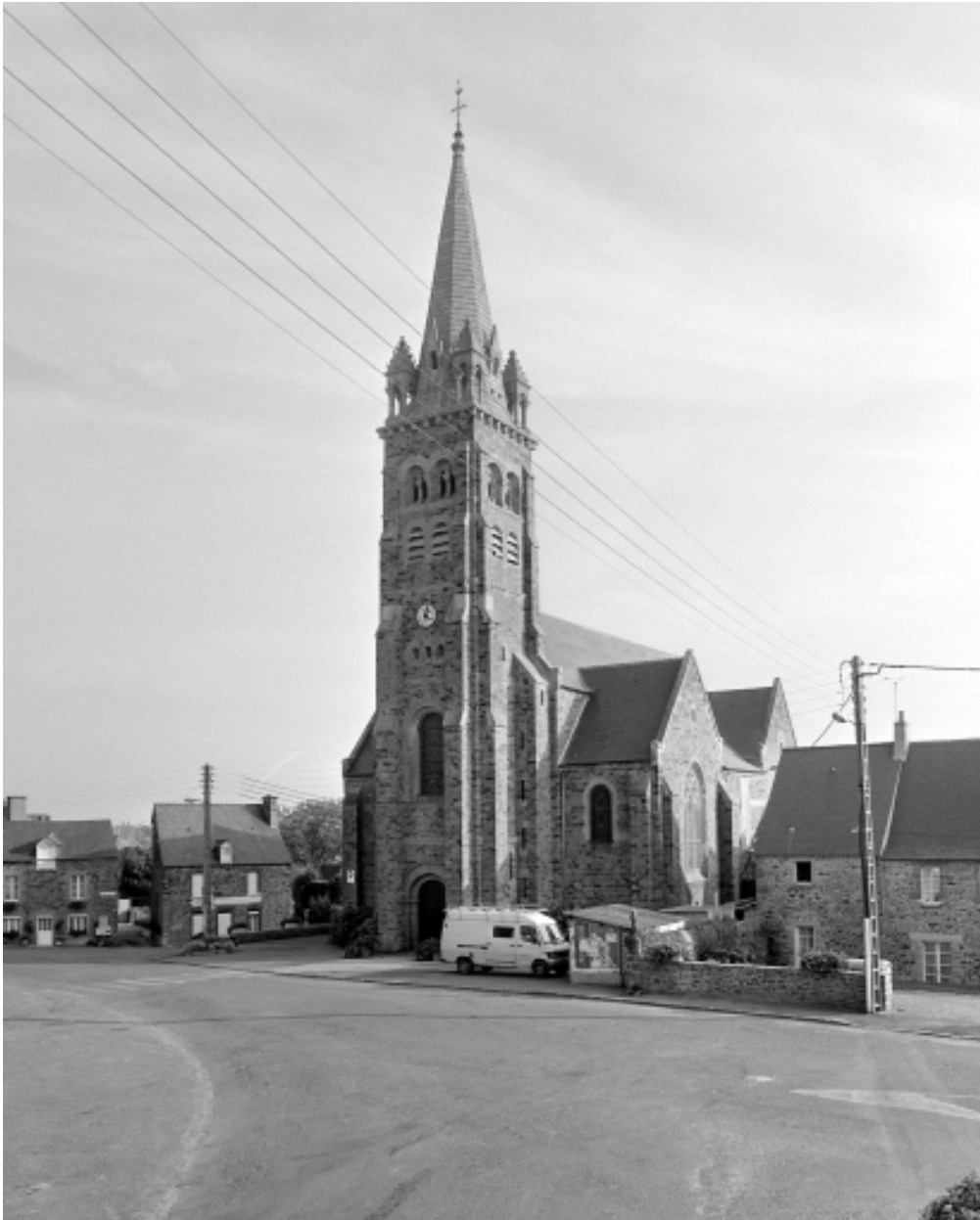
Elévation nord-ouest : vue générale
