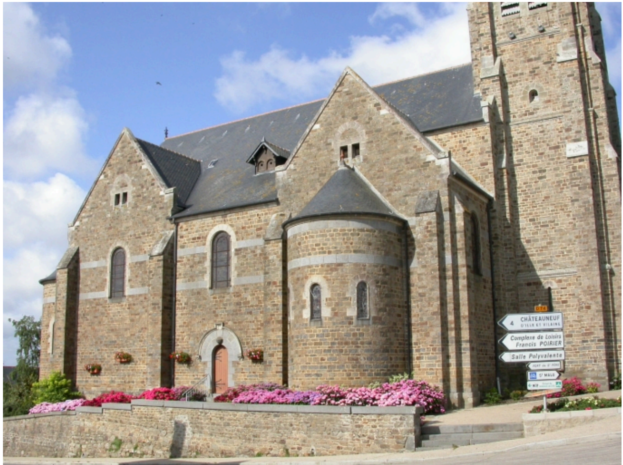
Vue générale de l'élévation est
