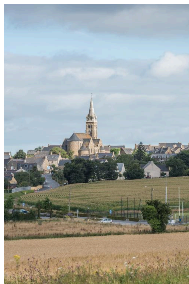
Vue de situation dans le bourg depuis le sud Phot. Charlotte Barraud IVR53_20203500588NUCA
