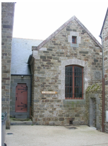
Vue de l'élévation nord de la sacristie Phot. Sabrina Dalibard IVR53_20063515437NUCA
