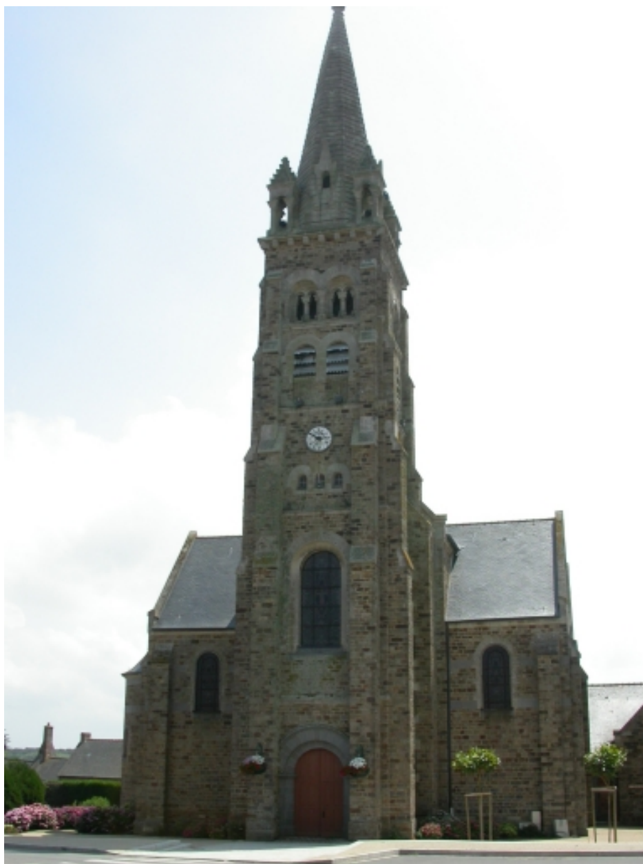
Vue générale de l'élévation nord
