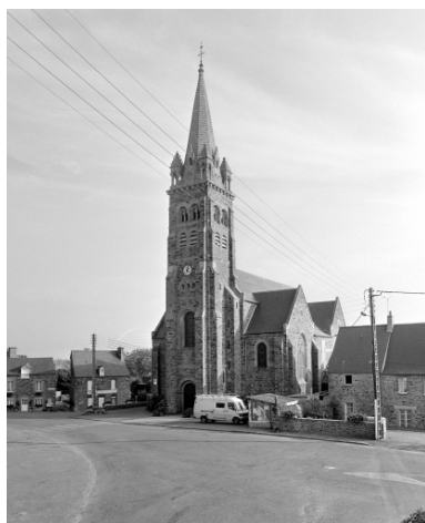
Elévation nord-ouest : vue générale Phot. Guy Artur, Phot. Norbert Lambart IVR53_19943502174X
