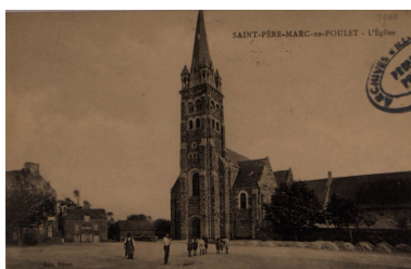
Elévation nord-ouest : vue générale Repro. A. Ganne IVR53_20063515374NUCB
