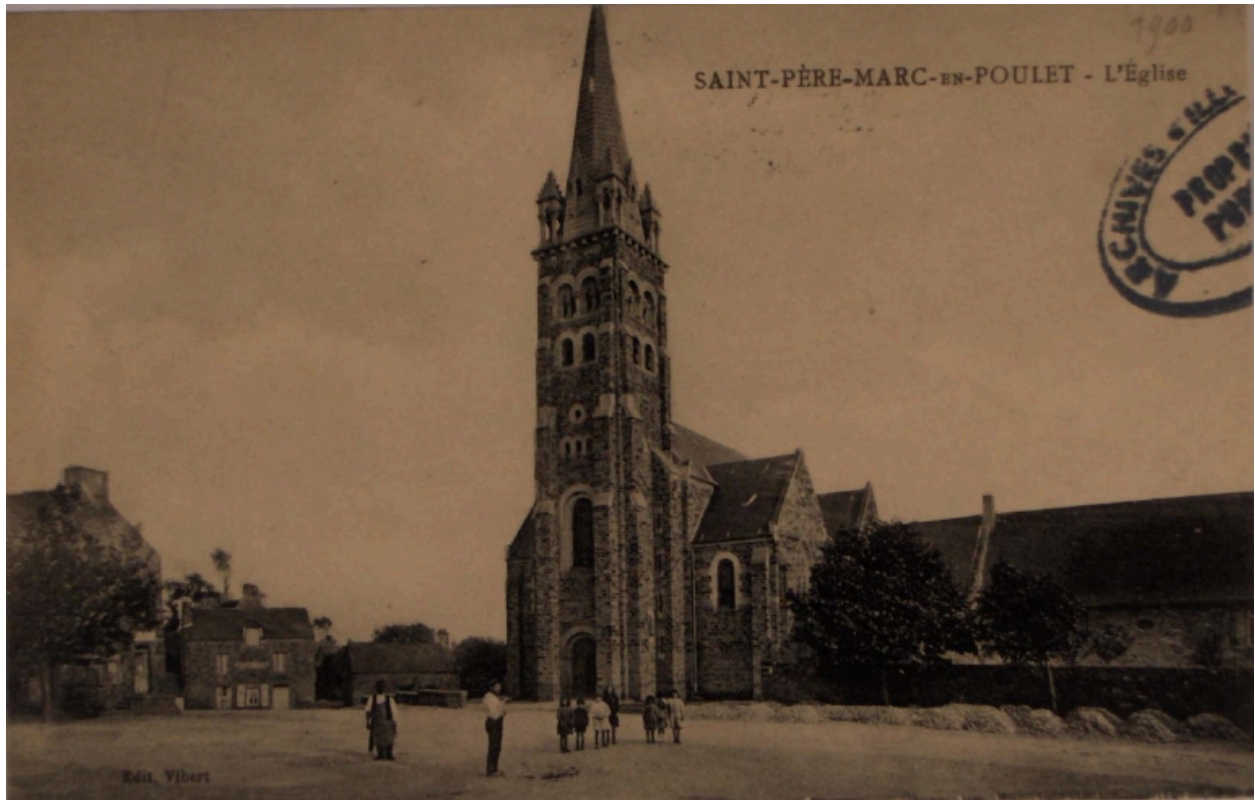
Elévation nord-ouest : vue générale
