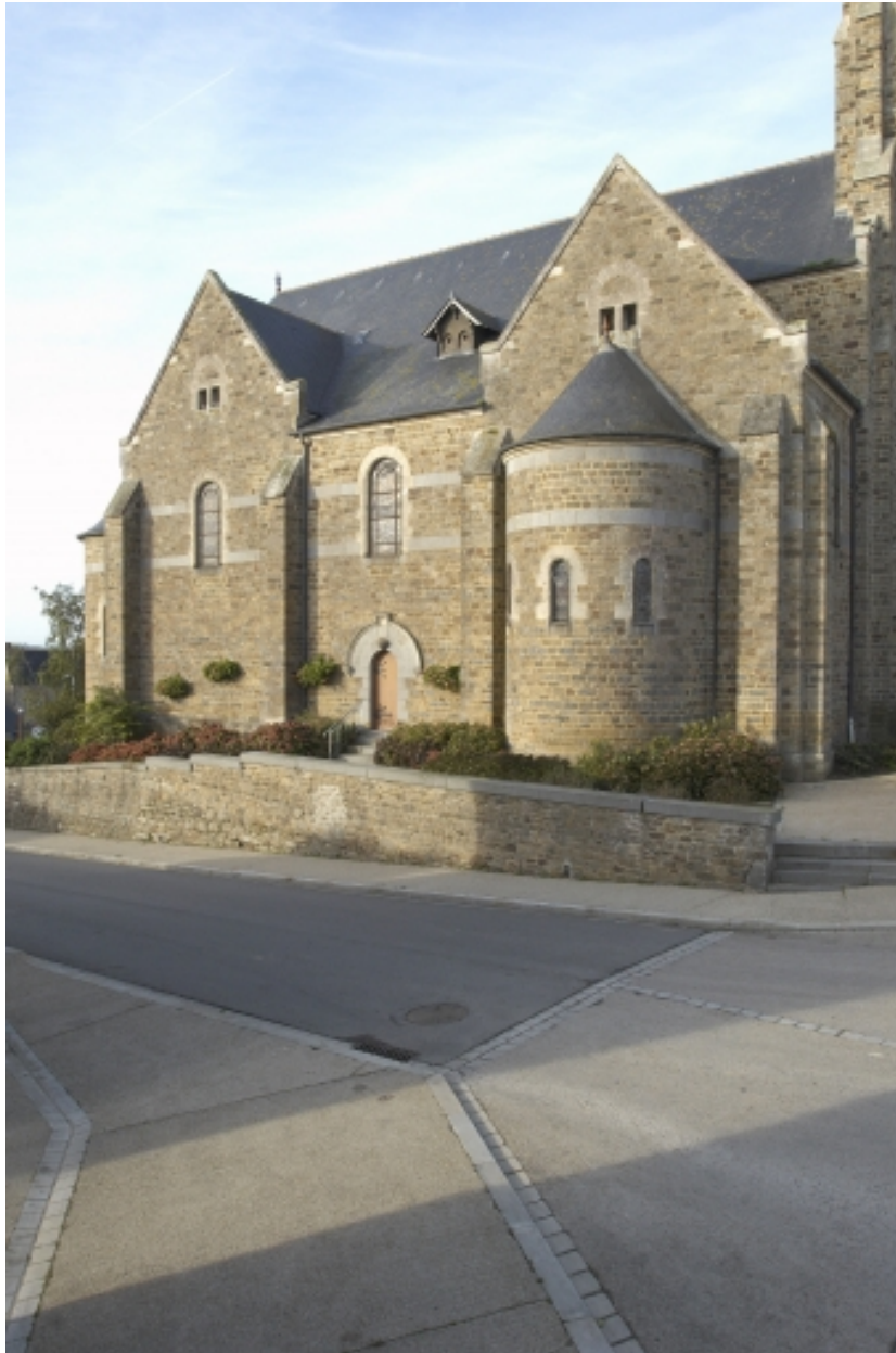
Vue générale de l'élévation est
