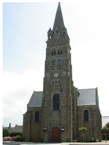
Vue générale de l'élévation nord Phot. Sabrina Dalibard IVR53_20063515432NUCA
