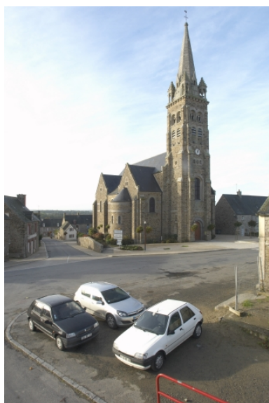
Vue de 3/4 des élévations nord et est Phot. Norbert Lambart IVR53_20063502151NUCA
