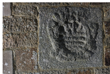
Elévation nord de la sacristie : détail d'un blason en réemploi de l'ancienne église Phot. Bernard Bègne IVR53_20063502418NUCA
