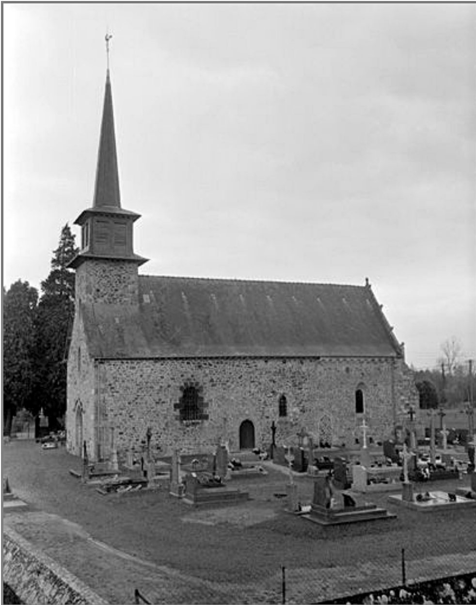
Elévation Sud : vue générale
