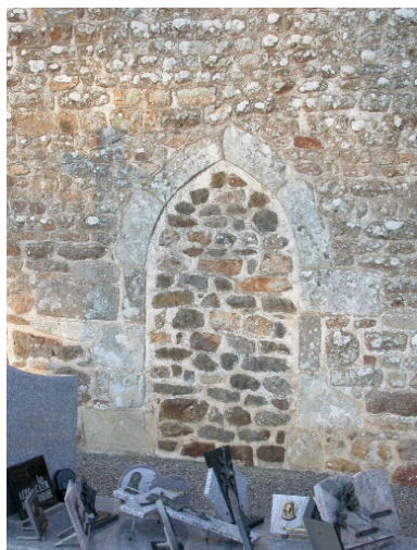
Porte murée sur le mur sud Phot. Sabrina Dalibard IVR53_20053520571NUCA
