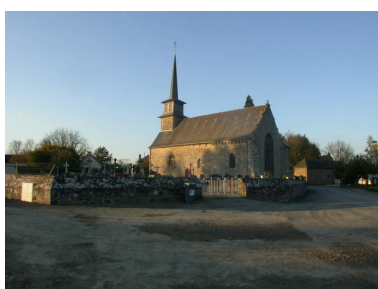
Vue sud-est Phot. Sabrina Dalibard IVR53_20053520569NUCA
