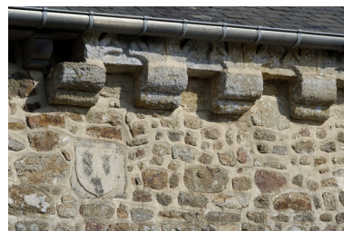
Détail de la corniche Phot. Bernard Bègne IVR53_20053502782NUCA
