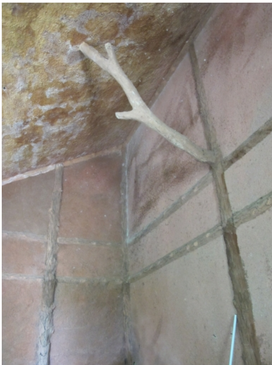
Pavillon de chasse, détail de la mise en oeuvre
