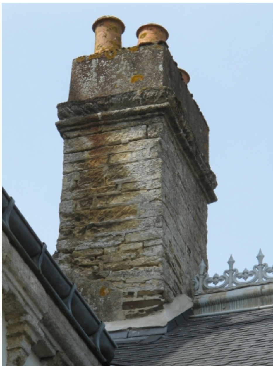
Souche de cheminée en calcaire des faluns
