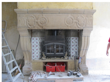
Cheminée du rez-de-chaussée Phot. Véronique Orain IVR53_20112206590NUCA
