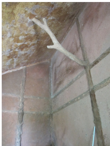
Pavillon de chasse, détail de la mise en oeuvre Phot. Véronique Orain IVR53_20112206626NUCA
