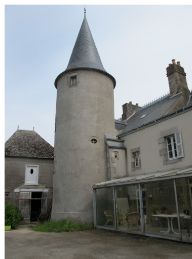
Logis, vue arrière Phot. Véronique Orain IVR53_20112206628NUCA
