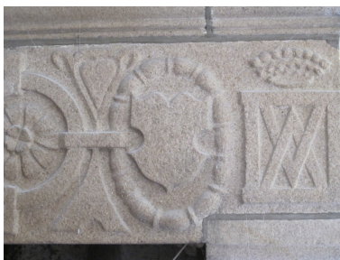
Cheminée du rez-de-chaussée, détail Phot. Véronique Orain IVR53_20112206589NUCA
