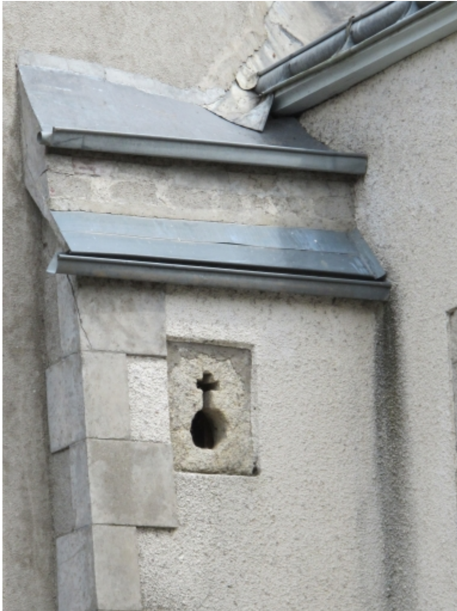
Logis, vue arrière, détail, bouche à feu
