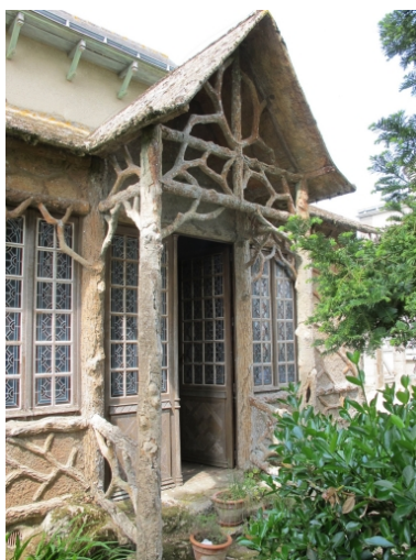
Pavillon de chasse, détail Repro. Véronique Orain IVR53_20112206623NUCA
