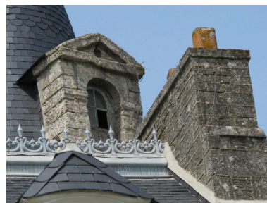
Lucarne de la tour d'escalier arrière Phot. Véronique Orain IVR53_20112206634NUCA
