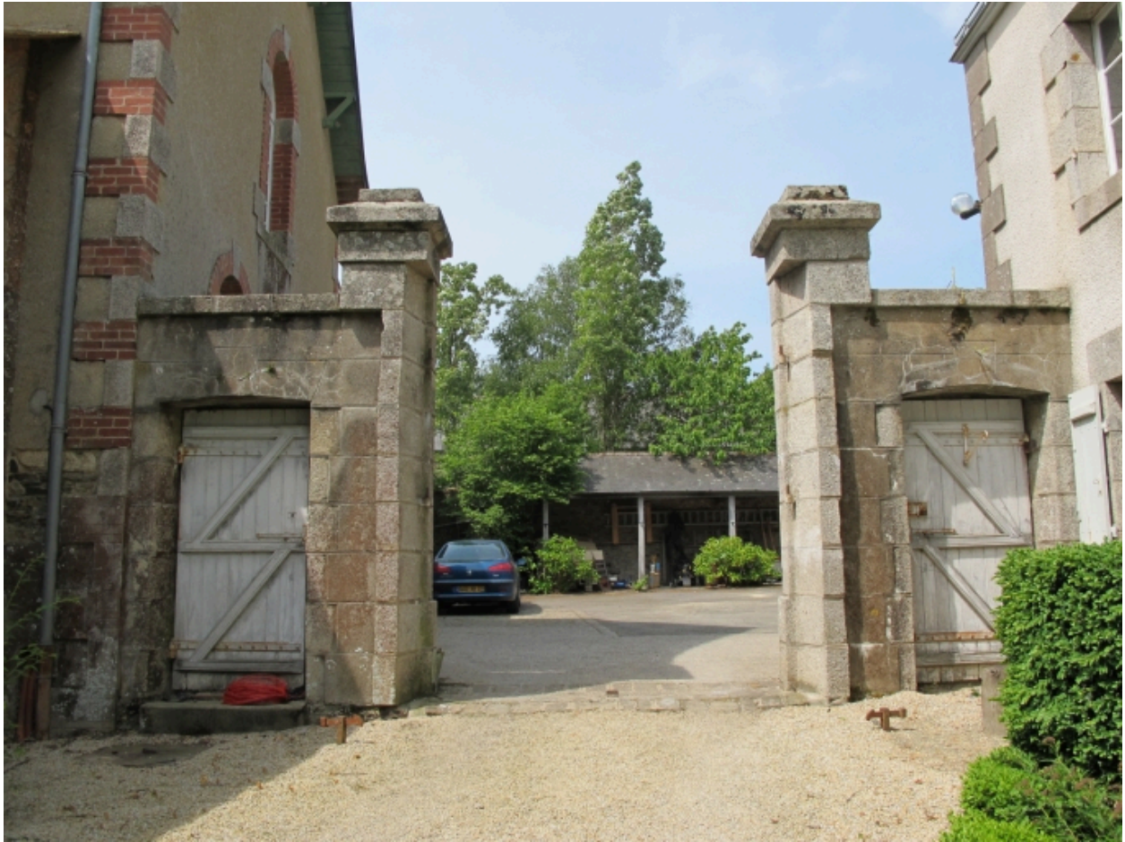
Portail de séparation avec la cour arrière
