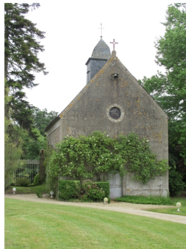
Chapelle, façade principale orientée vers le nord Phot. Véronique Orain IVR53_20112206601NUCA
