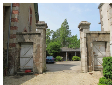
Portail de séparation avec la cour arrière Repro. Véronique Orain IVR53_20112206629NUCA
