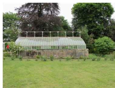
Serre de jardin, vue générale Phot. Véronique Orain IVR53_20112206599NUCA
