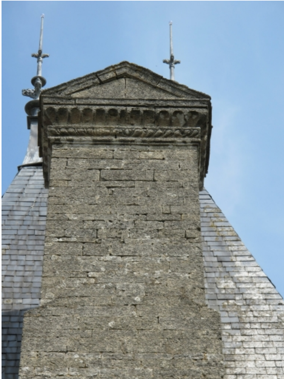
Souche de cheminée en calcaire des faluns
