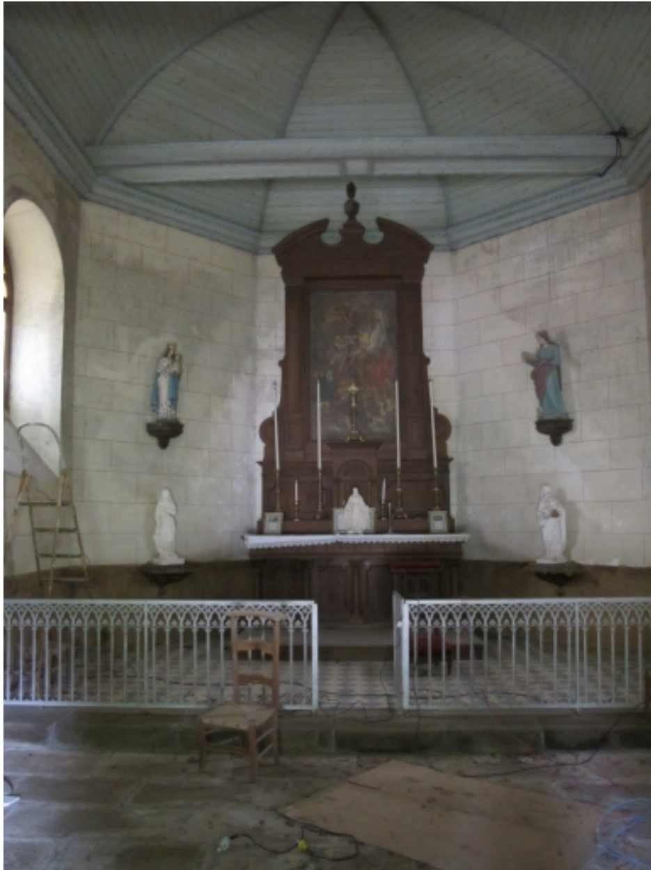
Chapelle, vue intérieure
