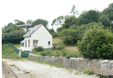
Vue générale de la maison du gardien du four à chaux Phot. Lénaïg L'Aot IVR53_20072908937NUCA
