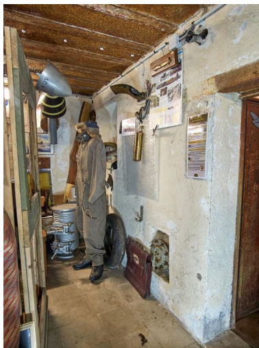
Vue intérieure : au raz du sol, bouche de suppression à clapet à contrepoids. Au fond, poêle de type HAAS Wt 80K (rapporté).
