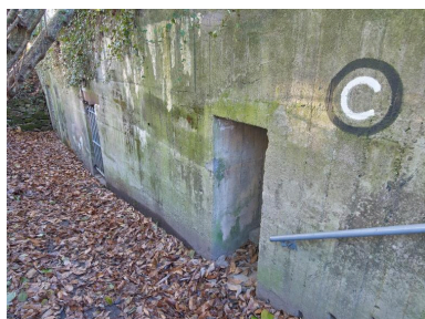
Vue de l'élévation sud : la première porte dessert le poste d'observation dit Tobruk ; les deux autres portes le sas d'entrée et l'abri
