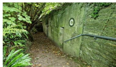
Vue de l'élévation sud : la première porte dessert le poste d'observation dit Tobruk ; les deux autres portes le sas d'entrée et l'abri
