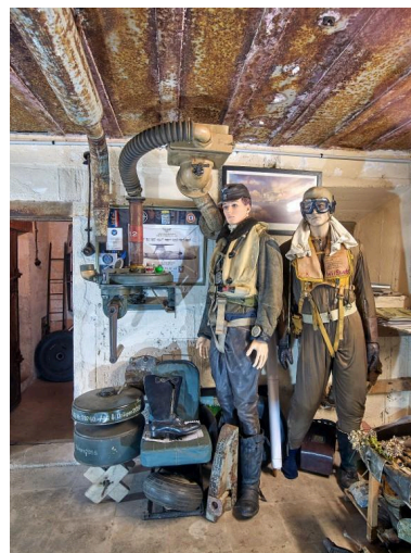
Vue intérieure : système de ventilation et de filtration avec ventilateur de 1,2 m3, filtre dépoussiéreur et tuyauterie d'origine en place (les filtres, posés au sol, sont rapportés). Dans ce bunker-musée, la thématique est l'aéronautique Phot. Bernard Bègne IVR53_20255600868NUCA
