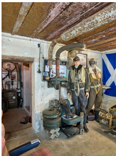
Vue intérieure : système de ventilation et de filtration avec ventilateur de 1,2 m3, filtre dépoussiéreur et tuyauterie d'origine en place (les filtres, posés au sol, sont rapportés). Dans ce bunker-musée, la thématique est l'aéronautique Phot. Bernard Bègne IVR53_20255600874NUCA
