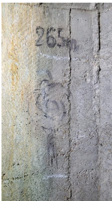
Vue intérieure du poste d'observation. Sur le mur est peint un panorama de tir : l'arbre servant de point de repère se trouve à 265 m de distance Phot. Guillaume Lécueillier IVR53_20255632995NUCA
