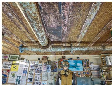
Vue intérieure : tuyauterie d'origine du système de ventilation et de filtration (la couleur bleu est d'origine). Dans ce bunker-musée, la thématique est l'aéronautique
