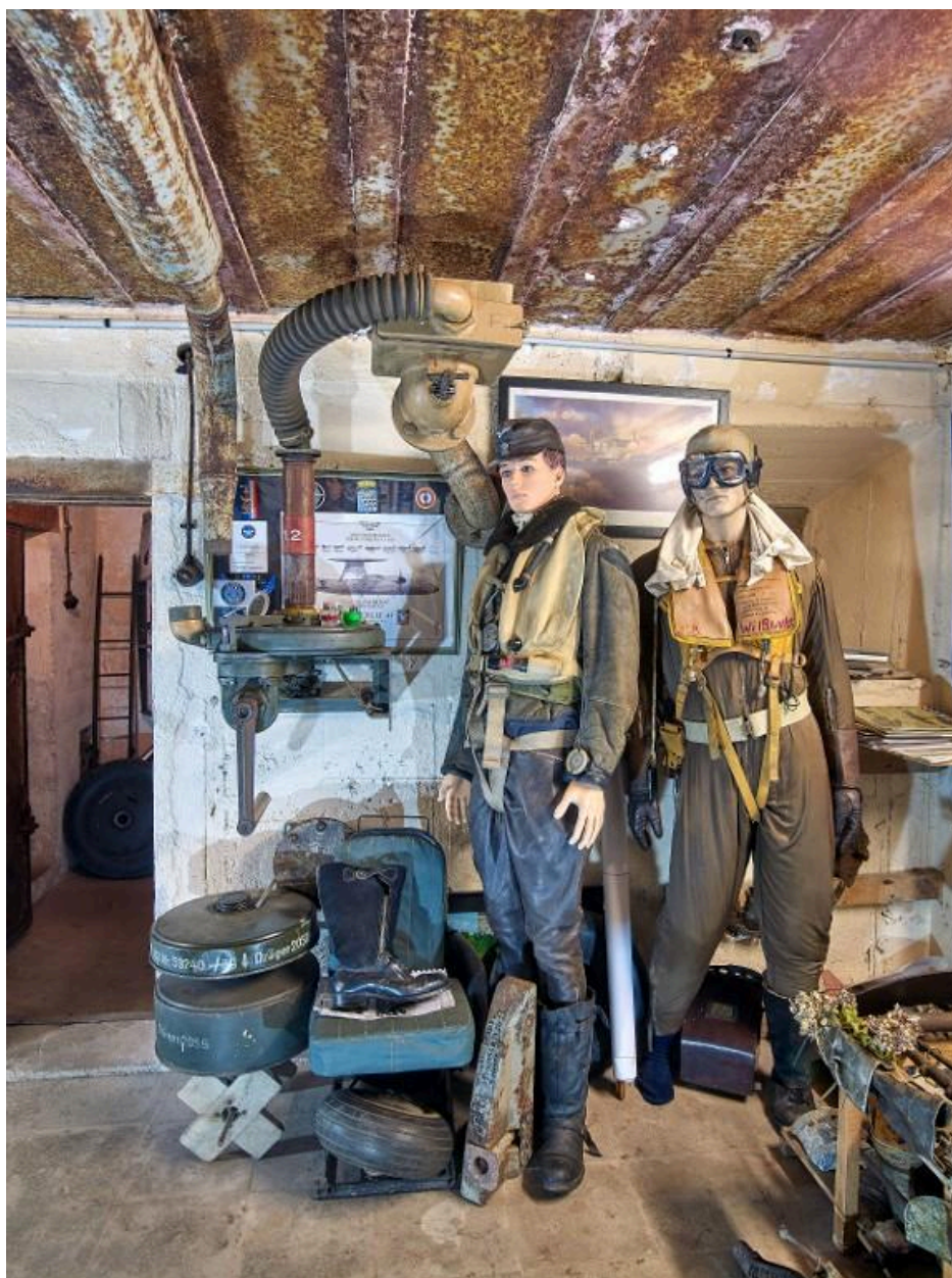
Vue intérieure : système de ventilation et de filtration avec ventilateur de 1,2 m3, filtre dépoussiéreur et tuyauterie d'origine en place (les filtres, posés au sol, sont rapportés). Dans ce bunker-musée, la thématique est l'aéronautique
