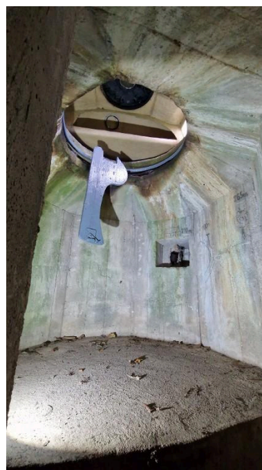
Vue intérieure du poste d'observation. Sur le mur est peint un panorama de tir. Dans la petite niche murale, se trouve un tuyau acoustique relié à la salle de garde. Une planchette pour mitrailleuse est reconstituée Phot. Lécueillier Guillaume IVR53_20255632990NUCA
