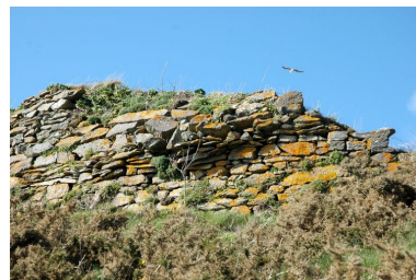
Vue de l'ensemble fortifié de Porsfeunteun : batterie de côte Phot. Guillaume Lécueillier IVR53_20062904700NUCA
