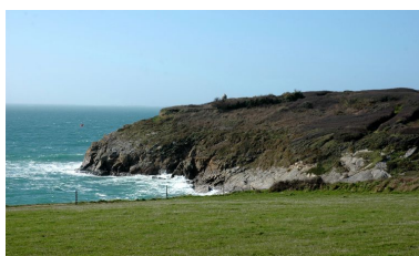
Vue générale de l'ensemble fortifié de Porsfeunteun : batterie de côte et guérite Phot. Guillaume Lécueillier IVR53_20062904678NUCA
