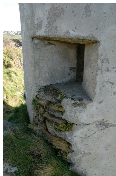
Vue de l'ensemble fortifié de Porsfeunteun : détail de la guérite de plan circulaire (moellons de granite avec enduit de ciment) Phot. Guillaume Lécueillier IVR53_20062904694NUCA
