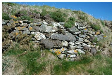
Vue de l'ensemble fortifié de Porsfeunteun : batterie de côte Phot. Guillaume Lécueillier IVR53_20062904710NUCA
