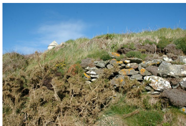
Vue de l'ensemble fortifié de Porsfeunteun : batterie de côte Phot. Guillaume Lécueillier IVR53_20062904711NUCA
