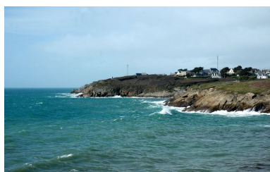
Vue générale des ensembles fortifiés de Porsfeunteun et de la pointe du Renard Phot. Guillaume Lécueillier IVR53_20062904677NUCA
