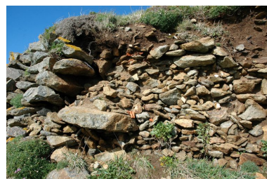
Vue de l'ensemble fortifié de Porsfeunteun : batterie de côte Phot. Guillaume Lécueillier IVR53_20062904709NUCA
