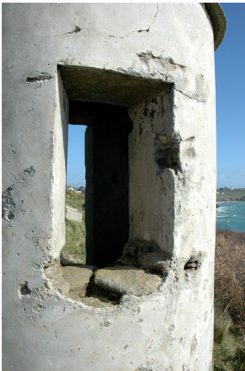
Vue de l'ensemble fortifié de Porsfeunteun : détail de la guérite de plan circulaire (moellons de granite avec enduit de ciment)
