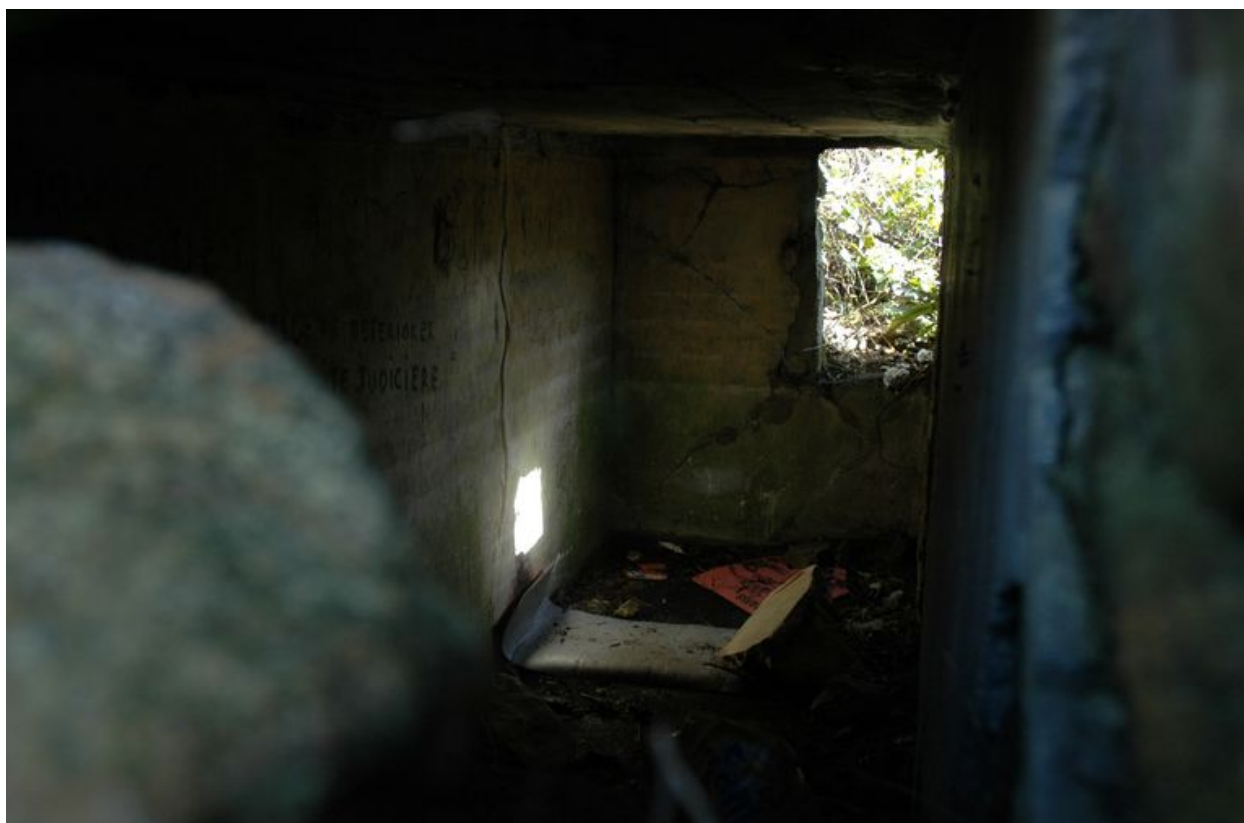
Vue de l'ensemble fortifié de Porsfeunteun : abri en béton armé
