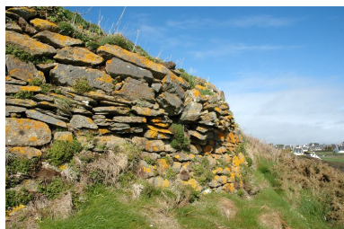
Vue de l'ensemble fortifié de Porsfeunteun : batterie de côte Phot. Guillaume Lécueillier IVR53_20062904701NUCA
