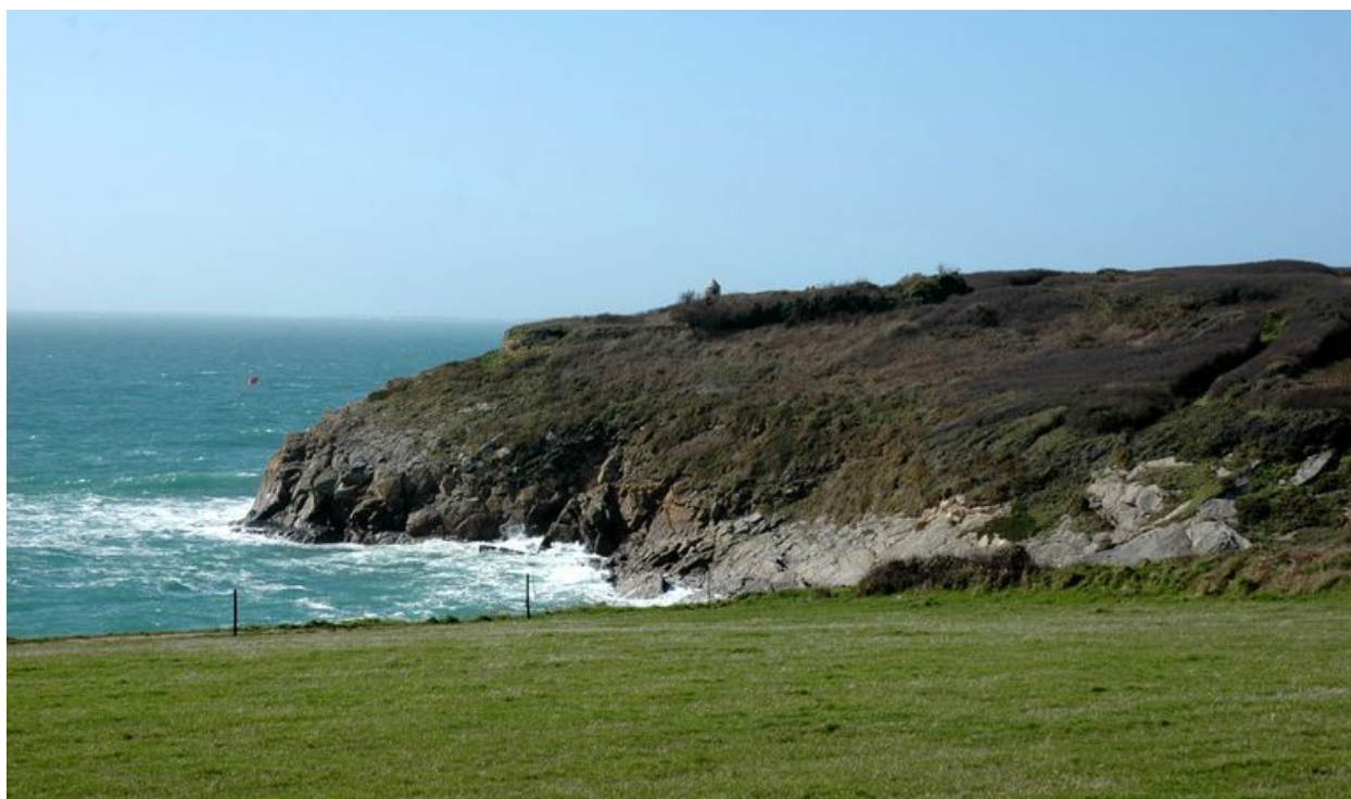
Vue générale de l'ensemble fortifié de Porsfeunteun : batterie de côte et guérite
