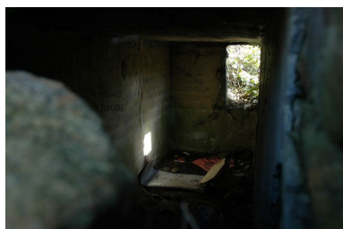
Vue de l'ensemble fortifié de Porsfeunteun : abri en béton armé Phot. Guillaume Lécueillier IVR53_20062904713NUCA
