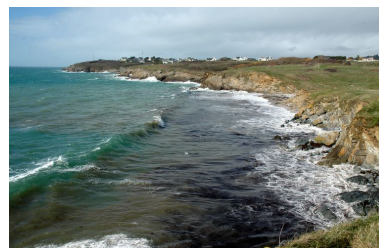
Vue générale des ensembles fortifiés de Porsfeunteun et de la pointe du Renard Phot. Guillaume Lécueillier IVR53_20062904676NUCA
