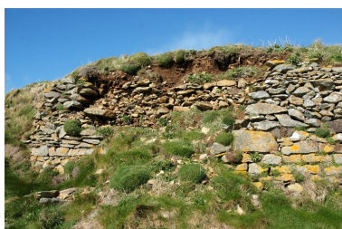
Vue de l'ensemble fortifié de Porsfeunteun : batterie de côte Phot. Guillaume Lécueillier IVR53_20062904705NUCA
