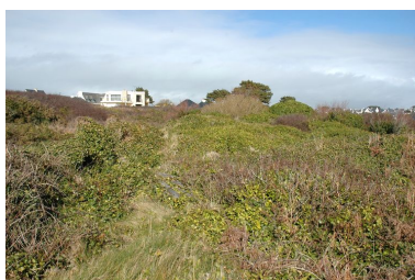
Vue de l'ensemble fortifié de Porsfeunteun : ouvrages allemands envahis par la végétation Phot. Guillaume Lécueillier IVR53_20062904687NUCA
