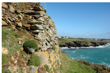
Vue de l'ensemble fortifié de Porsfeunteun : batterie de côte Phot. Guillaume Lécueillier IVR53_20062904707NUCA
