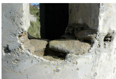
Vue de l'ensemble fortifié de Porsfeunteun : détail de la guérite de plan circulaire (moellons de granite avec enduit de ciment) Phot. Guillaume Lécueillier IVR53_20062904692NUCA
