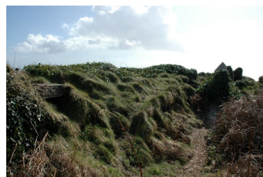
Vue de l'ensemble fortifié de Porsfeunteun : ouvrages allemands envahis par la végétation Phot. Guillaume Lécueillier IVR53_20062904685NUCA
