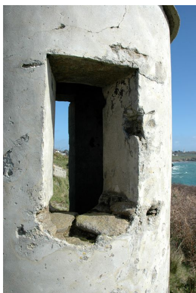
Vue de l'ensemble fortifié de Porsfeunteun : détail de la guérite de plan circulaire (moellons de granite avec enduit de ciment) Phot. Guillaume Lécueillier IVR53_20062904693NUCA
