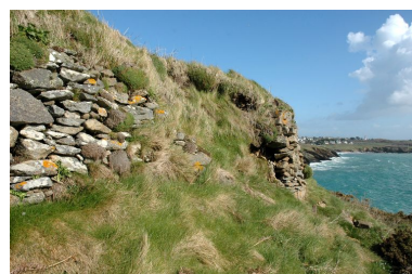
Vue de l'ensemble fortifié de Porsfeunteun : batterie de côte Phot. Guillaume Lécueillier IVR53_20062904706NUCA
