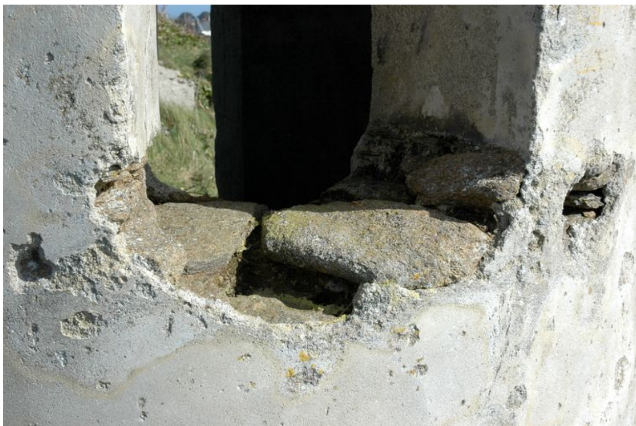
Vue de l'ensemble fortifié de Porsfeunteun : détail de la guérite de plan circulaire (moellons de granite avec enduit de ciment)
