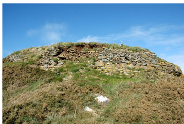
Vue de l'ensemble fortifié de Porsfeunteun : batterie de côte Phot. Guillaume Lécueillier IVR53_20062904702NUCA
