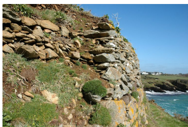
Vue de l'ensemble fortifié de Porsfeunteun : batterie de côte Phot. Guillaume Lécueillier IVR53_20062904708NUCA
