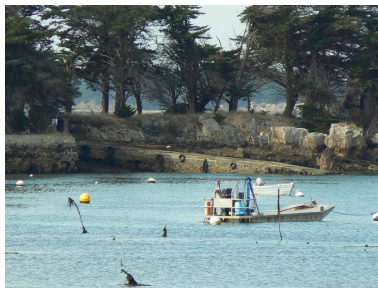
Vue générale de la cale de l'île de Boëdic Phot. Johan Vincent IVR53_20075605747NUCA
