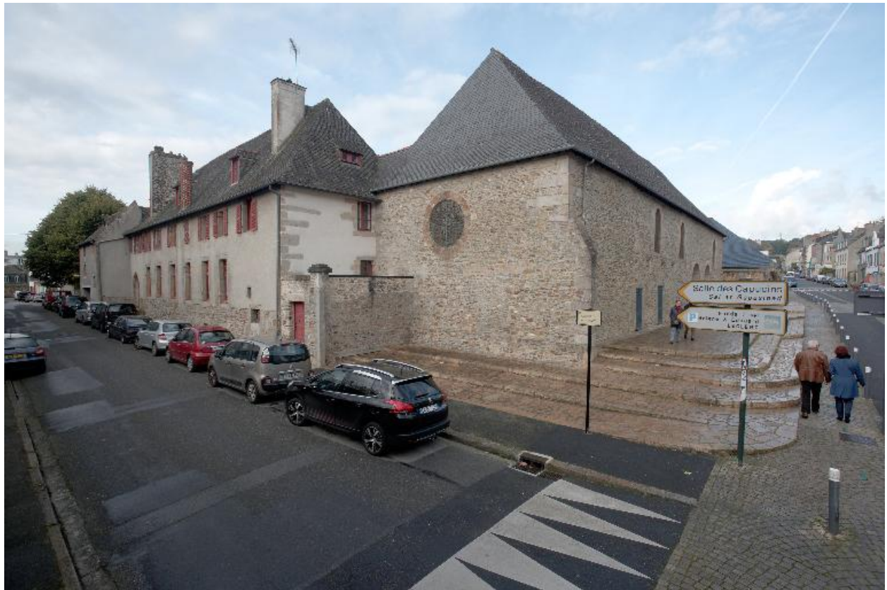
Vue générale sud-est du couvent des Capucins
