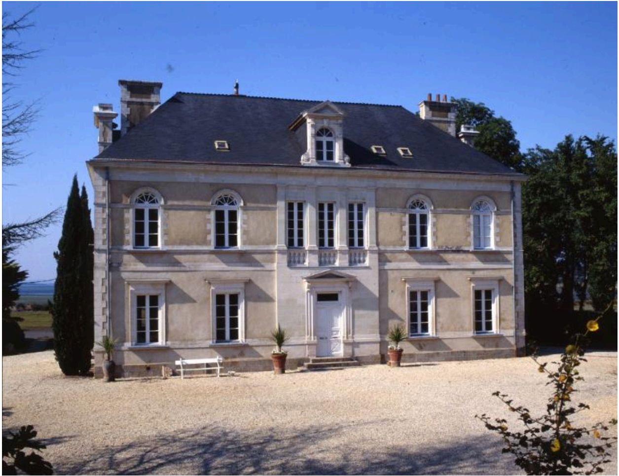
Vue générale de la façade sud
