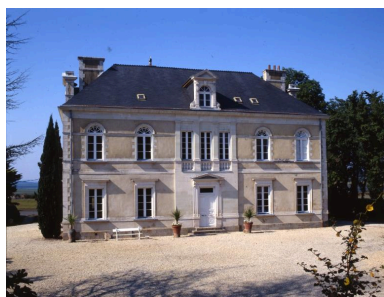
Vue générale de la façade sud Phot. Guy Artur, Phot. Norbert Lambart IVR53_19935601907XA
