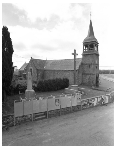
Vue générale nord-ouest Repro. Guy Artur, Repro. Norbert Lambart IVR53_19943500612X
