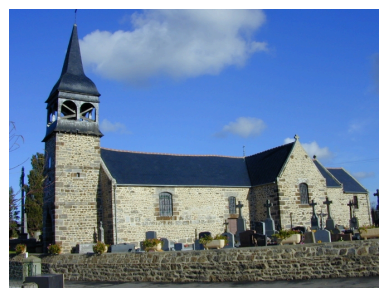
Vue générale sud-ouest Phot. Xavier Gilbert IVR53_20013517548NUCA
