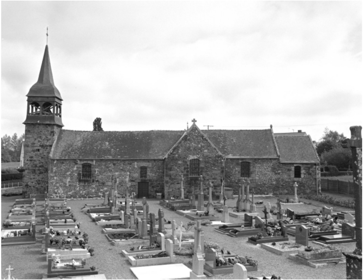
Vue générale sud
