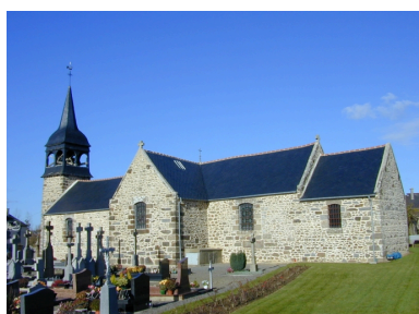
Vue générale sud-est Phot. Xavier Gilbert IVR53_20013517549NUCA
