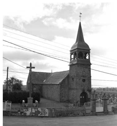
Vue générale nord-ouest Phot. Guy Artur, Phot. Norbert Lambart IVR53_19943500611X
