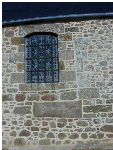
Reprise de l'ancienne fenêtre du choeur : vue générale sud-est Phot. Xavier Gilbert IVR53_20013517552NUCA
