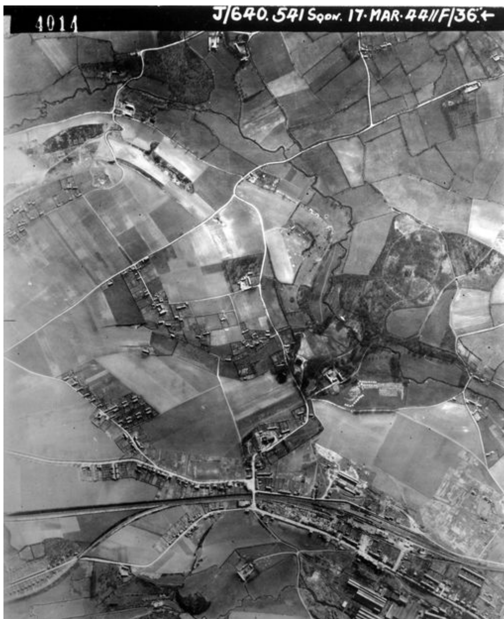
Vue aérienne verticale de la base de V3 de Mimoyecques, 17 mars 1944. (Ministry of Defense, Air Force Departement Photograph, Université de Keele)
